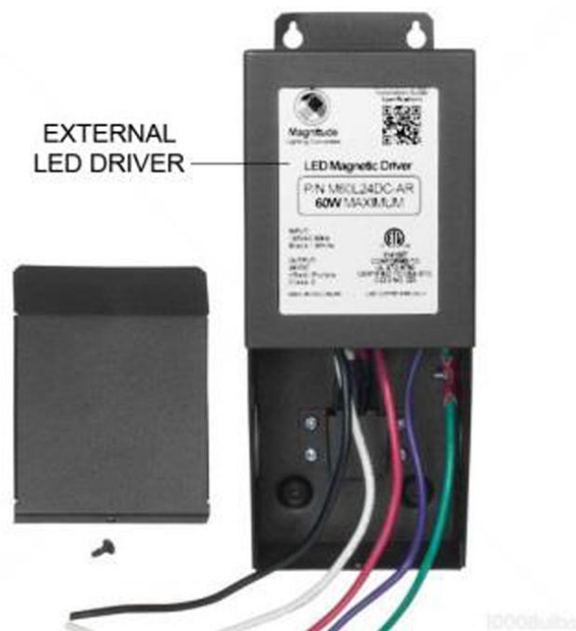
Εικόνα 15 - LED Driver Εξωτερικού τύπου
