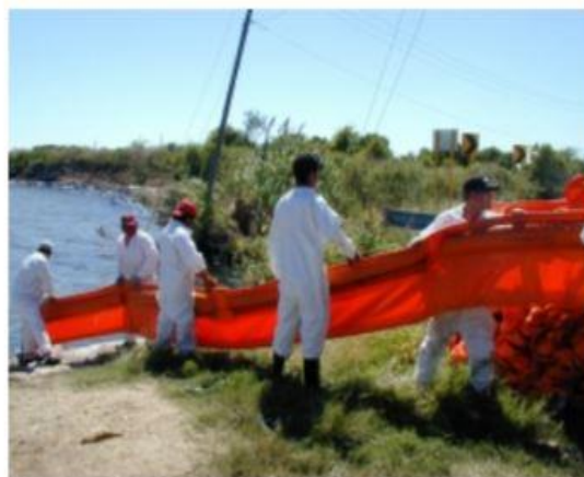
Εικόνα 1.9 - Περιορισμός επιπλέοντος πετρελαίου αριστερά και δεξιά Booms για χρήση πλησίον των ακτών (Καλογεράκης, 2013).
