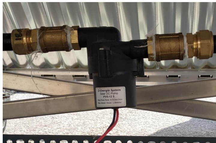
Figure 2.53: Αντλία ανακυκλοφορίας στο σύστημα
