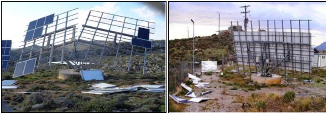
Φωτ. Νο 1&2 (Κατεστραμμένο φ/β tracker από ακραία καιρικά φαινόμενα)
