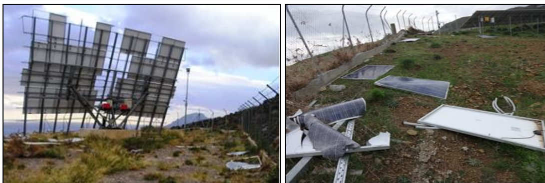
Φωτ. Νο 3&4 (Κατεστραμμένο φ/β tracker από ακραία καιρικά φαινόμενα)
