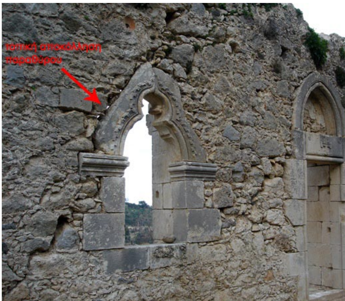
ΕΙΚΟΝΑ 110. Εξωτερική άποψη του δυτικού ανοίγματος στον νότιο τοίχο του Αγ Αντωνίου όπου σημειώνεται με κόκκινο βέλος η κύρια διαμπερης ρωγμή και η τοπική αποκόλληση του ενός λίθου που αποτελεί το ανώφλι εξωτερικά του ανοίγματος αυτού από την κυρίως αργολιθοδομή.
