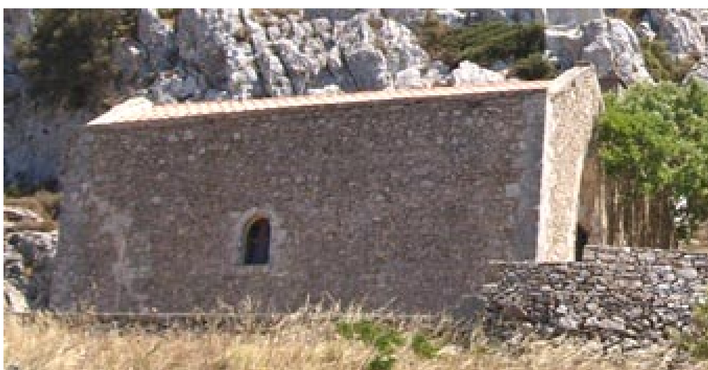
ΕΙΚΟΝΑ 28. Βόρεια άποψη του ναού. Διακρίνεται το ελαφρώς οξυκόρυφο τυπικό άνοιγμα στην βόρεια φέρουσα τοιχοποιία καθώς και λοξή ρηγμάτωση με κατεύθυνση από ανατολικά προς τα δυτικά στην ΒΑ γωνία του κτίσματος (φωτογραφία από προσωπικό αρχείο)
