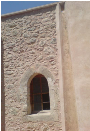
ΕΙΚΟΝΑ 42. Παράθυρο νότιας όψης, τυπικής οξυκόρυφης γεωμετρίας πλησίον κατακόρυφα διαμορφωμένης υδρορροής για την απορροή των ομβρίων (αριστερά)
