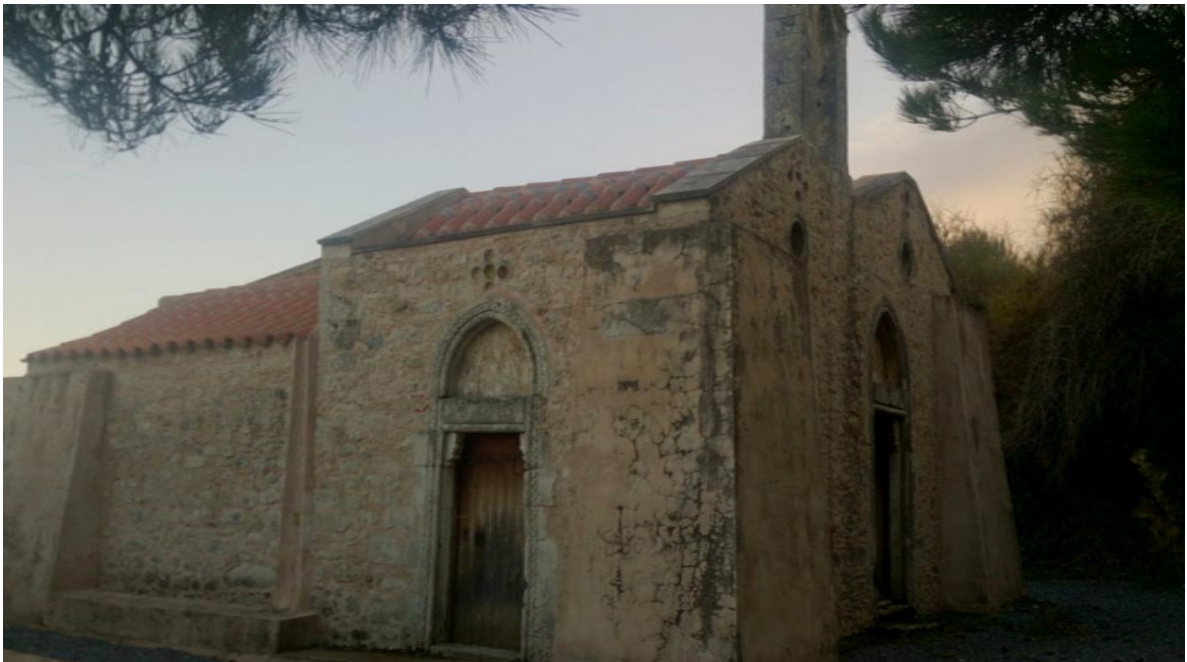
ΕΙΚΟΝΑ 48. Εξωτερική άποψη του ναού από ΒΔ στην παρούσα κατάσταση διατήρησης μετά από τις επισκευαστικές εργασίες ενίσχυσης με την προσθήκη αντιρρίδων σε μεγάλο τμήμα της δυτικής όψης που εγκυβωτίζει την ΒΔ και ΝΔ γωνία αντίστοιχα (φωτογραφία από προσωπικό αρχείο)
