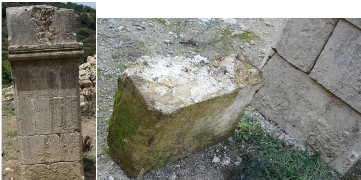
ΕΙΚΟΝΑ 148. Λεπτομέρεια της λαξευτής λιθοδομής για την διαμόρφωση του ημικυκλικού ανοίγματος στην ένωση των δυο κλιτών. Οι δυο εικόνες προέρχονται από τον ναό του Αγ. Αντωνίου στο Πετάλι και μετά την αποτύπωση τους σχεδιάστηκαν για το τρισδιάστατο μοντέλο του δίκλιτου ναού (εικ. 147) που μελετήθηκε στο λογισμικό των πεπερασμένων στοιχείων. Αριστερά είναι ο δυτικός πεσσός που διατηρείται σήμερα στο μεγαλύτερο ύψος και δεξιά ο πρώτος λίθος του μεσαίου πεσσού με καμπυλότητα προς τα δεξιά που εδράζεται επάνω από την στέψη του πεσσού στη θέση που σημειώνεται ως impost στην εικ. 73.
