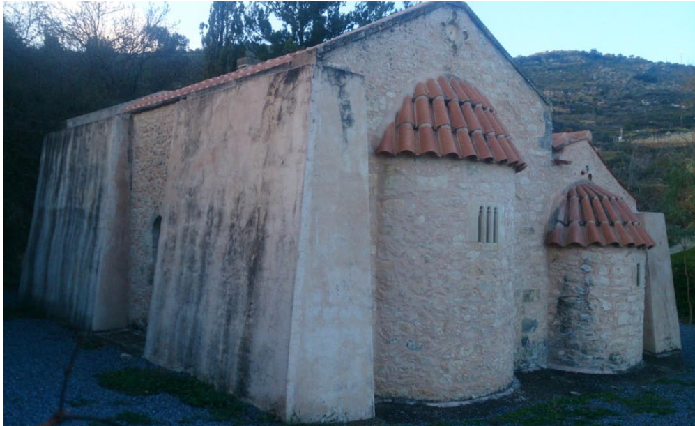
ΕΙΚΟΝΑ 41. ΝΑ άποψη του ναού, όπου είναι εμφανείς οι ενισχυτικές αντιρρίδες του νότιου τοίχου που καλύπτουν σχεδόν το σύνολο της αντίστοιχης όψης (φωτογραφία από προσωπικό αρχείο)
