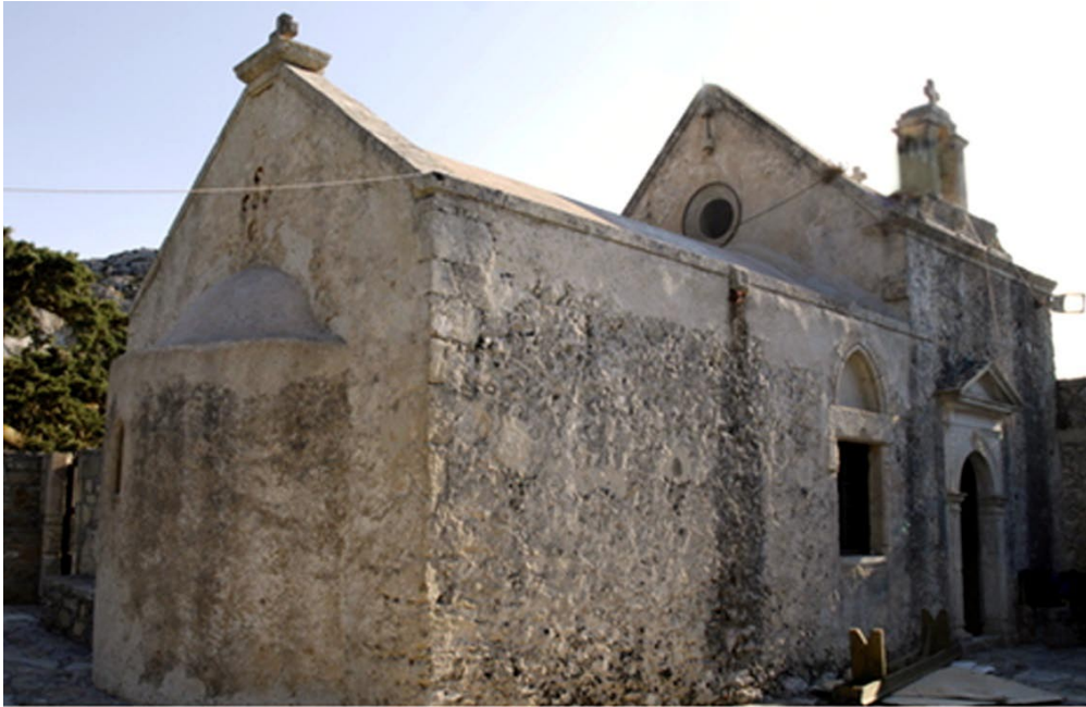
ΕΙΚΟΝΑ 22. ΒΑ άποψη του ναού, με εμφανή την διαφοροποίηση καθ' ύψος του τμήματος που επεκτάθηκε προς τα δυτικά. (φωτογραφία από προσωπικό αρχείο)
