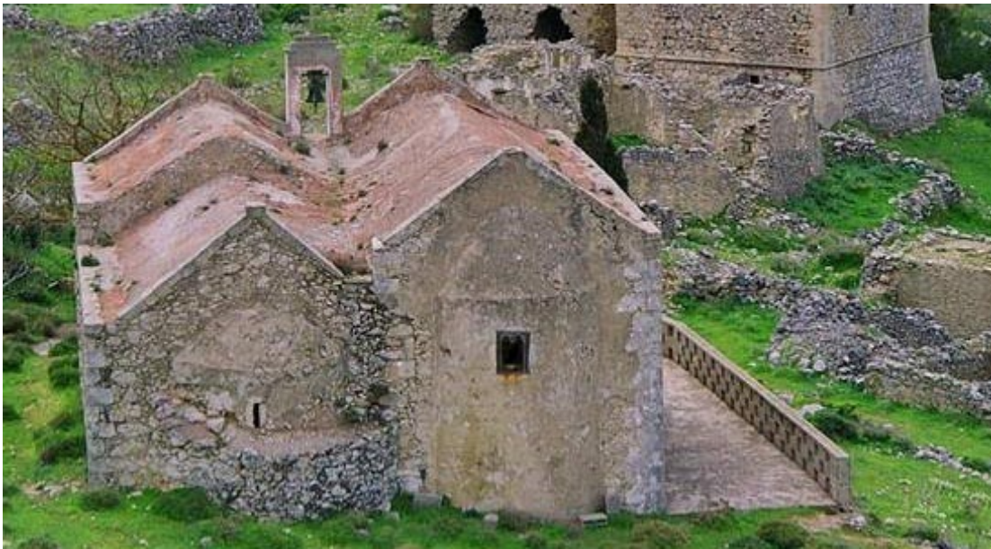
ΕΙΚΟΝΑ 24. Ανατολική άποψη του ναού. Στο παλαιότερο νότιο κλίτος διακρίνεται εξωτερικά σε χαμηλότερο ύψος μεγαλύτερο πάχος τοιχοποιίας γύρω από την κόγχη, πιθανόν για λόγους ενίσχυσης της ακαμψίας τοπικά στο σημείο εκείνο.
