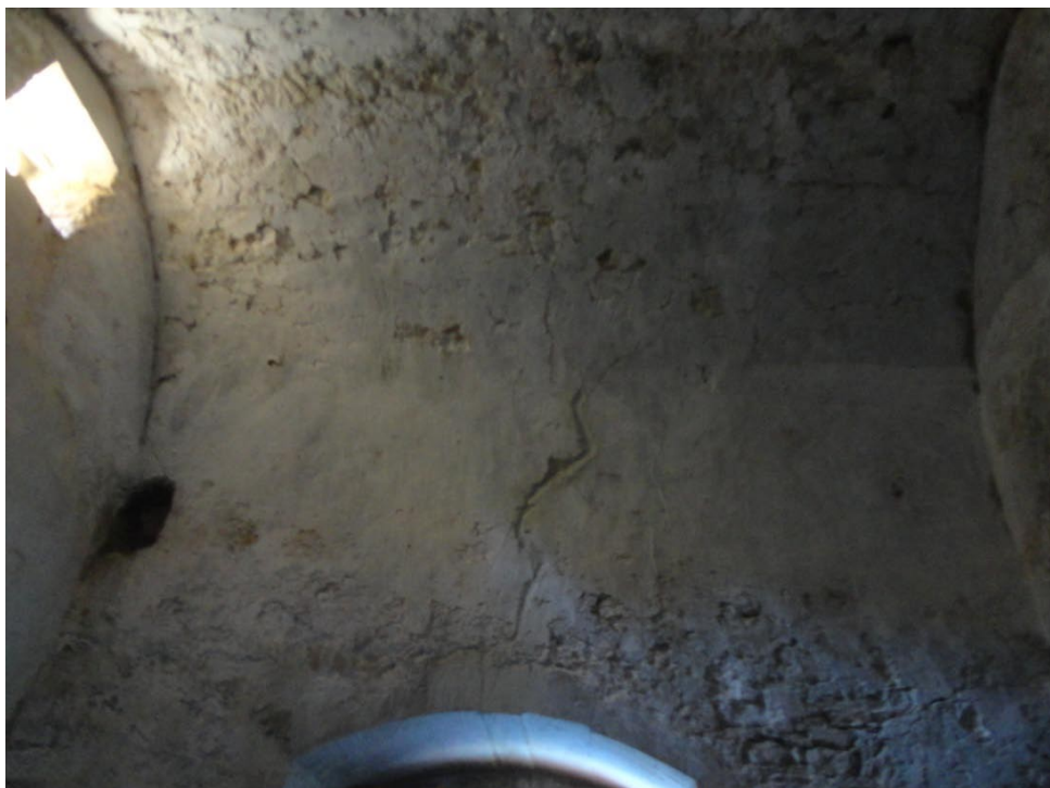
ΕΙΚΟΝΑ 96. Βόρειο κλίτος. Ρωγμή επάνω από το θύρωμα προς βορρά, συμμετρική με την ρηγμάτωση το κέντρο του τόξου της πεσοστοιχίας.(βλ. εικ. 93)
