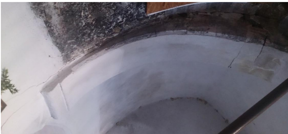
ΕΙΚΟΝΑ 100. Βόρειο κλίτος του ναού της Κεράς, άποψη προς τα δυτικά στην περιοχή συναρμογής του αρχικού κλίτους με την προσθήκη κατά μήκος και την διαφοροποίηση καθ ύψος των δυο κλιτών όπου φαίνεται η ρηγμάτωση και η τοπική αστοχία μεταξύ των λίθων του σφενδονίου.
