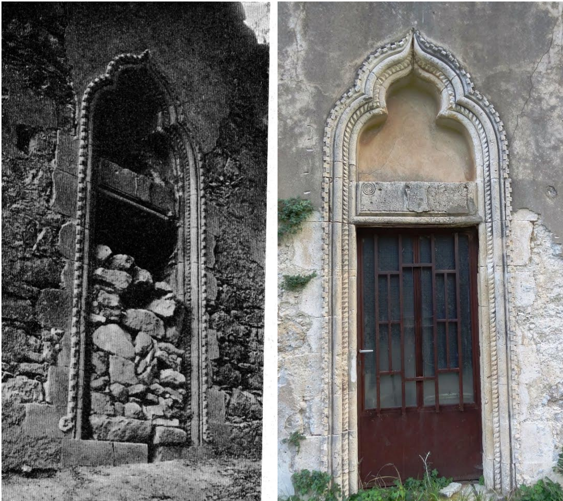
ΕΙΚΟΝΑ 52. Εξωτερική άποψη της κυρίας εισόδου του ναού από την δυτική όψη όπως αποτυπώνεται από τον Gerola (Gerola, 1932 p. 271) (αριστερά) καιόπως έχει διαμορφωθεί σήμερα (δεξιά) (φωτογραφία από προσωπικό αρχείο) Κοινό χαρακτηριστικό με τους άλλους ναούς που μελετήθηκαν αποτελεί η οδοντωτή ταινία που διαμορφώνει το πλαίσιο της λαξευτής λιθοδομής του θυρώματος, το υπέρθυρο με το οικόσημο στο κέντρο και τις σπείρες συμμετρικά προς τα άκρα του, με την διαφορά ότι το υπέρθυρο εδώ δεν εδράζεται σε φουρούσια.
