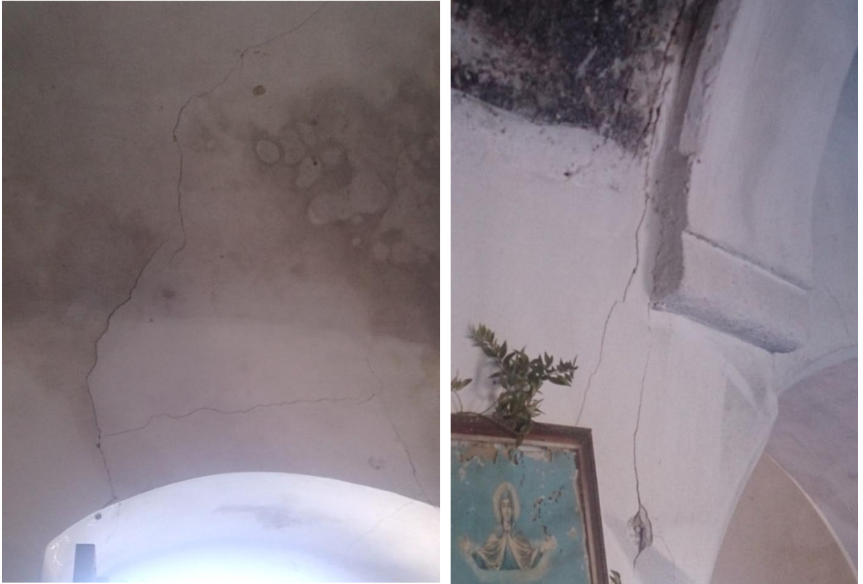
ΕΙΚΟΝΑ 99. Βόρειο κλίτος της εκκλησίας της Κεράς, (αριστερά) όπου φαίνεται η ίδια ρηγμάτωση επάνω από το θύρωμα της βόρειας πλευράς (συγκρ. Με εικ. 93) και ρηγμάτωση του μεσαίου τόξου επικοινωνίας των δυο κλιτών (δεξιά) στο σημείο ένταξης στην κυρίως λιθοδομή της βάσης εδράσεως του σφενδονίου (συγκρ. Με εικ. 93)
