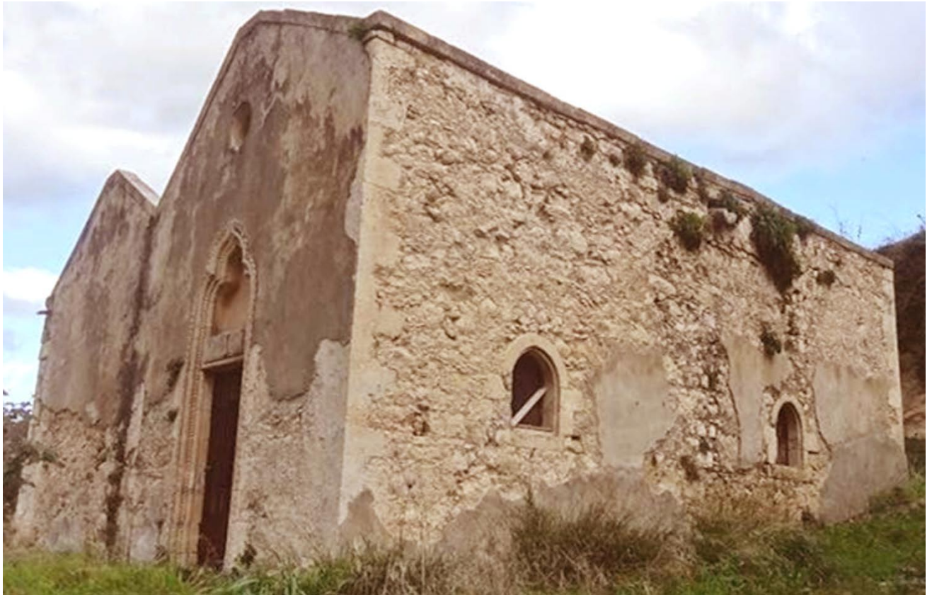
ΕΙΚΟΝΑ 50. Εξωτερική άποψη του ναού από την ΝΔ γωνία όπου το έδαφος είναι έντονα κατηφορικό με κατεύθυνση προς το ρέμα που βρίσκεται σε μικρή απόσταση. Στην εξωτερική τοιχοποιία δεν διατηρείται το σύνολο της επίχρισης με αποτέλεσμα να είναι εφικτή η παρατήρηση των ρηγματώσεων που παρουσιάζει. (φωτογραφία από προσωπικό αρχείο)
