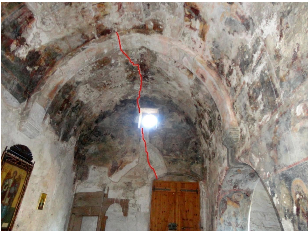
ΕΙΚΟΝΑ 95. Εσωτερική άποψη του νότιου κλίτους προς τα δυτικά. Εμφανής είναι η χαρακτηριστική διαγώνια ρωγμή που υπάρχει και στις άλλες δυο υπό μελέτη περιπτώσεις ναών.
