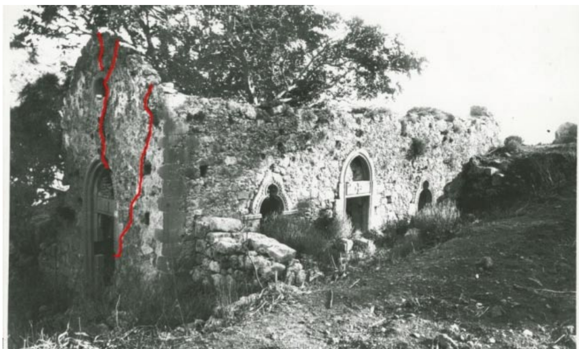
ΕΙΚΟΝΑ 102. Η φωτογραφία του Gerola στις αρχές του 20 ου αι. (εικ. 56) Όπου σημειώνονται με κόκκινο χρώμα οι δυο βασικές ρηγματώσεις που οδήγησαν στην σταδιακή κατάρρευση του δυτικού τοίχου σε δυο στάδια
