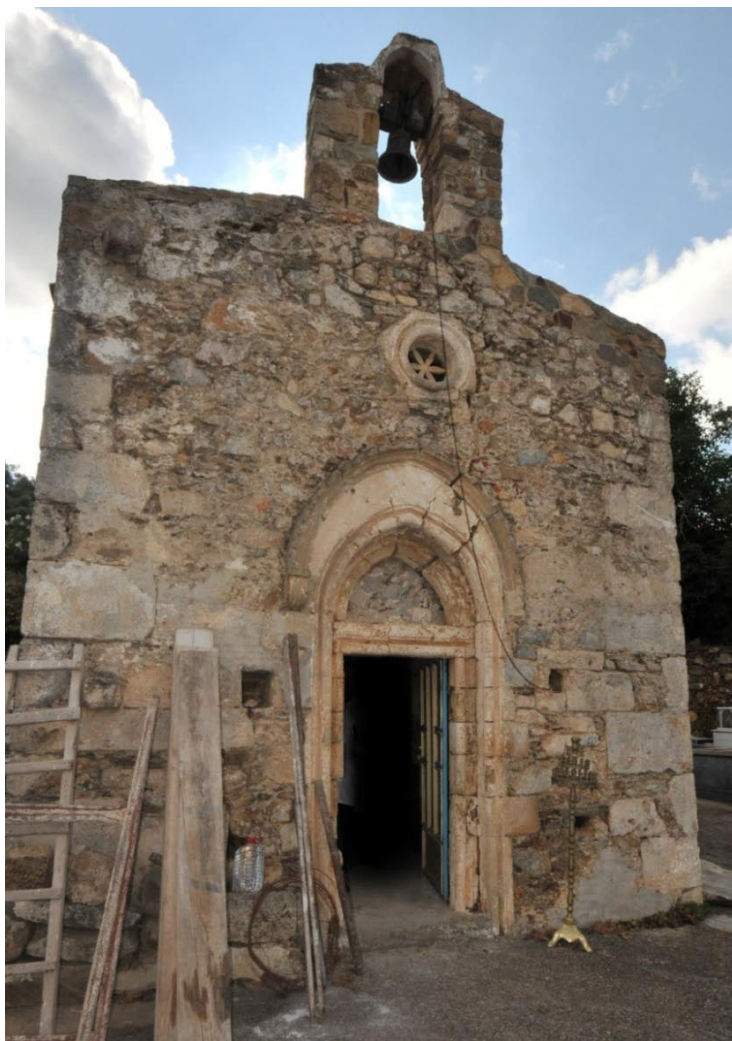
ΕΙΚΟΝΑ 17. Δυτική όψη του ναού (αριστ) όπου είναι εμφανής η ρωγμή καθ' ύψος επάνω από το θύρωμα.
