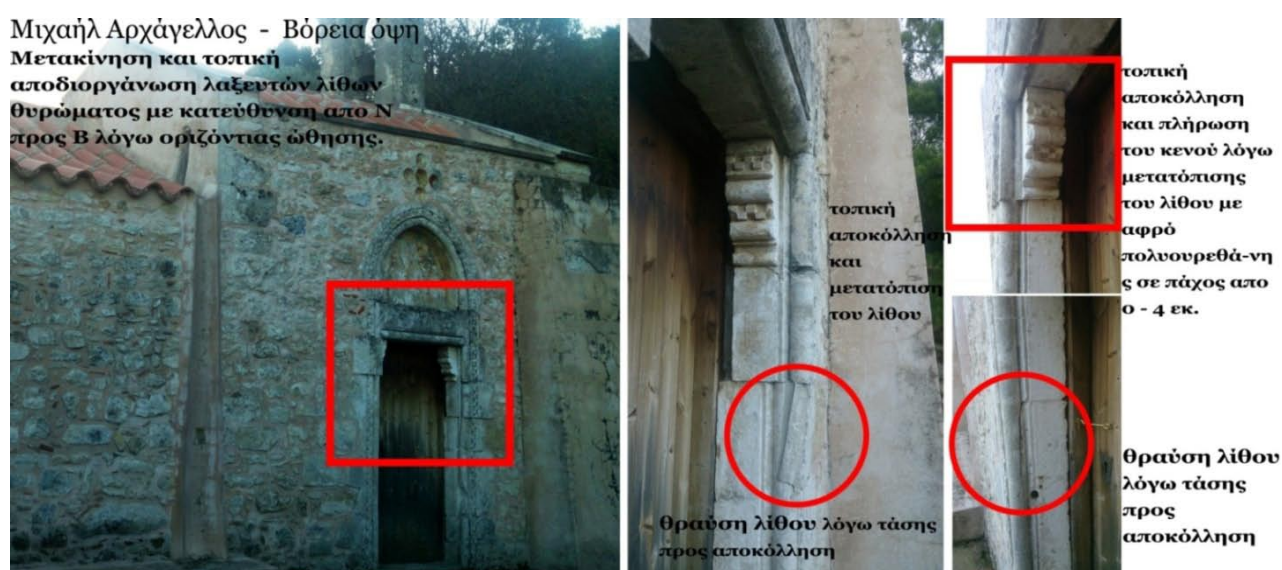
ΕΙΚΟΝΑ 92. Βόρεια όψη και λεπτομέρεια θυρώματος, όπου σημειώνονται τοπικές μετακινήσεις λίθων και αστοχίες.
