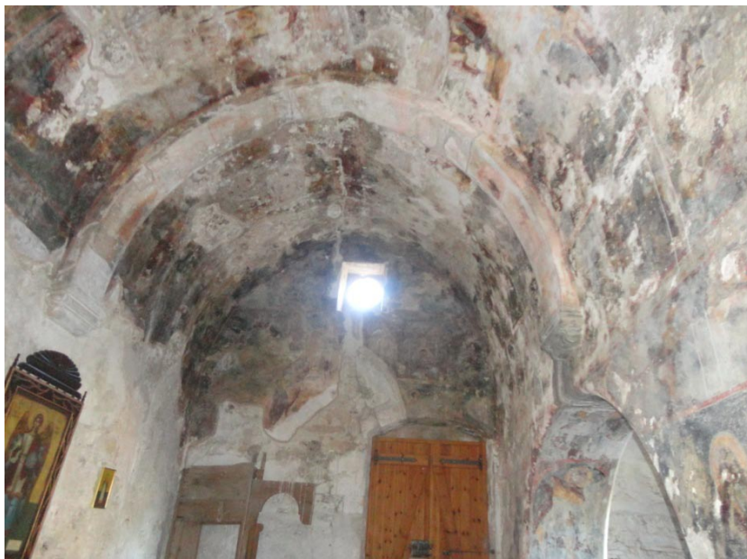
ΕΙΚΟΝΑ 44: Εσωτερική άποψη του ναού στο νότιο κλίτος προς τον δυτικό τοίχο, όπου είναι εμφανής η λοξή ρωγμή καθ' ύψος επάνω από το θύρωμα, η οποία επεκτείνεται καθ ύψος έως την κορυφή του θόλου και κατά μήκος αυτής. (όπως και στην εικ. 19)
