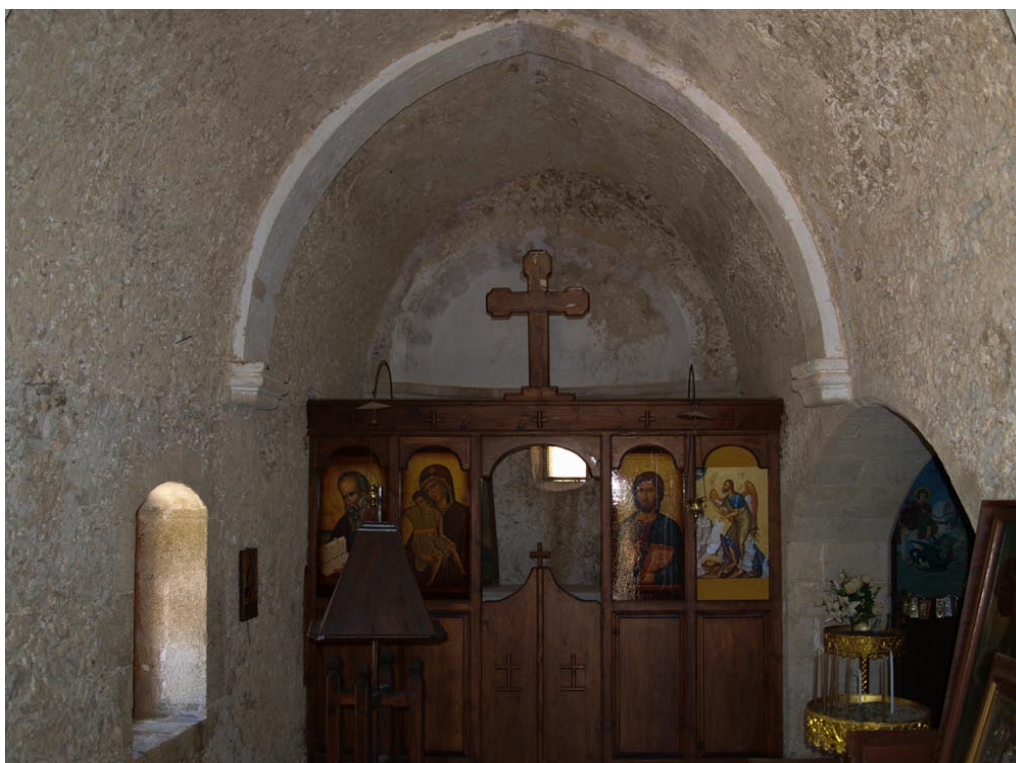
ΕΙΚΟΝΑ 27. Εσωτερική άποψη του ναού στο βόρειο κλίτος. Διακρίνεται το τυπικό άνοιγμα στην βόρεια φέρουσα τοιχοποιία, το σφενδόνιο ενίσχυσης του θόλου, εδραζόμενο σε φουρούσια, η χαρακτηριστική ημικυκλικής μορφής καμάρα που ενώνει τα δύο κλίτη διαμορφωμένη από λαξευτή λιθοδομή. (φωτογραφία από προσωπικό αρχείο)
