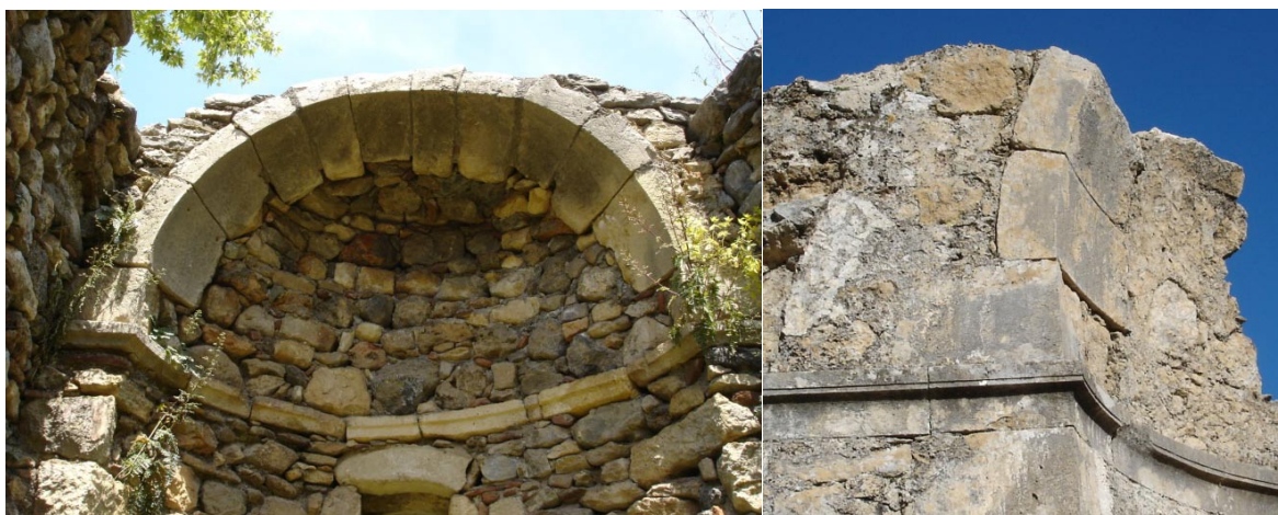
ΕΙΚΟΝΑ 122. Εσωτερική άποψη της κόγχης του ιερού όπου ξεχωρίζουν οι καμπύλοι δόμοι που διαμορφώνουν την καμπυλότητα του τόξου. Στην αριστερή εικόνα είναι η κόγχη του ιερού του ναού του Μιχαήλ Αρχαγγέλου στην Αξό Μυλοποτάμου, η οποία διατηρείται ακέραια στο σύνολό της. Στην δεξιά εικόνα παρουσιάζονται κατ'αντιστοιχία οι καμπύλοι δόμοι της εκκλησίας του Αγ. Αντωνίου στο Πετάλι Μαλεβιζίου, στο ύψος που διατηρούνται μόνο οι τρεις πρώτοι λίθοι διαμόρφωσης της κόγχης.
