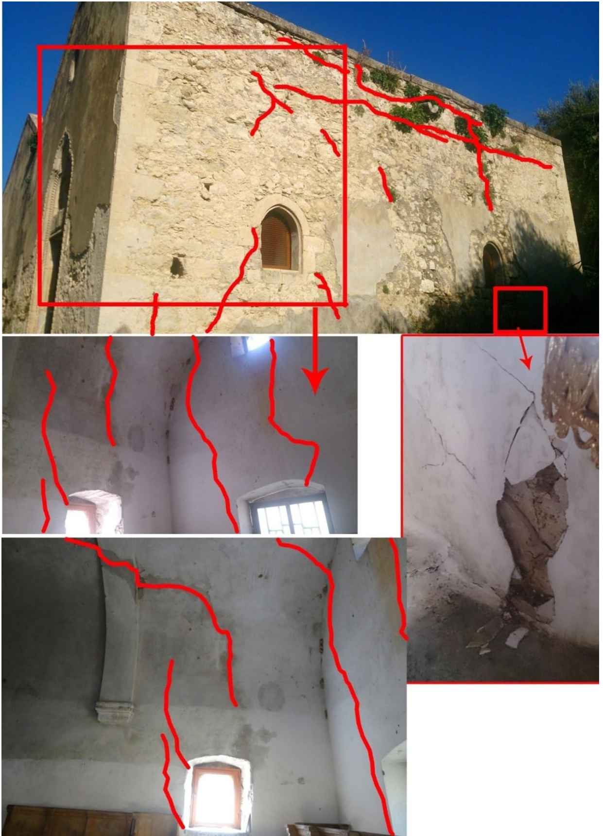
ΕΙΚΟΝΑ 98. Κύριες ρηγματώσεις στην ΝΔ γωνία της εκκλησίας της Κεράς, εσωτερική και εξωτερική άποψη. Από την συγκριτική παρατήρηση των εικόνων αυτών είναι εμφανές ότι πολλές από τις σημαντικότερες ρωγμές του νότιου τοίχου είναι διαμπερείς.
