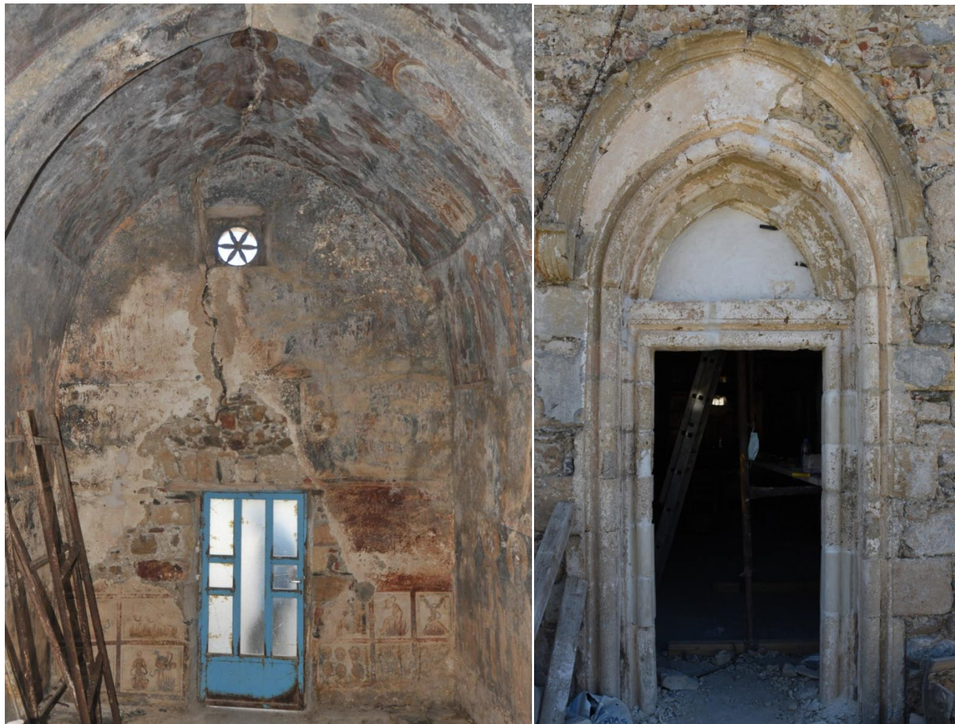
ΕΙΚΟΝΑ 19. Εσωτερική άποψη του ναού (αριστ) προς τον δυτικό τοίχο, όπου είναι εμφανής η ρωγμή καθ' ύψος επάνω από το θύρωμα, η οποία επεκτείνεται και κατα μήκος του θόλου στην κορυφή.
