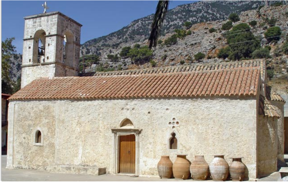
ΕΙΚΟΝΑ 30: Νότια άποψη του ναού. Στα \frac{3}{4} περίπου του συνολικού μήκους του νότιου φέροντος τοίχου προς τα δυτικά, ξεχωρίζει ο αρμός της επέκτασης κατα μήκος του αρχικού κλίτους, χωρίς άλλη διαφοροποίηση καθ' ύψος. Στο τμήμα αυτό της προσθήκης υπάρχει το χαρακτηριστικό ελαφρώς οξυκόρυφο άνοιγμα, λιτής διακοσμησης από λαξευμένη λιθοδομή που συναντάται και σε άλλα παραδείγματα ναών. (φωτογραφία από προσωπικό αρχείο)
