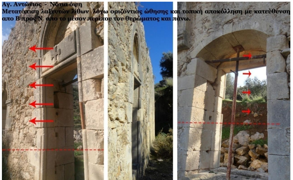
ΕΙΚΟΝΑ 106. Εξωτερική και εσωτερική άποψη του μεσαίου ανοίγματος στον νότιο τοίχο του Αγ Αντωνίου όπου σημειώνονται με κόκκινα βέλη οι κύριες ωθήσεις που οδήγησαν σε τοπικές αποδιοργανώσεις μεταξύ των λίθων που το διαμορφώνουν, βασιζόμενες σε δυνάμεις τριβής και ολίσθησης.
