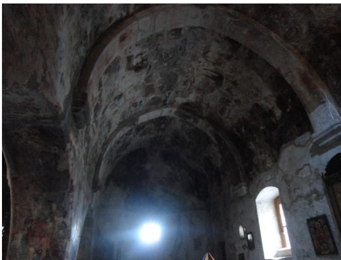
ΕΙΚΟΝΑ 47. Εσωτερική άποψη του ναού στο βόρειο κλίτος (αριστερά) προς τα δυτικά, με εμφανή τα σφενδόνια εδραζόμενα σε φουρούσια, εντοιχισμένα στην λιθοδομή, τα δυο πλευρικά ανοίγματα του βόρειου φέροντος τοίχου και τμήμα της λαξευτής λιθοδομής διαμόρφωσης του τόξου της πεσσοστοιχίας που ενώνει τα δυο κλίτη. Εσωτερική άποψη
