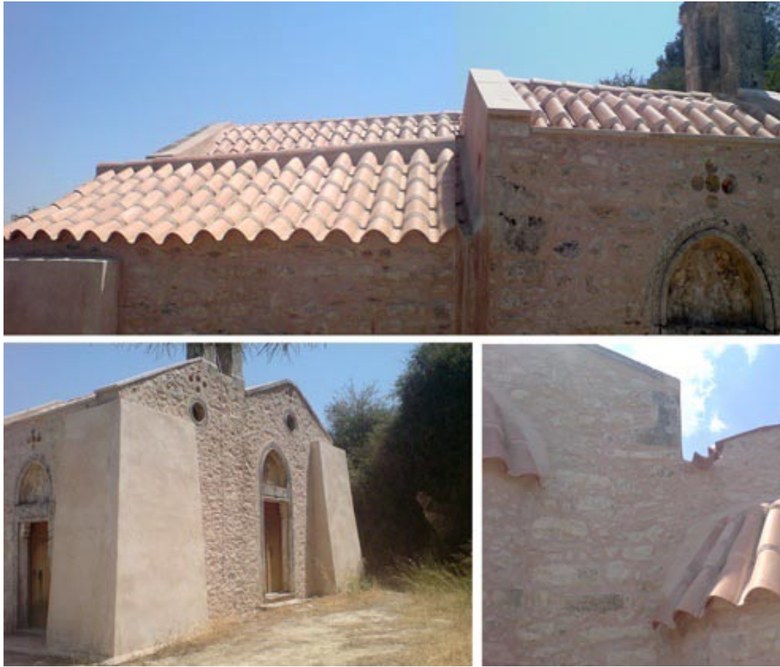
ΕΙΚΟΝΑ 46. Εξωτερική άποψη του ναού από βορρά (πάνω), ΒΔ (αριστερά) και ανατολικά (δεξιά) στα σημεία ένωσης της στέγασης των δυο κλιτών όπου είναι εμφανής η διαφοροποίηση καθ ύψος στο τμήμα της προσθήκης κατά μήκος και στο μεταγενέστερο κλίτος. (φωτογραφίες από προσωπικό αρχείο)
