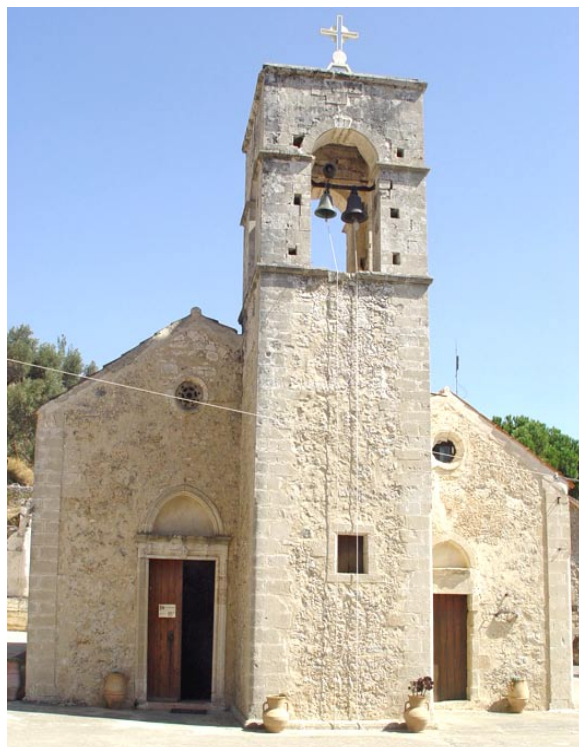
ΕΙΚΟΝΑ 29: Δυτική όψη του ναού με το κωδωνοστάσιο. Διαφοροποιείται χαρακτηριστικά στην φωτογραφία το ύψος στέγας του αρχικού κλίτους σε σχέση με το αντίστοιχο της προσθήκης (φωτογραφία από προσωπικό αρχείο)
