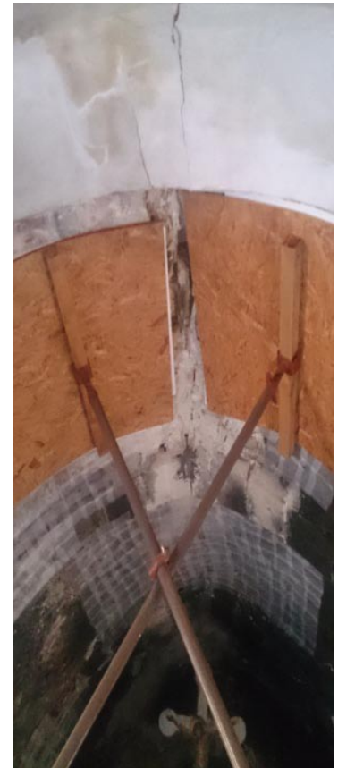
ΕΙΚΟΝΑ 97. Ναός της Κεράς στο Σάρχο. Άποψη του ανοίγματος στον νότιο τοίχο όπου είναι εμφανής διαγώνια ρωγμή στην κάτω πλευρά του (αριστερά) και εσωτερική άποψη του βόρειου κλίτους (δεξιά) όπου είναι εμφανής κατά μήκος ρηγμάτωση στο θόλο στο παλαιότερο τμήμα και στο τμήμα της υπερύψωσης της προσθήκης.
