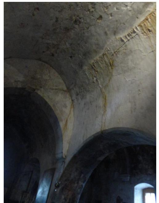
ΕΙΚΟΝΑ 47. Εσωτερική άποψη του ναού στο βόρειο κλίτος (αριστερά) προς τα δυτικά, με εμφανή τα σφενδόνια εδραζόμενα σε φουρούσια, εντοιχισμένα στην λιθοδομή, τα δυο πλευρικά ανοίγματα του βόρειου φέροντος τοίχου και τμήμα της λαξευτής λιθοδομής διαμόρφωσης του τόξου της πεσσοστοιχίας που ενώνει τα δυο κλίτη. Εσωτερική άποψη
