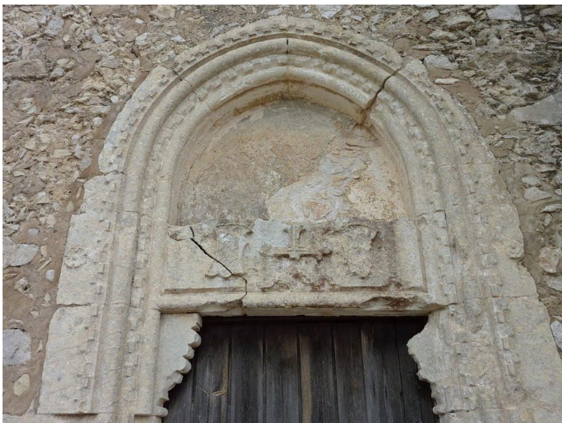
ΕΙΚΟΝΑ 25. Δυτική άποψη του ναού. Θύρωμα, όπου διακρίνεται χαρακτηριστικά η ρωγμή που διατρέχει διαγώνια το ανακουφιστικό τόξο και έχει προκαλέσει τοπικά μετακίνηση των λίθων στην βόρεια πλευρά του και θραύση στο υπέρθυρο. (φωτογραφία από προσωπικό αρχείο)
