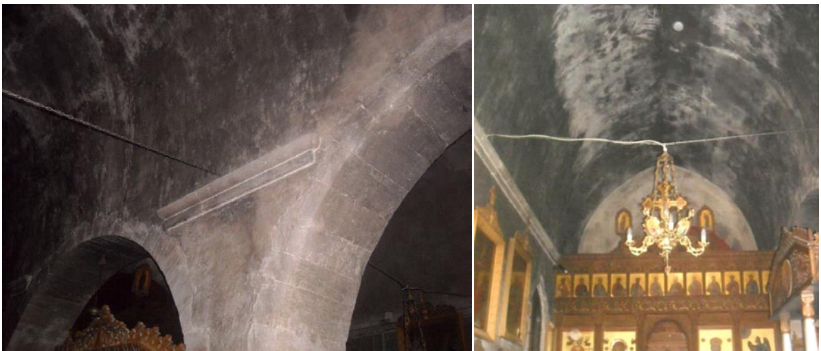
ΕΙΚΟΝΑ 39: Τα ημικυκλικά λαξευτά τόξα των πεσσών που ενώνουν τα δυο κλίτη, εσωτερική άποψη από το βόρειο κλίτος του ναού όπου ξεχωρίζει η νοητή συνέχεια της διακόσμησης της στάθμης γεννέσεως του θόλου (αριστερά) και η γενική άποψη της θολοδομίας του ίδιου κλίτους (δεξιά) όπου φαίνεται η απουσία σφενδονίων ενίσχυσης.
