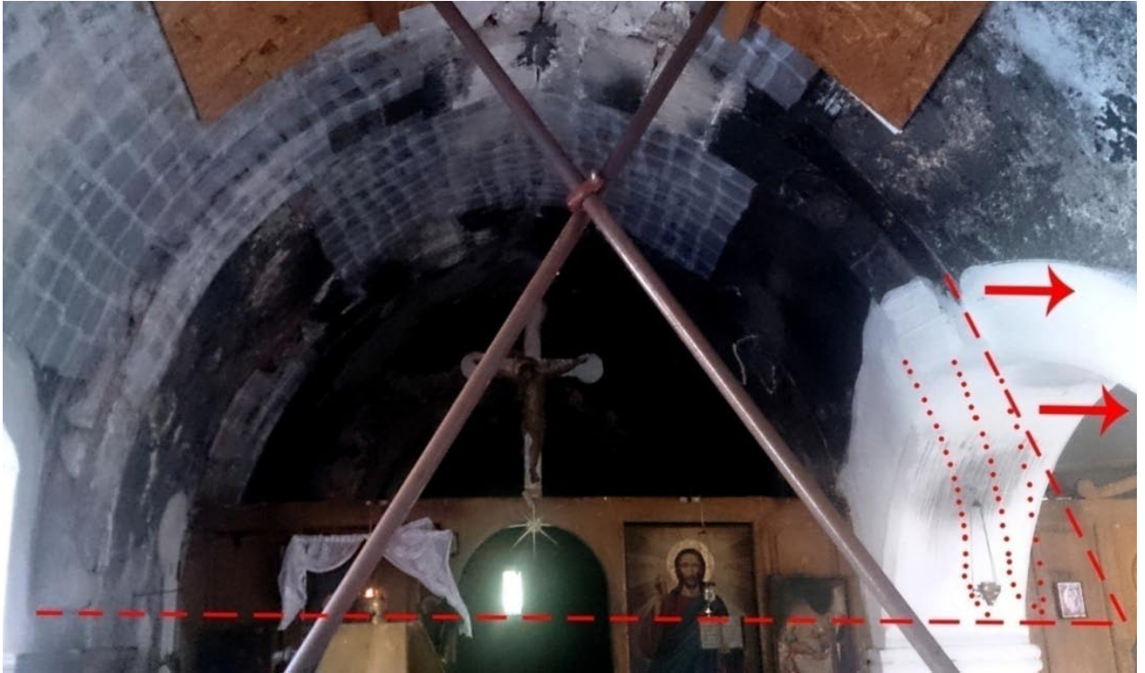
ΕΙΚΟΝΑ 81. Ναός Κεράς στο Σάρχο. Άποψη του βόρειου κλίτους. Με κόκκινη διακεκομμένη γραμμή σημειώνεται η νοητή προέκταση του αρχικού μήκους του σφενδονίου σύμφωνα με το διατηρούμενο τμήμα του στον βόρειο τοίχο καθώς και οι πλάγιες ωθήσεις που μεταφέρονται στο πάχος της λιθοδομής του τόξου μεταξύ των πεσσών που θα μπορούσε να λειτουργήσει ως προσθετο φορτίο για την αποδιοργάνωση μεταξύ των λίθων που συνθέτουν το τόξο σε ενδεχόμενη δυναμική φόρτιση.
