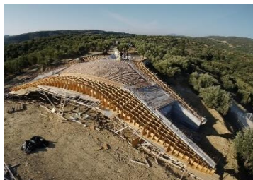
Εικόνα 88. Συναρμολόγηση του ξυλότυπου του κελύφους.
