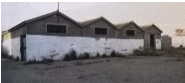
Εικ.34: 4 διαδοχικά όμοια τμήματα, που το καθένα φέρει δίριχτη στέγη
