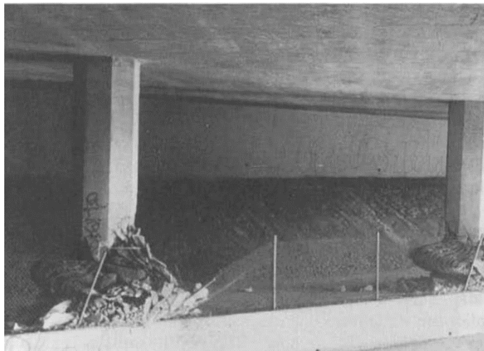
Εικόνα 1.13 Καμπτικές πλαστικές αρθρώσεις σε υποστυλώματα που αποδίδονται στο τοίχιο σύνδεσης, κοιλαδογέφυρα στο Φαράγγι Bull Creek, 1994 σεισμός Northridge [Priestley κ.ά., 1996].
