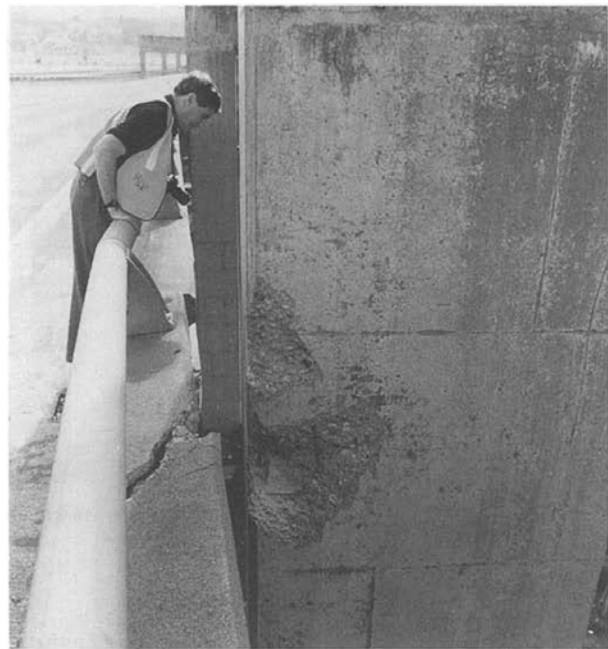
Εικόνα 1.3 Σύγκρουση των I-208 China Basin/Νότιας κοιλαδογέφυρας, 1989 σεισμός Loma Prieta [Priestley κ.ά., 1996].
