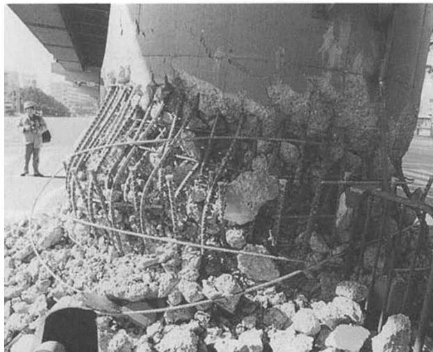
Εικόνα 1.11 Αστοχία κολλήσεων διαμήκη οπλισμού υποστυλώματος, 1995 σεισμός Kobe [Priestley κ.ά., 1996].
