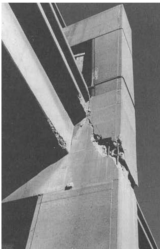
Εικόνα 1.6 Διατμητική αστοχία συνδέσμου, κοιλαδογέφυρα I-880, 1989 σεισμός Loma Prieta [Priestley κ.ά., 1996].
