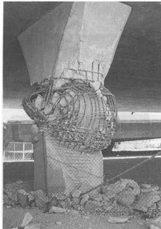
Εικόνα 1.17 Διατμητική αστοχία σε υποστύλωμα, I-118 ανισόπεδος κόμβος Mission/Gothic, 1994 σεισμός Northridge [Priestley κ.ά., 1996].
