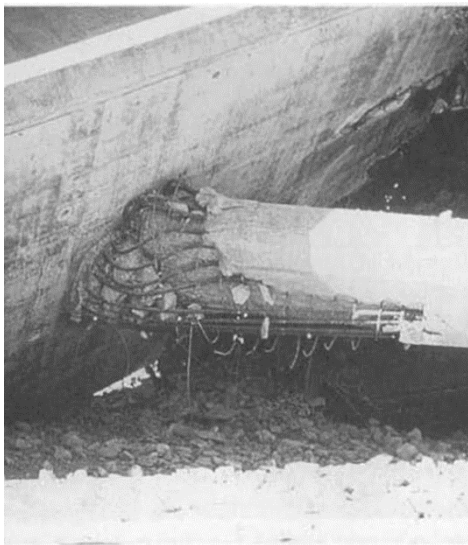
Εικόνα 1.12 Αστοχία οπλισμού περίσφιξης στην κορυφή υποστυλώματος, 1971 σεισμός San Fernando [Priestley κ.ά., 1996].
