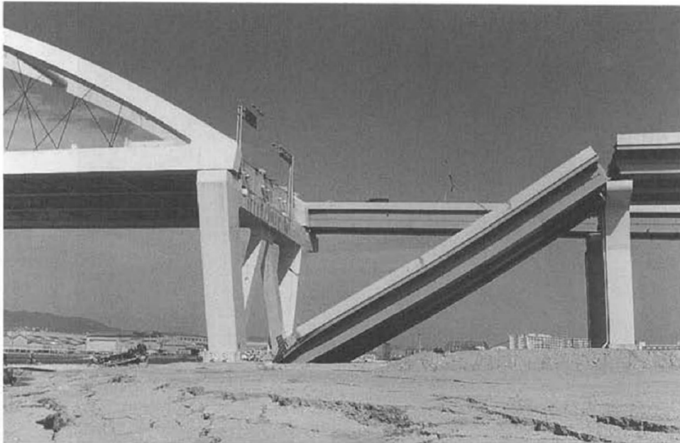
Εικόνα 1.1 Ανατροπή απλά στηριζόμενου ανοίγματος, Γέφυρα Nishinomiya-ko, 1995 σεισμός Kobe [Priestley κ.ά., 1996].
