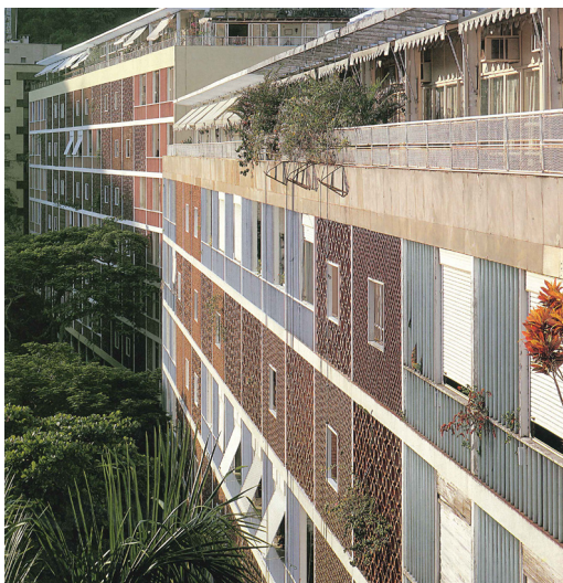
23. Lucio Costa, Guinle Park Residential Buildings , Rio de Janeiro, 1948(Nova Cintra), 1950(Bristol), 1954(Caledonia). Άποψη των δυτικών όψεων των κτιρίων Bristol και Caledonia. Η προστασία από των τροπικό ήλιο γίνεται μέσω brise-soleil και τρυπητών κεραμικών στοιχείων.
