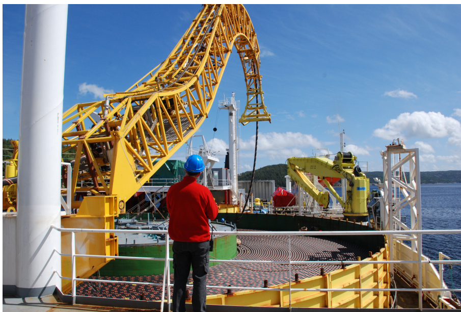
Σχήμα 2.4: Εγκατάσταση υποβρύχιων HVDC καλωδίων (NEXANS)
