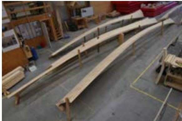
Εικόνα 140. Καμπύλωση ξύλινων στοιχείων
