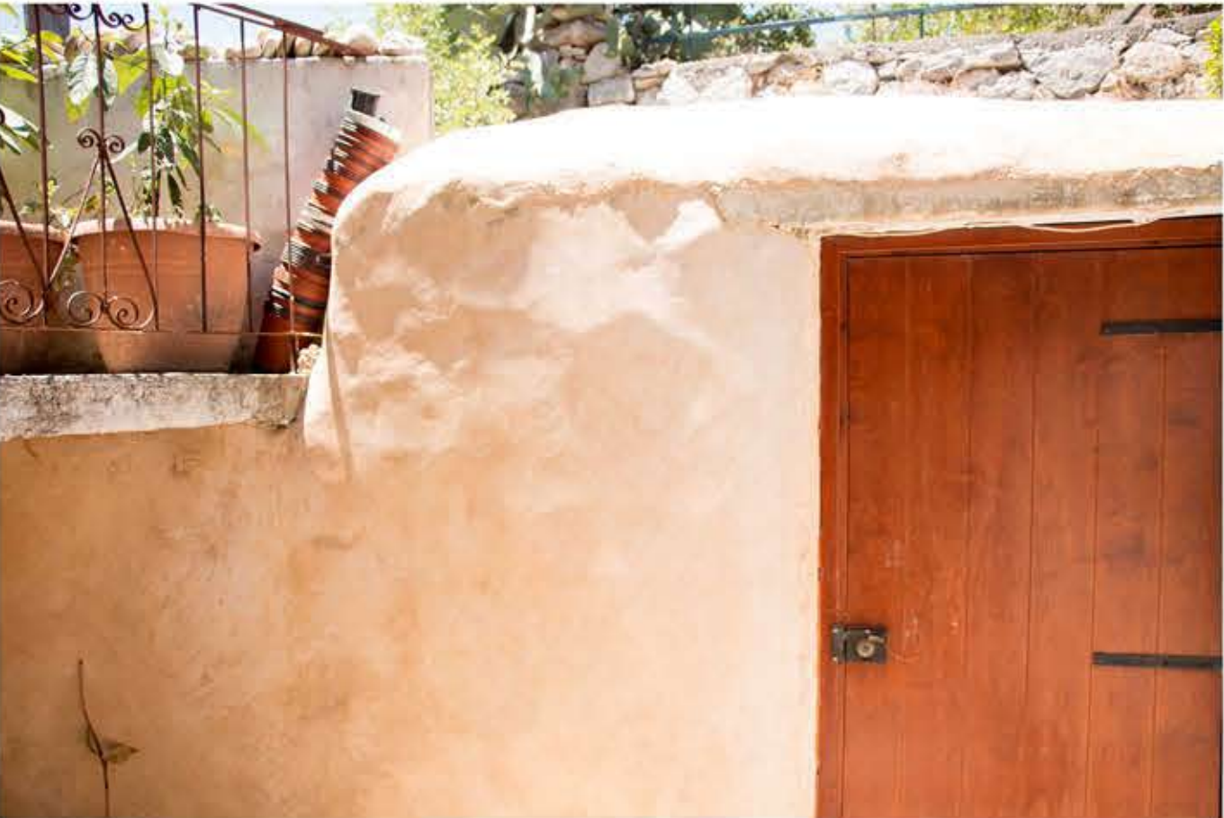
οπές, παλιός σοβάς, σημεία που το υλικό αφαιρείται εύκολα
