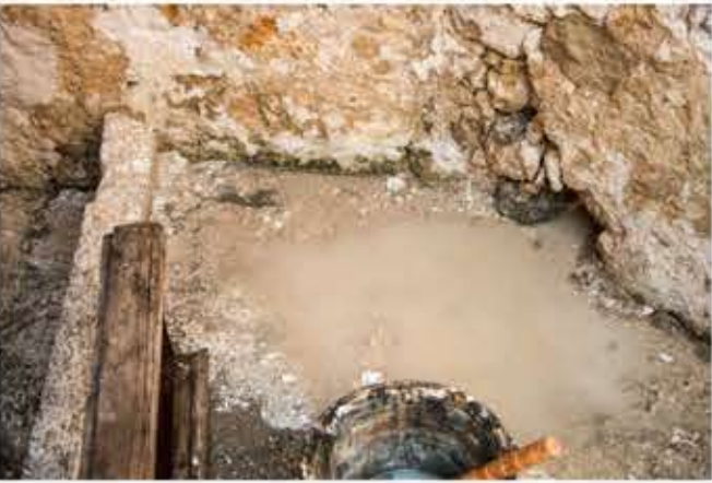
λανθασμένη κλίση επιπέδου απορροής με αποτέλεσμα τη διατήρηση υγρασίας στον τοίχο και δημιουργία βιολογικής φθοράς(μούχλας) στη βάση του
