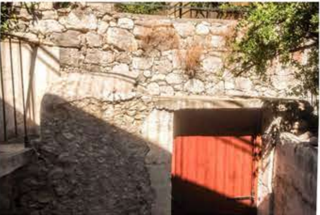
τελείωμα του τοίχου/ πανωπρέκι (σκυρόδεμα με πέτρες)
