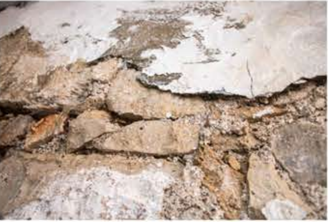
πολλαπλές στρώσεις σοβά χωρίς αφαίρεση της προηγούμενης- δυσκολία αφαίρεσης κάποιων σημείων ή αποκόλληση τεράστιων κομματιών
