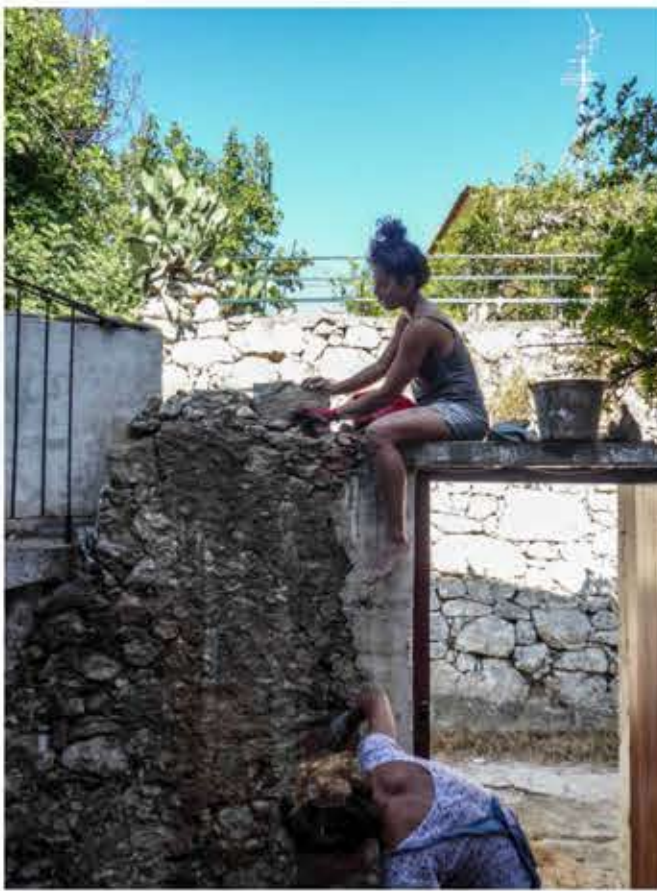
πολλαπλές στρώσεις σοβά χωρίς αφαίρεση της προηγούμενης- δυσκολία αφαίρεσης κάποιων σημείων ή αποκόλληση τεράστιων κομματιών
