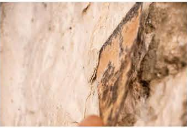
τελείωμα του τοίχου/ πανωπρέκι (σκυρόδεμα με πέτρες)
