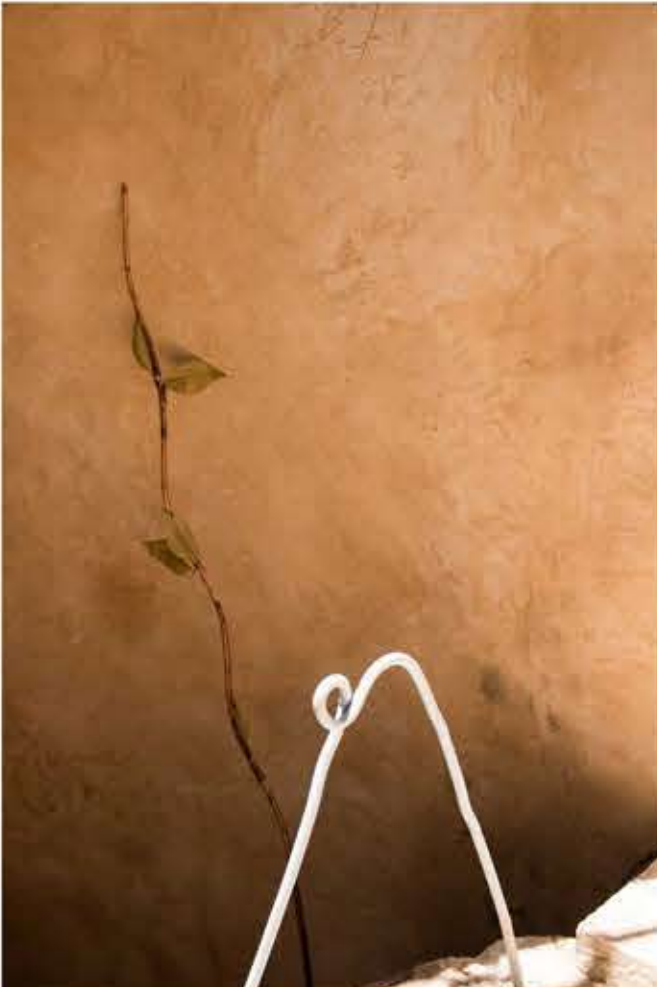
βιολογική φθορά (μούχλα), αποφλοίωση, διαφορετική διάβρωση, βελονισμός, κονιοποίηση
