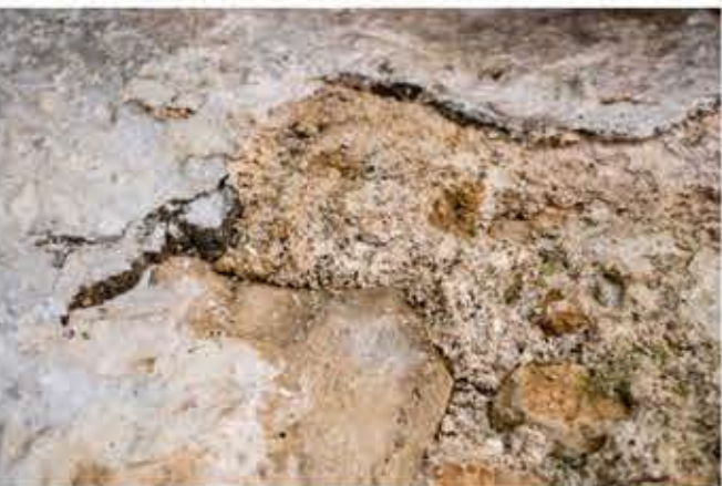
βιολογική φθορά (μούχλα), αποφλοίωση, διαφορετική διάβρωση, βελονισμός, κονιοποίηση
