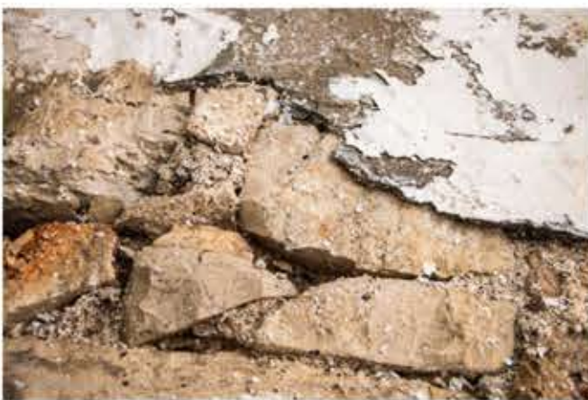
οπές, παλιός σοβάς, σημεία που το υλικό αφαιρείται εύκολα
