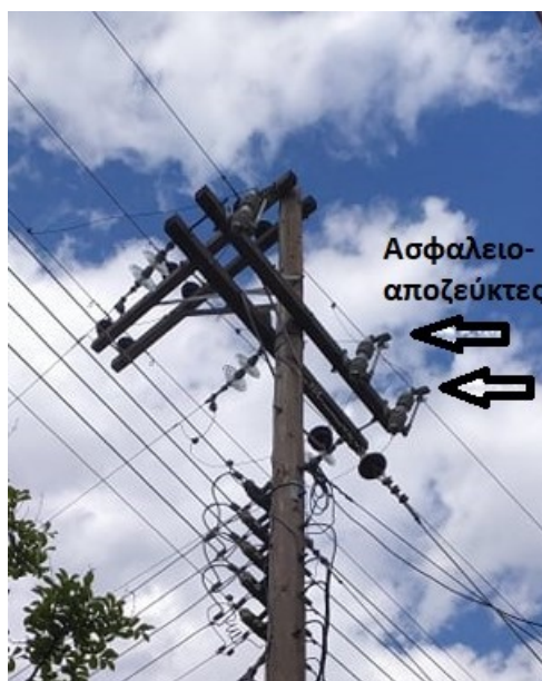
Σχήμα 2.4: Ασφαλειοαποζεύκτες
