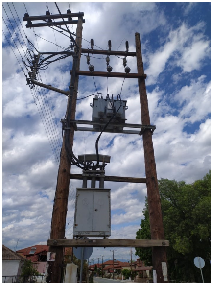
Σχήμα 2.3: Υποσταθμός διανομής σε στύλους
