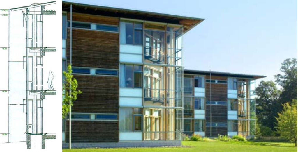
3.46 Διπλό κέλυφος 3.47 Εξωτερική όψη δέσμεων νοσηλείας Τομή
