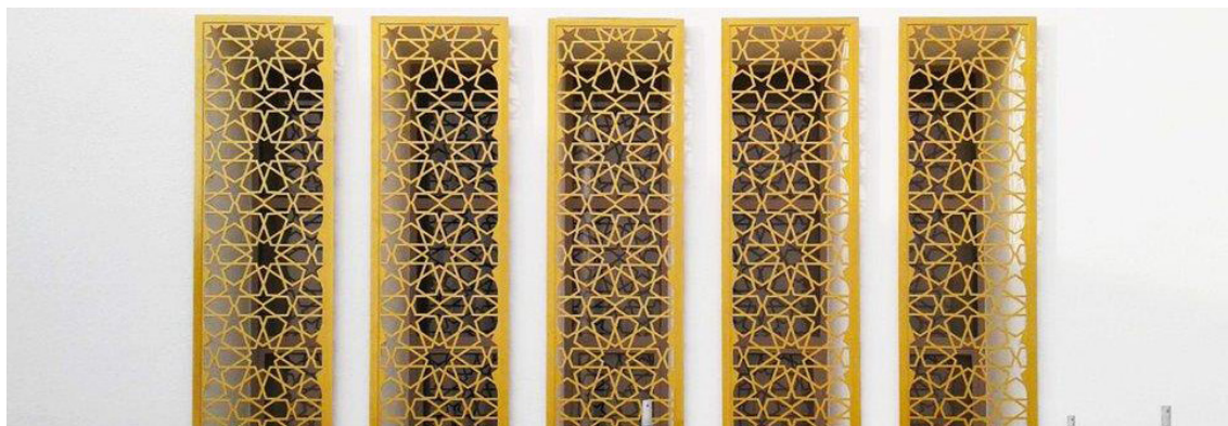
Εικόνα 101: Μεταλλικό mashrabiya κατασκευασμένο από CNC
