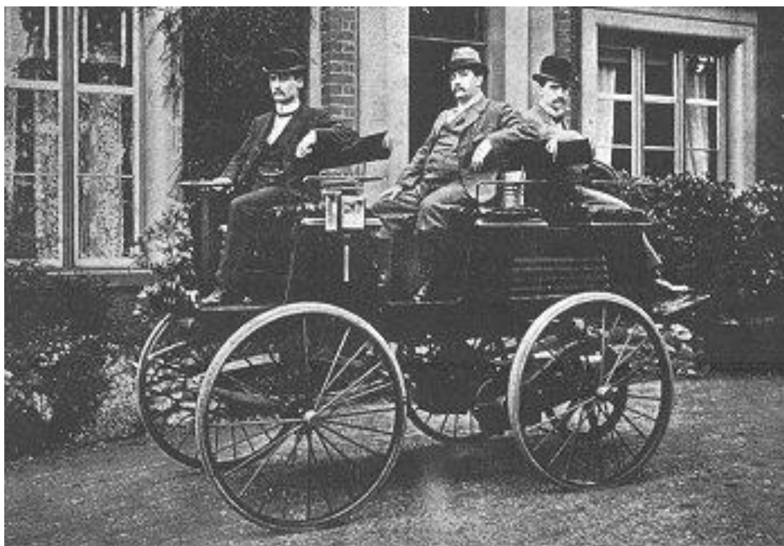
Σχήμα 2.5: Ηλεκτρικό αυτοκίνητο κατασκευασμένο από τον Thomas Parker το 1884 που λειτουργούσε με επαναφορτιζόμενες μπαταρίες που σχεδίασε ο ίδιος.
