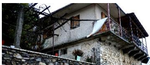
εικόνες 38, 39: κτήρια A4_7, B3_15, μη συμβατές προσθήκες ορόφων από πλίνθινες τοιχοποιίες
