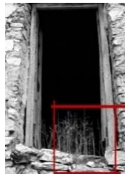
εικόνα 20: κτήριο A2_8, ρήξη κατωφλίου
