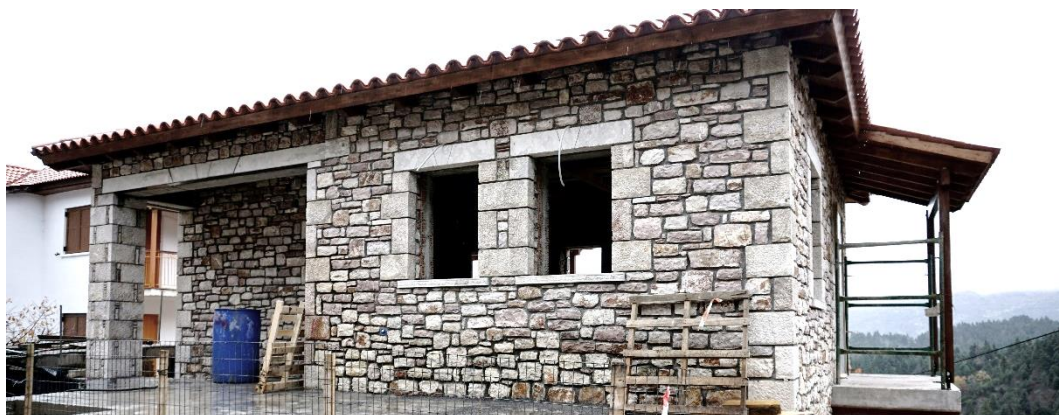
εικόνα 68: κτήριο Γ4_5, συμβατή επένδυση τοιχοποιίας, μη συμβατός εξώστης από σκυρόδεμα
