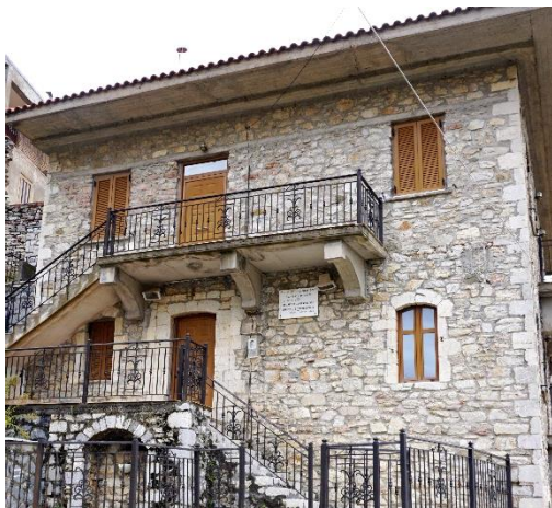
εικόνα 58: κτήριο A2_19, αντικατάσταση παλιών κουφωμάτων με ξύλινα
