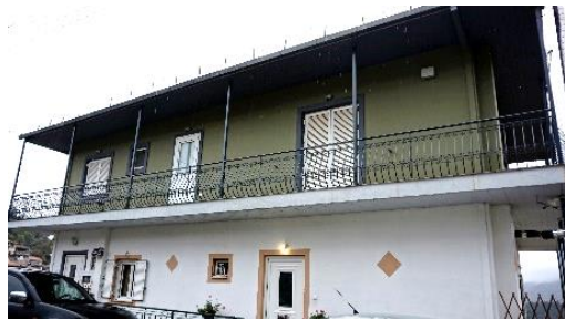
εικόνα 7: κτήριο Γ3_11, κατασκευή στέγης χωρίς κεραμίδια, χρήση κουφωμάτων από αλουμίνιο
