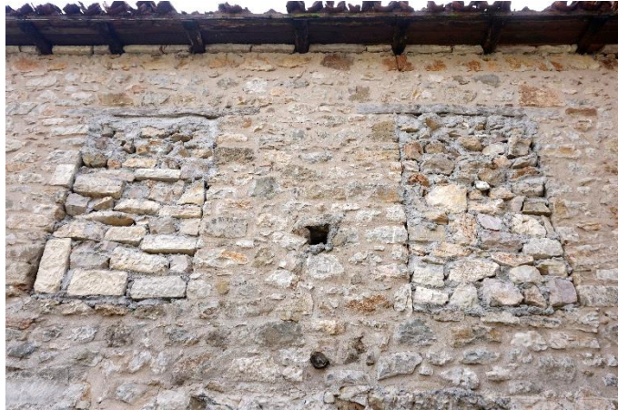
εικόνα 53: κτήριο B3_24, κλείσιμο παραθύρων με λίθους και χρήση τσιμεντοκονιάματος, έντονη επέμβαση
