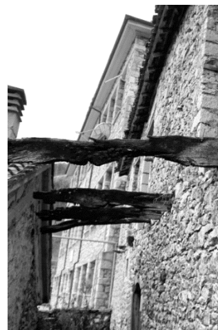
εικόνα 26: κτήριο A2_8, σήψη σανιδώματος εξώστη
