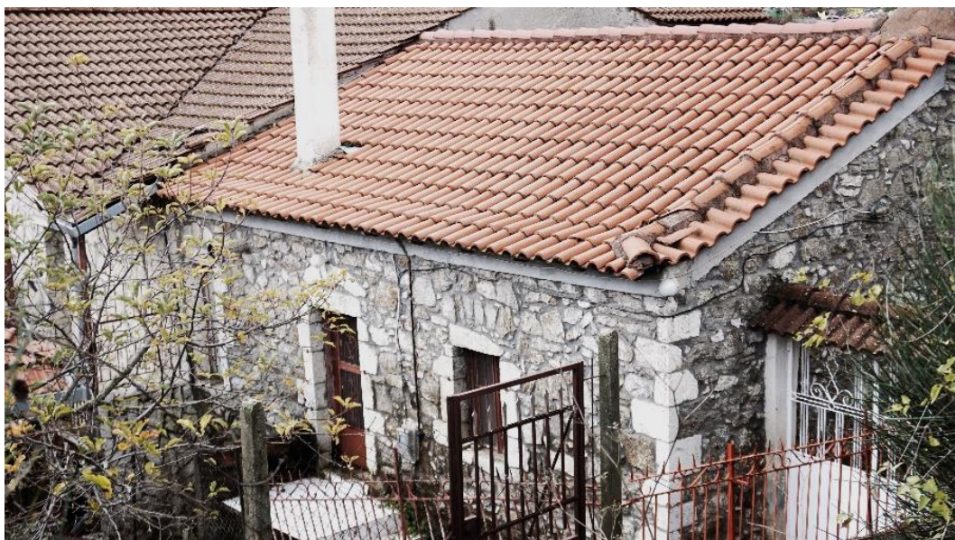
εικόνα 29: κτήριο Γ1_2, αντικατάσταση βυζαντινών κεραμιδιών με ρωμαϊκά, μη συμβατή προσθήκη
