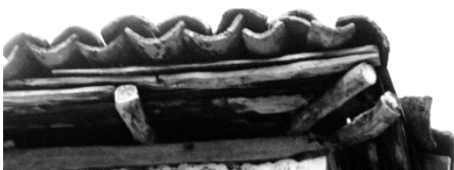
εικόνα 22: κτήριο B3_3, απουσία προστατευτικής στρώσης
