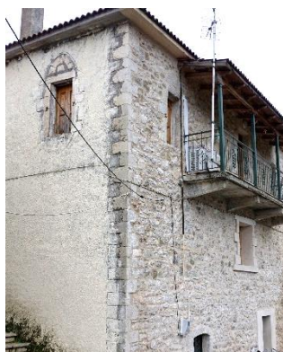
εικόνα 48: κτήριο B3_21, μερική επίχριση κτηρίου
