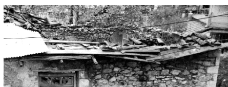
εικόνα 23: κτήριο A2_12, αστοχία στέγης
