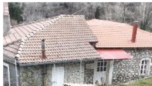
εικόνες 36, 37: κτήρια B2_4, B2_37, μη συμβατές προσθήκες όγκων με διαφορετική στέγη
