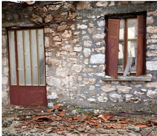
εικόνα 59: κτήριο Δ3_17, αντικατάσταση ξύλινων κουφωμάτων με μέταλλο
