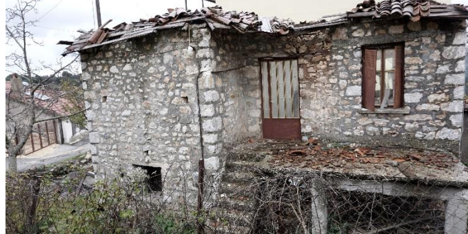
εικόνα 64: κτήριο Δ3_17, ασύμβατες επεμβάσεις, μερική αλλοίωση ερειπίου
