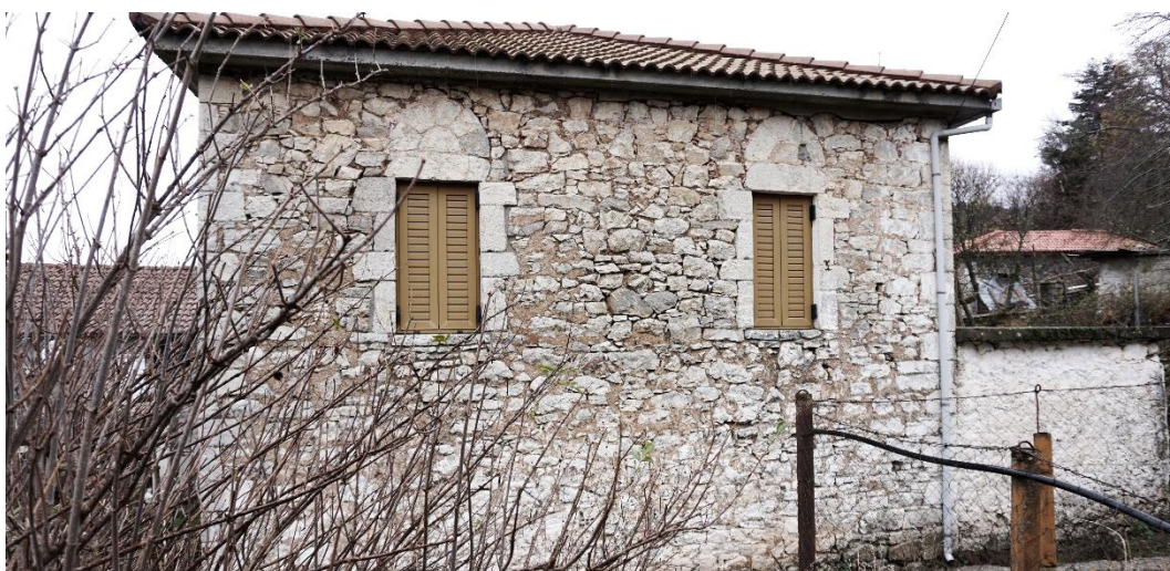
εικόνα 62: κτήριο Δ3_3, αντικατάσταση στέγης και κουφωμάτων, μικρή αλλοίωση
