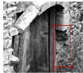
εικόνα 21: κτήριο A2_8, αποκόλληση γωνιόλιθων
