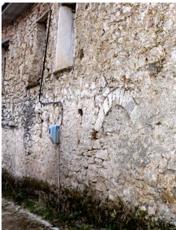
εικόνα 52: κτήριο B3_23, κλείσιμο θύρας, ήπια επέμβαση
