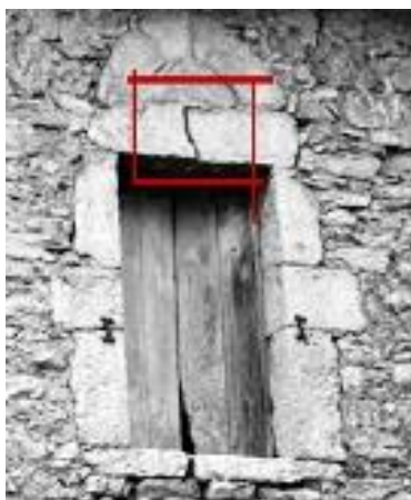
εικόνα 16: κτήριο A2_8, θραύση ανωφλίου
