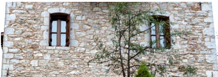
εικόνα 45: κτήριο B3_22, ήπια επέμβαση αρμολόγησης στη λίθινη τοιχοποιία
