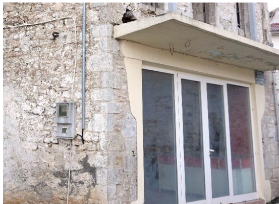
εικόνα 57β: σημερινή κατάσταση, κατασκευή ανοίγματος μεγάλων διαστάσεων
