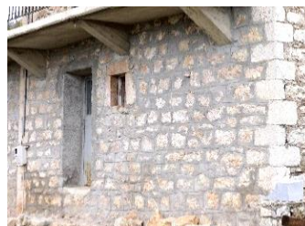
εικόνα 46: κτήριο Δ2_5, αρμολόγηση με τσιμέντο
