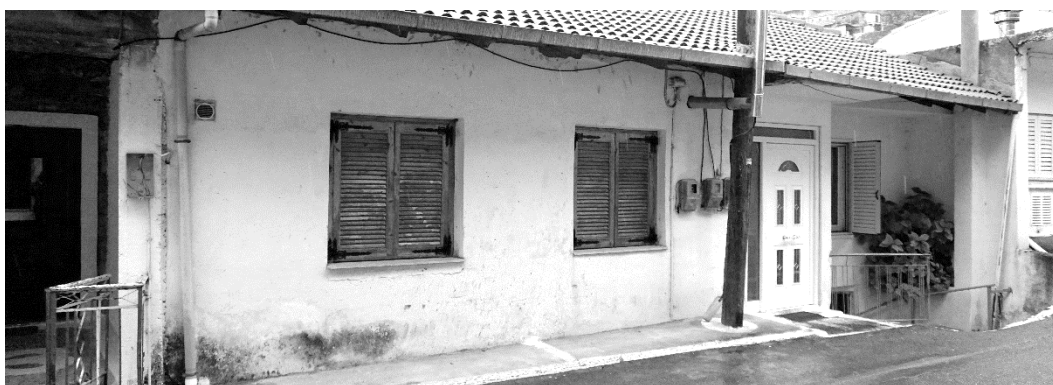
εικόνα 15: κτήριο A3_9, εμφάνιση υγρασίας στο κάτω μέρος της τοιχοποιίας
