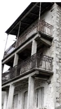
εικόνα 33: κτήριο B3_31, εξώστες από σκυρόδεμα
