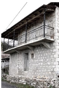
εικόνα 32: κτήριο Δ2_5, εξώστης από σκυρόδεμα και μεταλλικά στοιχεία
