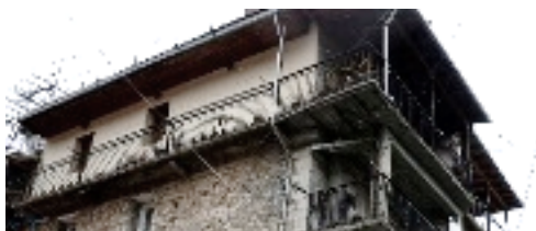
εικόνες 38, 39: κτήρια A4_7, B3_15, μη συμβατές προσθήκες ορόφων από πλίνθινες τοιχοποιίες
