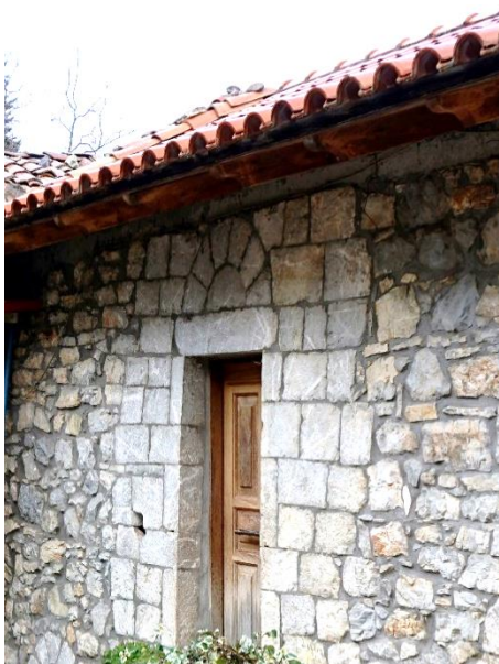
εικόνα 50: κτήριο B2_10, επισκευή λιθοδομής με καλά λαξευμένους λίθους, ήπια επέμβαση
