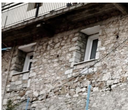
εικόνες 54, 55: κτήρια B3_15, A3_12 μερικό κλείσιμο ανοιγμάτων
