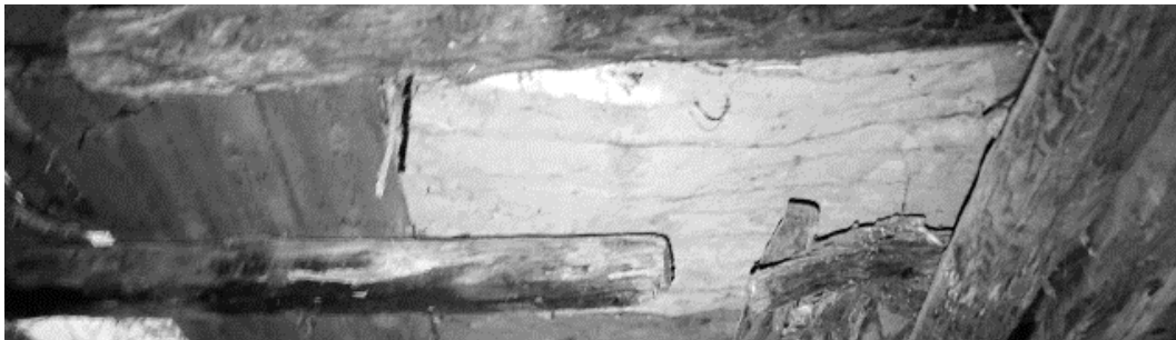
εικόνα 24: κτήριο A2_8, κατάρρευση ξύλινων σανίδων του πατώματος
