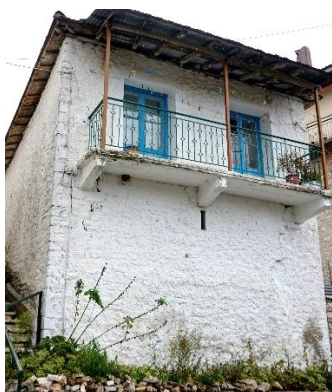
εικόνα 47: κτήριο B3_14, ολική επίχριση στη λίθινη τοιχοποιία
