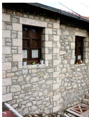
εικόνα 56: κτήριο B2_31, κατασκευή μικρού πλάτους ανοίγματος
