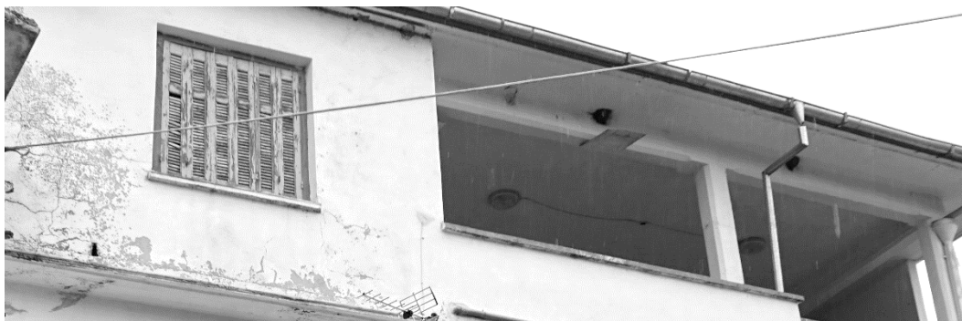
εικόνα 14: κτήριο B3_13, μερική αποκόλληση επιχρίσματος
