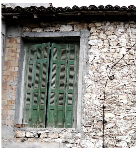
εικόνα 51: κτήριο Δ1_1, επισκευή λιθοδομής με οπτόπλινθους, έντονη επέμβαση
