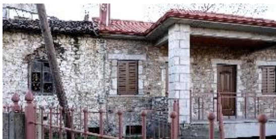
εικόνες 36, 37: κτήρια B2_4, B2_37, μη συμβατές προσθήκες όγκων με διαφορετική στέγη
