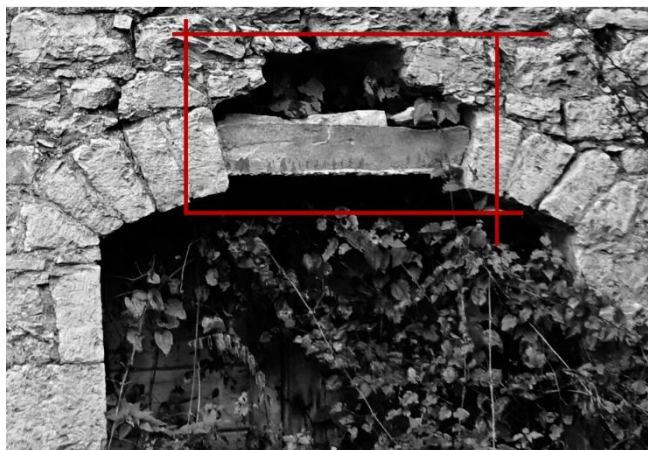
εικόνα 17: κτήριο A2_8, πτώση μεσαίων λίθων του κλειδωτού τόξου
