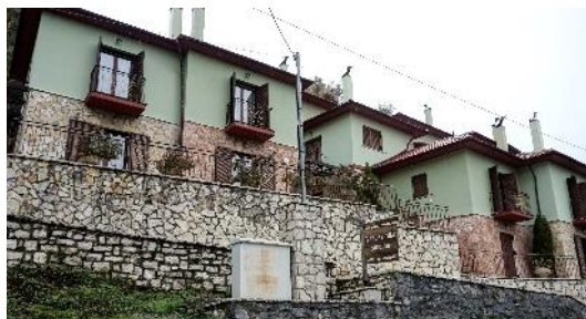
εικόνα 6: κτήριο Γ4_1, λανθασμένη επένδυση και χρωματισμός της τοιχοποιίας
