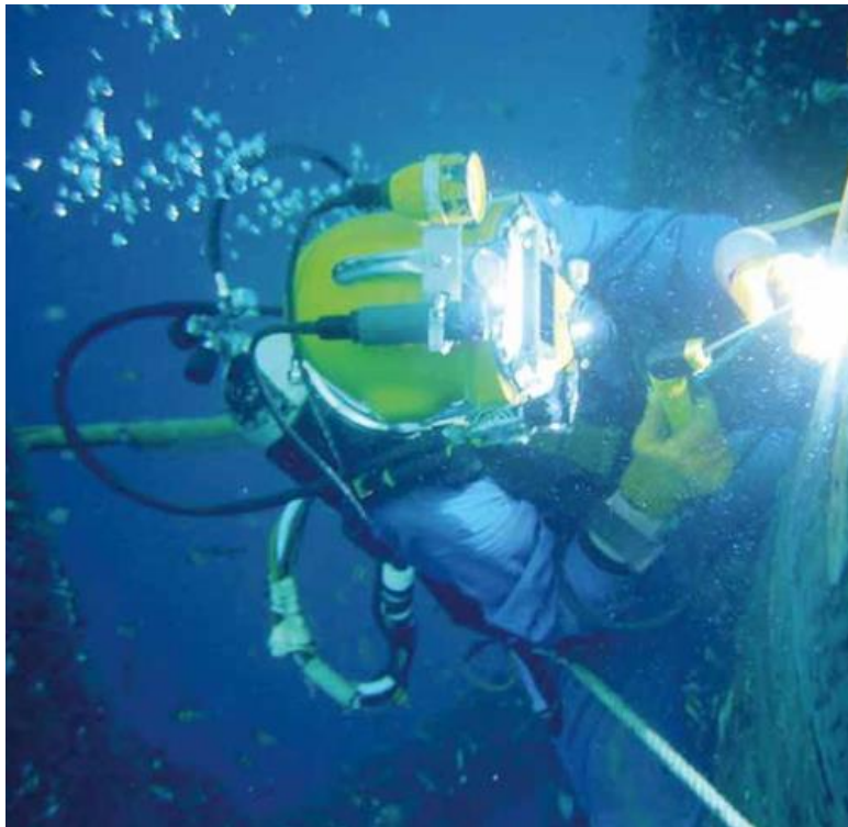
Σχήμα 3.2 Υποβρύχιες εργασίες συγκόλλησης.
