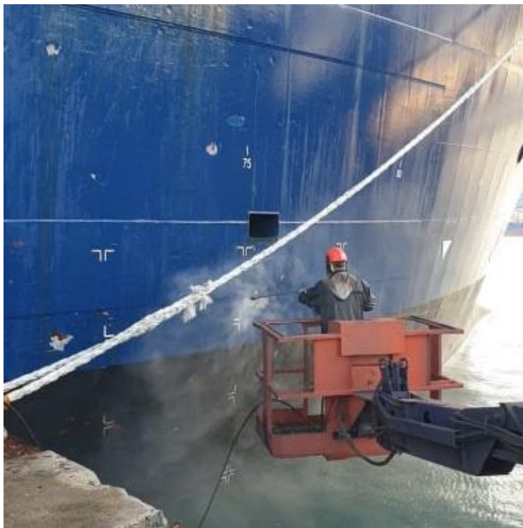
Σχήμα 3.3 Υδροβολιστής κατά τη διάρκεια εκτέλεσης της εργασίας.
