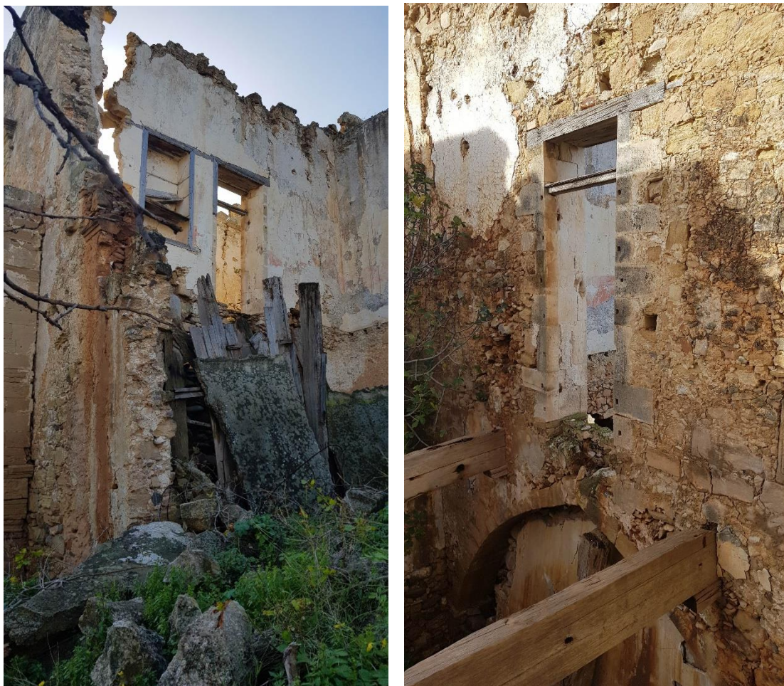
εικ.74, 75_ τοιχοποιία που κατέρρευσε το καλοκαίρι του 2019
