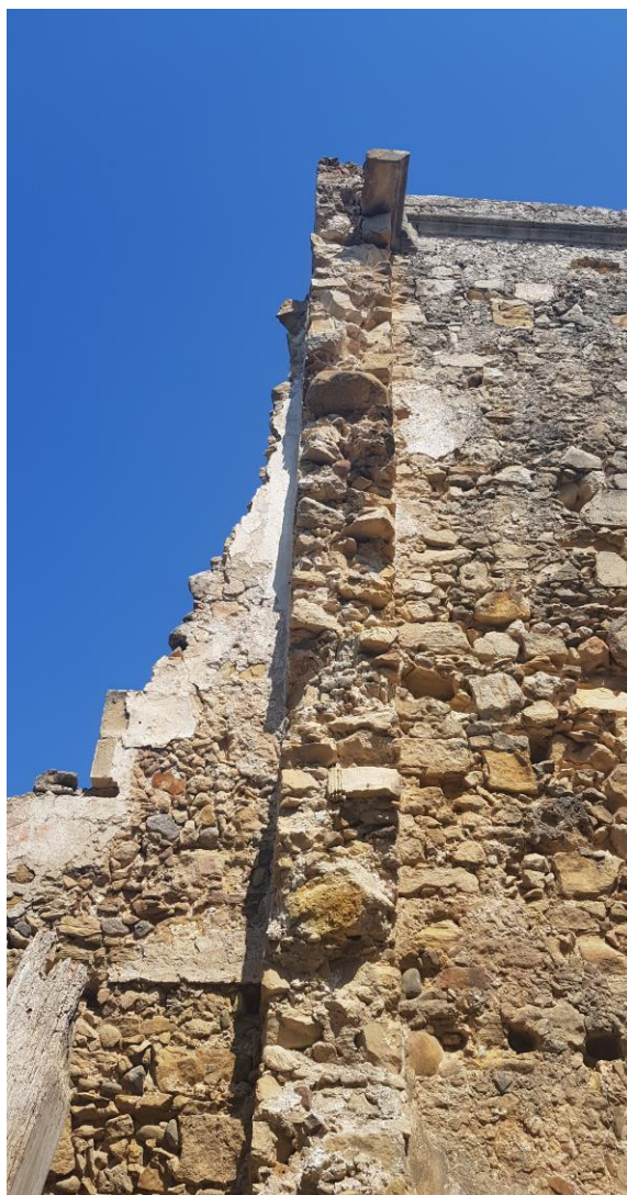
εικ.35_ «τομή» αργολιθοδομής
