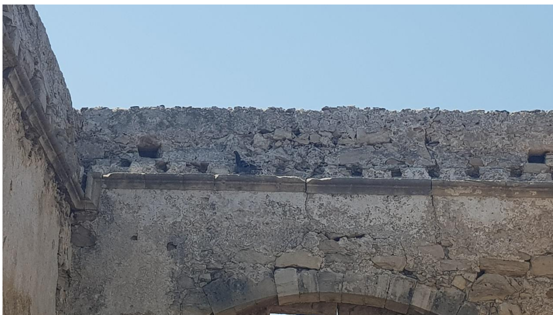
εικ.49_ μοτίβο κορνίζας που ακολουθεί την κατασκευαστική δομή δώματος
