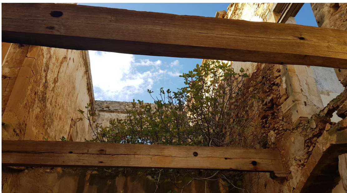
εικ.86_ μεταγενέστερη κατάρρευση τοιχοποιίας (δεξιά στη φωτογραφία)
