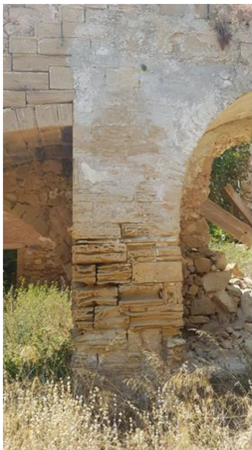
εικ.93_ διάβρωση πωρόλιθου
