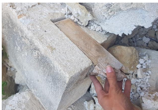
εικ.63_ ξύλινη δοκός στο εσωτερικό πωρόλιθου
