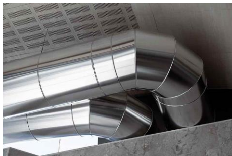
Εικόνα 9: Αγωγοί Συστήματος HVAC
