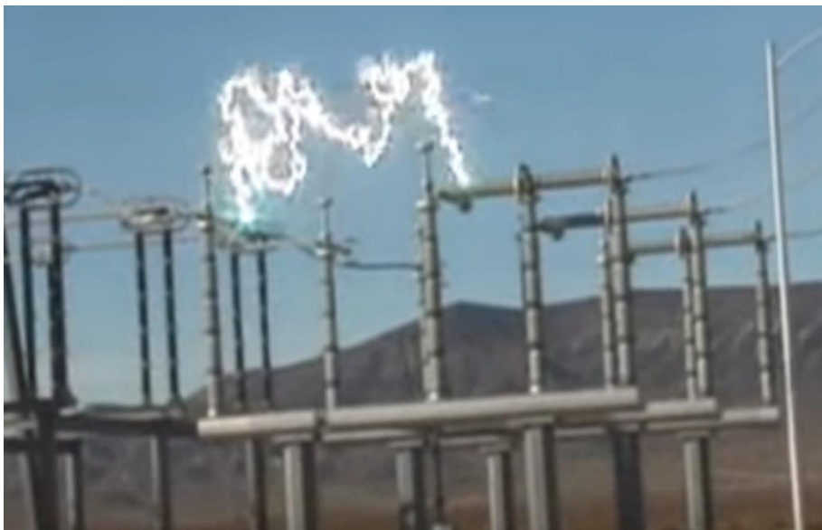
Εικόνα 9 Ηλεκτρικό τόξο σε υποσταθμό μέσης τάσης
