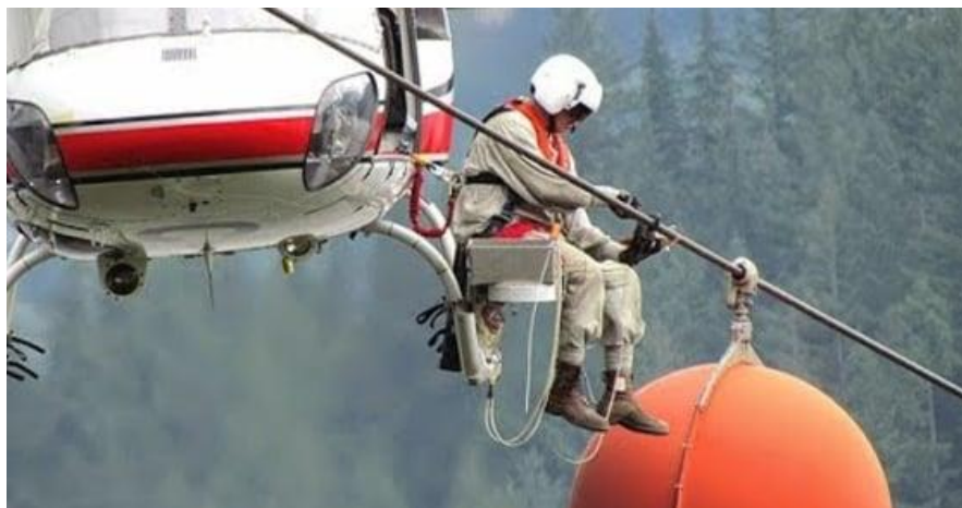
Εικόνα 10 Επιθεώρηση Γραμμής Υψηλής Τάσης - Ελικόπτερο
