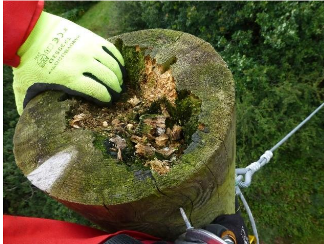
Εικόνα 12 Σαπισμένη κορυφή ξύλινου στύλου
