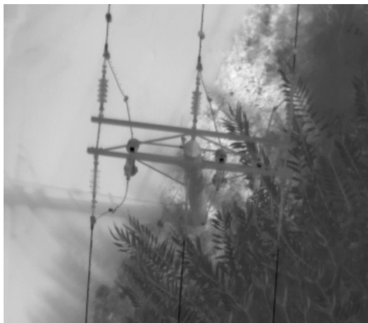
Εικόνα 14 Εικόνα Θερμικού Φάσματος Τραβέρσας Ξύλινου Στύλου Μέσης Τάσης
