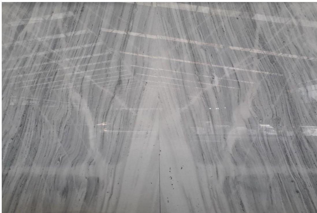
Εικόνα 53: Δημιουργία εικόνας αντικατοπτρισμού με παράταξη "open book" σε κόντρα κομμένο όγκο.
