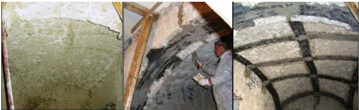
Εικόνα 27. Επέμβαση σε θόλους και καμάρες.
