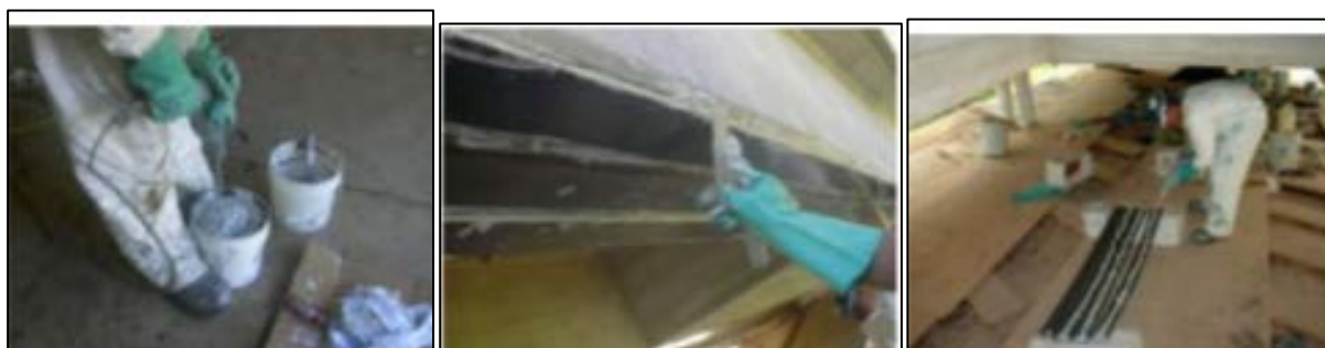
Εικόνα 24. Εφαρμογή CFRP
