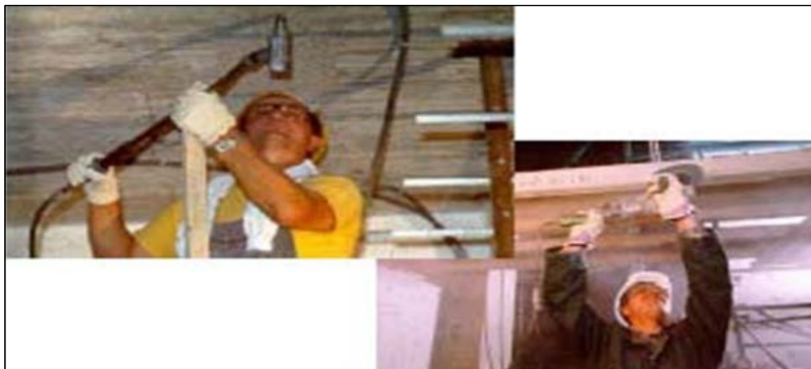
Εικόνα 21. Προετοιμασία επιφάνειας του σκυροδέματος για την εφαρμογή ανθρακονημάτων. (πηγή: SIKΑ HELLAS, 2004)
