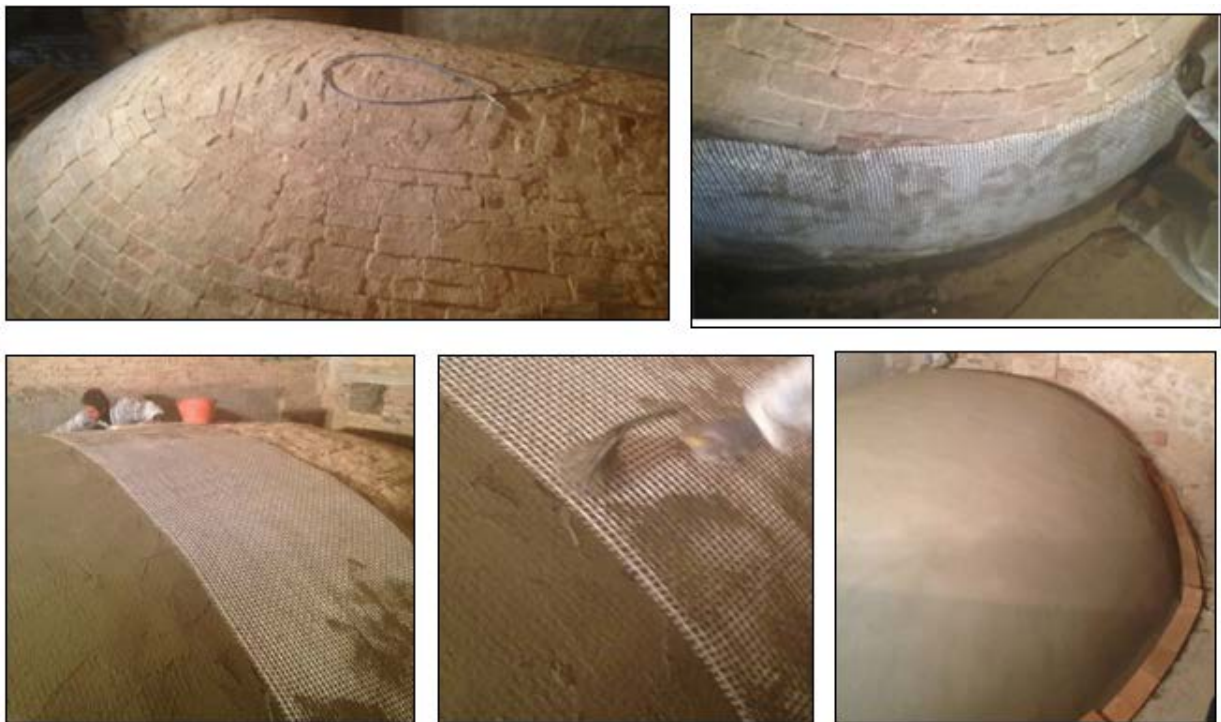
Εικόνα 30. Ενισχυτική επέμβαση σε θόλους.
