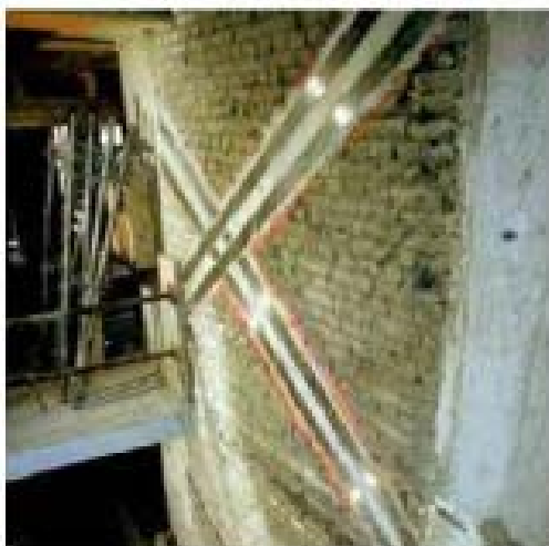
Εικόνα 13. Η τοποθέτηση της ενίσχυσης με FRP
