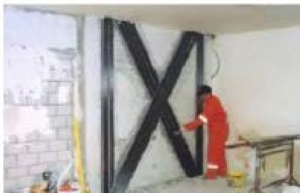
Εικόνα 13. Η τοποθέτηση της ενίσχυσης με FRP
