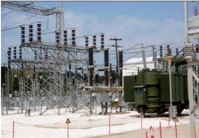
Εικόνα 1.9. : Επίγειος υπαίθριος υποσταθμός ΔΕΗ.
