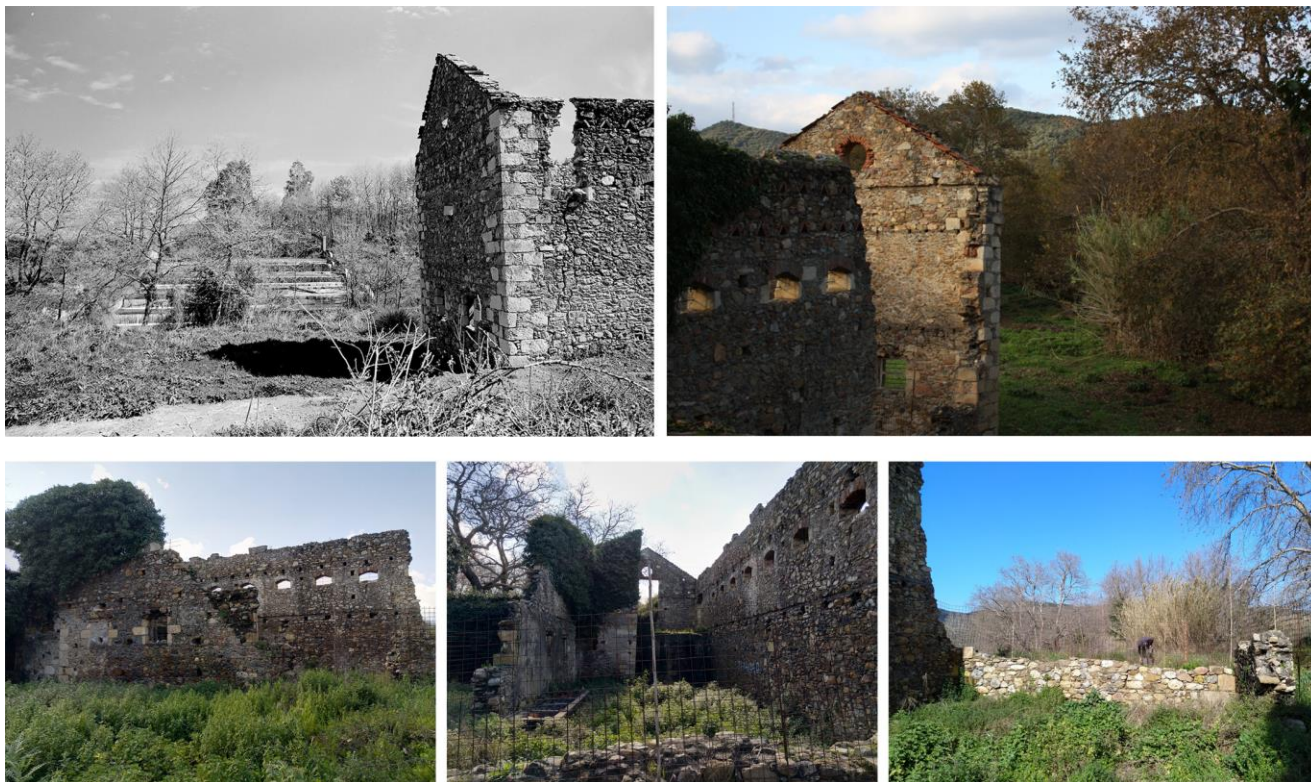
ΕΙΚΟΝΑ 37: Απόψεις από το βόρειο τοίχο, ο οποίος έπεσε ακέραιος στο έδαφος ύστερα από κατακόρυφη ρωγμή (ΠΗΓΗ: αρχείο Α. Χαλκιαδάκης δεκαετία 1990 (πάνω αριστερά), Β. Κοτρώτσου 2015 (πάνω δεξιά), προσωπικό αρχείο (Κάτω))
