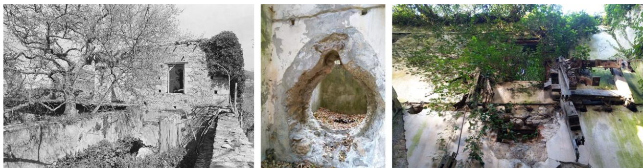
ΕΙΚΟΝΑ 24: Νότια όψη του συγκροτήματος του αλευρόμυλου και του ελαιοτριβείου, όπου φαίνεται η πορεία ροής του νερού προς τα πηγάδια (αριστερά), οι σπές για τα βαράρια στο νότιο τοίχο του συγκροτήματος (κέντρο), και ο μηχανισμός του αλευρόμυλου στον όροφο του συγκροτήματος (δεξιά) (ΠΗΓΗ: αρχείο Α. Χαλκιαδάκη, δεκαετία 1990, προσωπικό αρχείο 2019)
