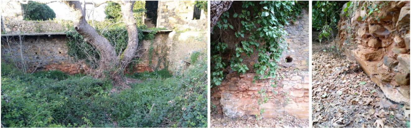
ΕΙΚΟΝΑ 28: Νότια όψη, όπου φαίνεται το σημείο με τους διαφορετικού είδους λίθους και τη γένεση καμάρας (ΠΗΓΗ: προσωπικό αρχείο 2019)
