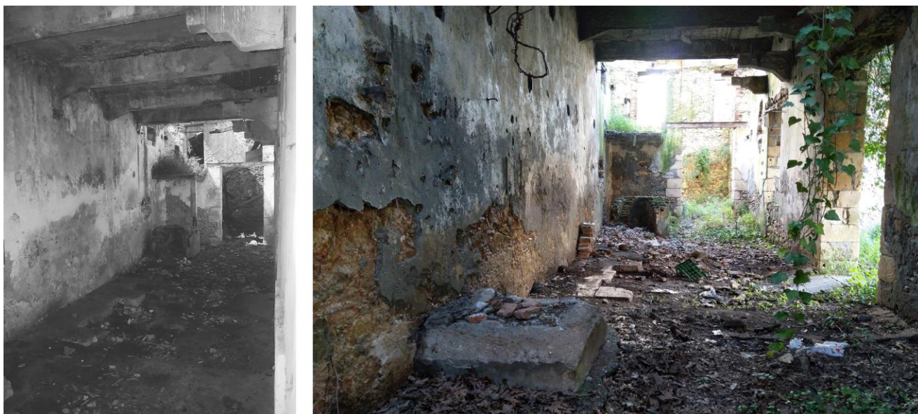
ΕΙΚΟΝΑ 33: Εσωτερική άποψη του χώρου του ελαιοτριβείου, όπου φαίνεται το σημερινό δώμα αντί της δίρριχτης στέγης (ΠΗΓΗ: αρχείο Α. Χαλκιαδάκη, δεκαετία 1990 (αριστερά) και προσωπικό αρχείο 2019 (δεξιά))
