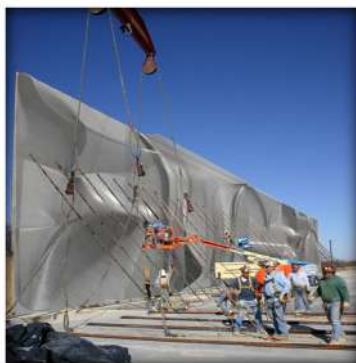
Εικόνα 69 : Υδρό-τοιχος (Hydro wall). Διαδικασία κατασκευής.
