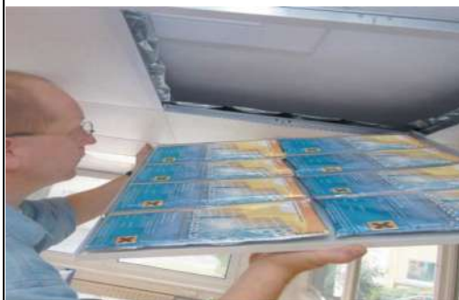
Εικόνα 7 : Εφαρμογή υλικών αλλαγής φάσης σε οροφή κτηρίου
