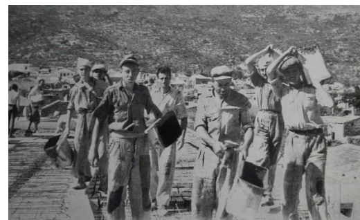
Εικόνα 37. Συνεργείο κατασκευής, μεταφορά μπετόν με τη «ντενέκα», 1938
