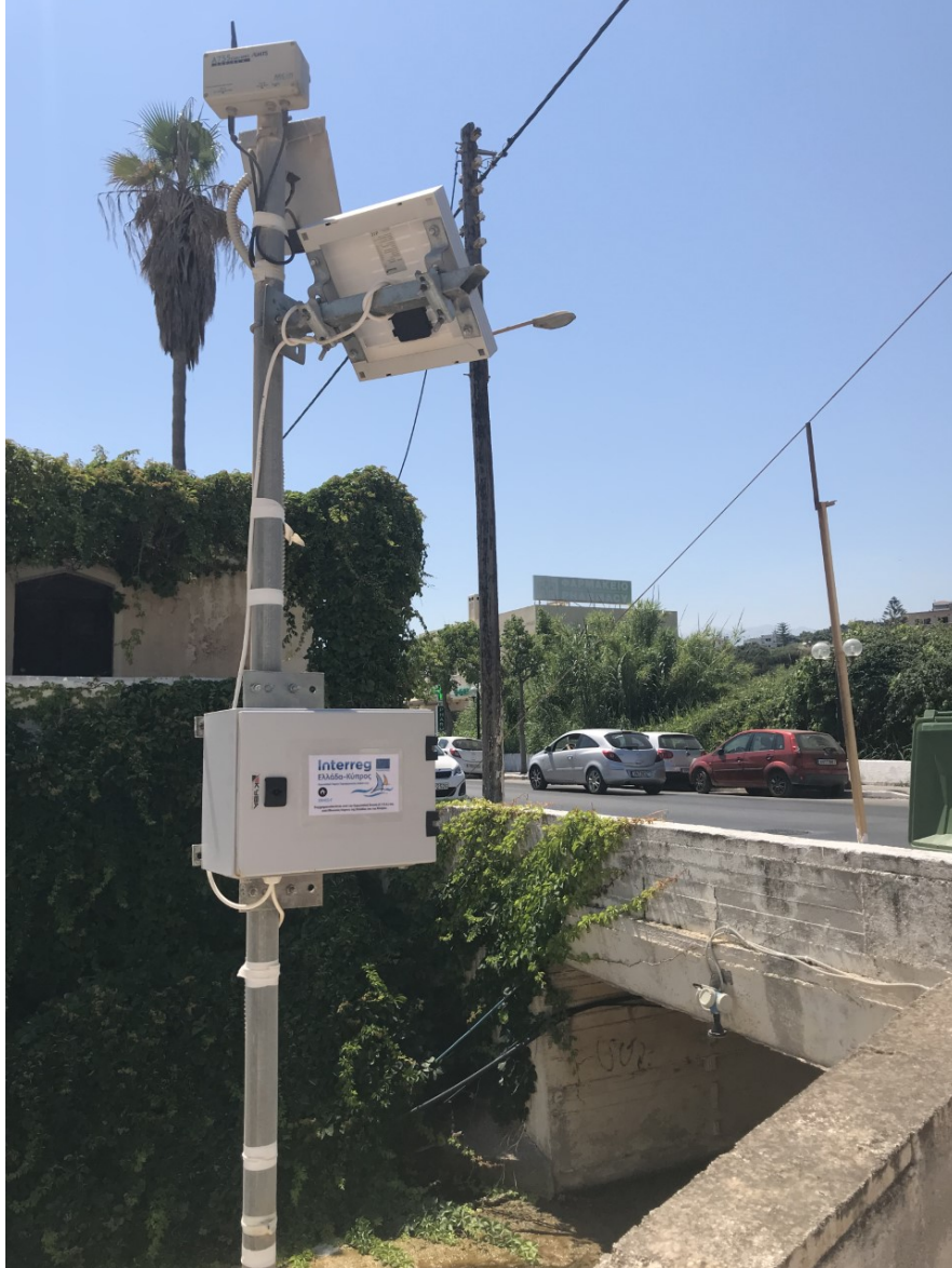
Εικόνα 20: Ο σταθμός μέτρησης στάθμης με Radar, στον Κάτω Σταλό
