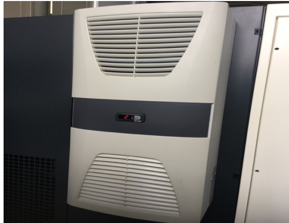
Σχήμα 3.5: Μονάδα ψύξης θαλάμου κατεργασίας
