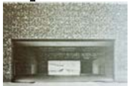
Herzog και de Meuron, Οίκο Dominus, Γούντιθιλ, Καλιφόρνια, 1997. Κατασκευή από συρματοκιβώτιο με γرانίτη
