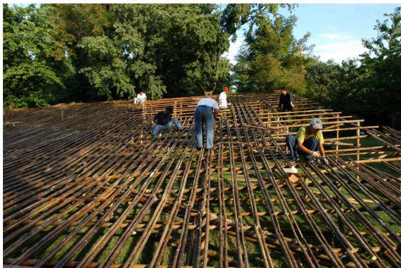
Εικόνα 24 Κατασκευή της βάσης από bamboo
