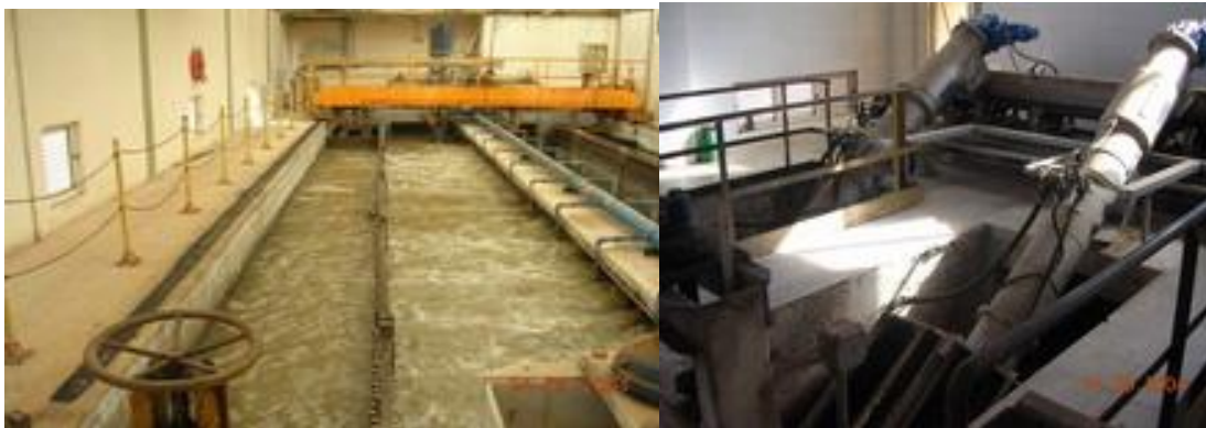
Εικόνα 1.3 Δεξαμενή εξάμμωσης-Λιποσυλλογής και τυπική διάταξη μηχανικής εσχάρωσης (ΔΕΥΑ Χανίων)
