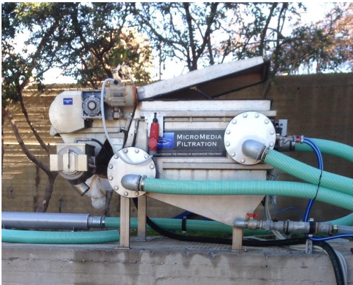
Εικόνα 2.1 Μηχάνημα μικροκόσκινου στην εγκατάσταση επεξεργασίας λυμάτων του Ρεθύμνου (Δ.Ε.Υ.Α.Ρ.) (Μπατιστάτος, 2017)
