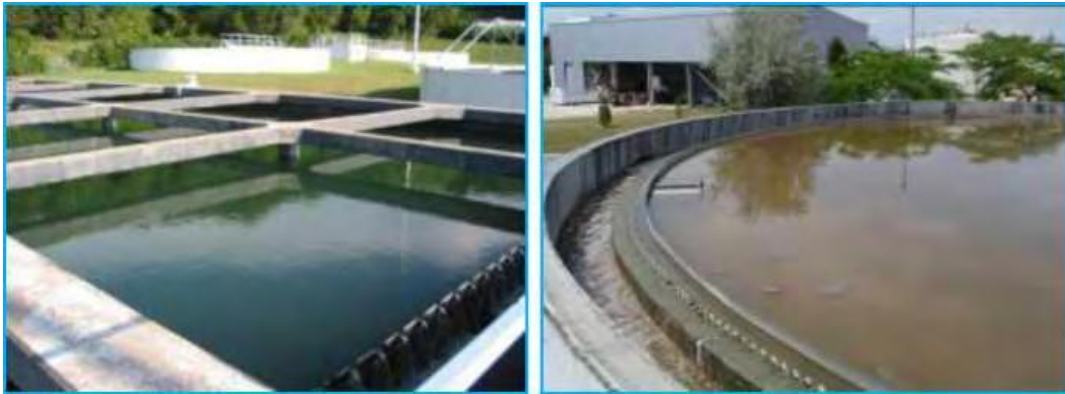
Εικόνα 1.4 Ορθογώνια και κυκλική δεξαμενή καθίζησης
