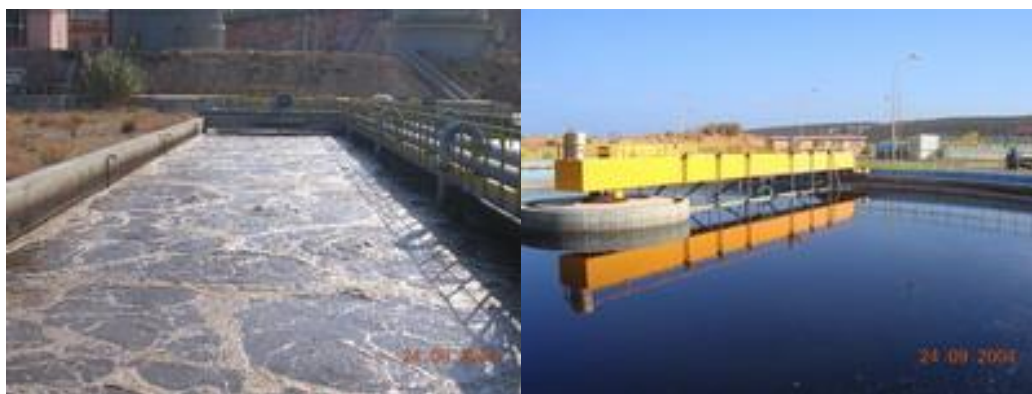
Εικόνα 1.5 Δεξαμενή αερισμού και δεξαμενή δευτεροβάθμιας καθίζησης (ΔΕΥΑ Χανίων)
