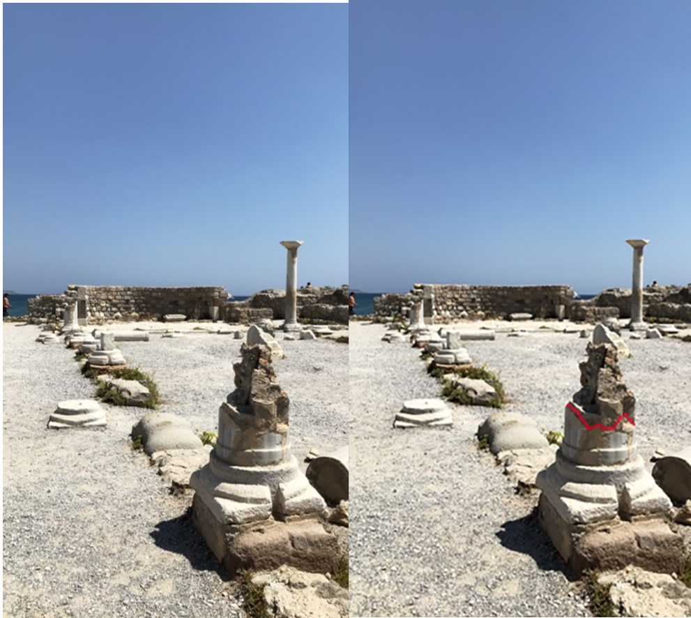
Εικόνα154. Κως, Κέφαλος, Βασιλική Αγίου Στεφάνου σήμερα Πηγή: φωτογράφιση Ζ.Τ, αποκατάστασης. Επισημάνση διάκρισης νέων με αρχαία στοιχεία αποκατάστασης (ορατή μέσω των κόκκινων γραμμών οι οποίες οριοθετούν το νέο -άνω-από το παλιό -κάτω υλικό)
