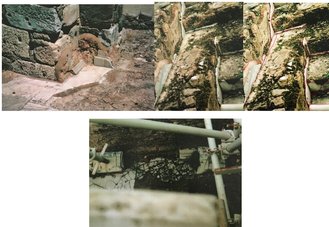
Εικόνα97. Ίχνη κυματίου ορθομαρμάρωσης και μαρμάρινου πλαισίου θύρας καθώς και του λογείου στην ανατολική πάροδο, πηγή: Τεχνική υπηρεσία της Κω. Τρίτη εικόνα επισήμανση των στοιχείων αποκατάστασης με εμφανή χρήση μαρμάρου(ορατή μέσω των κόκκινων γραμμών)
