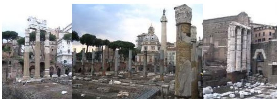
Εικόνα 16. Στερέωση κίωνων ναών Γενήτριας Αφροδίτης (αριστερά) και Άρη Εκδικητή (κέντρο), καθώς και της Ουλπίας Βασιλικής στο Φόρο του Τραϊανού (δεξιά) με εξωτερικές μεταλλικές στεφάνες, Πηγή: Φ.Μαλλούχου- Tufano
