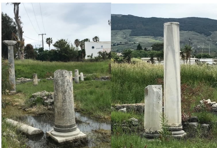
Εικόνα 147. Εικόνα πριν και μετά τις εργασίες αποκατάστασης ενός από τους κίονες της βασιλικής, επισημάνση διάκρισης νέου με αρχαίο υλικό αποκατάστασης(ορατή μέσω των κόκκινων γραμμών)
