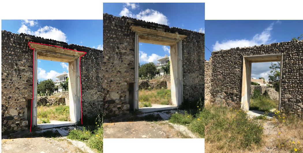
Εικόνα 108. Επισήμανση που αφορά τα σημεία των αποκατάστασεων της εισόδου του βαπτιστηρίου στην ίδια περιοχή σήμερα Πηγή: φωτογραφική Ζ.Τ
