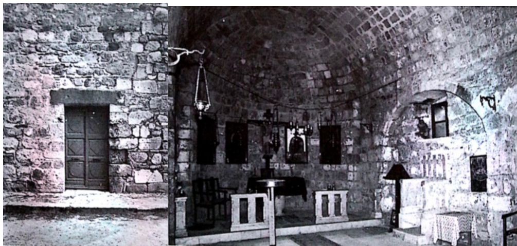
Εικόνα 180. Πόρτα στη βόρεια πλευρά της εκκλησίας με φανερή τη διαφορά της τοιχοποιίας του αρχαίου κομματιού (στα δεξιά της φωτο) τα αποκατεστημένα κομμάτια.(φωτο.Ι.Α.Α), Το εσωτερικό της εκκλησίας μετά την αποκατάσταση,(φωτο. Ι.Α.Α)
