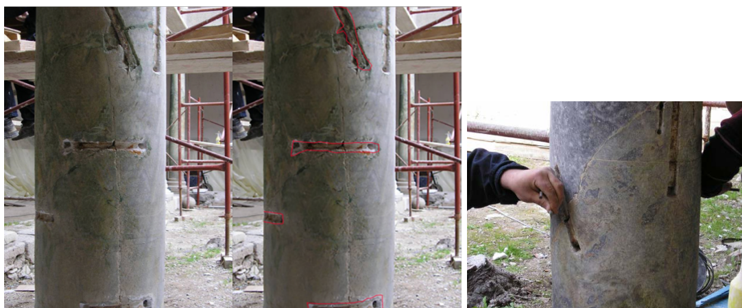
Εικόνα90. Κως, Ρωμαϊκή Οικία , στα αριστερά έχουμε την εικόνα από συγκεκριμένα τμήματα της σιδερένιας ενίσχυσης η οποία τοποθετήθηκε στα πλαίσια της αποκατάστασης από τους Ιταλούς, ενώ στα δεξιά βλέπουμε την αντικατάστασή της από νέα με τιτάνιο. Πηγή-G. Sideris, Il progetto e di risanamento della restaurata "Casa Romana" di Kos , THIASOS , 4, 2015, σελ. 77-94 Μεσαία εικόνα διάκριση των στοιχείων αποκατάστασης όπως οι μεταλλικές ενισχύσεις, (ορατή μέσω των κόκκινων γραμμών)
