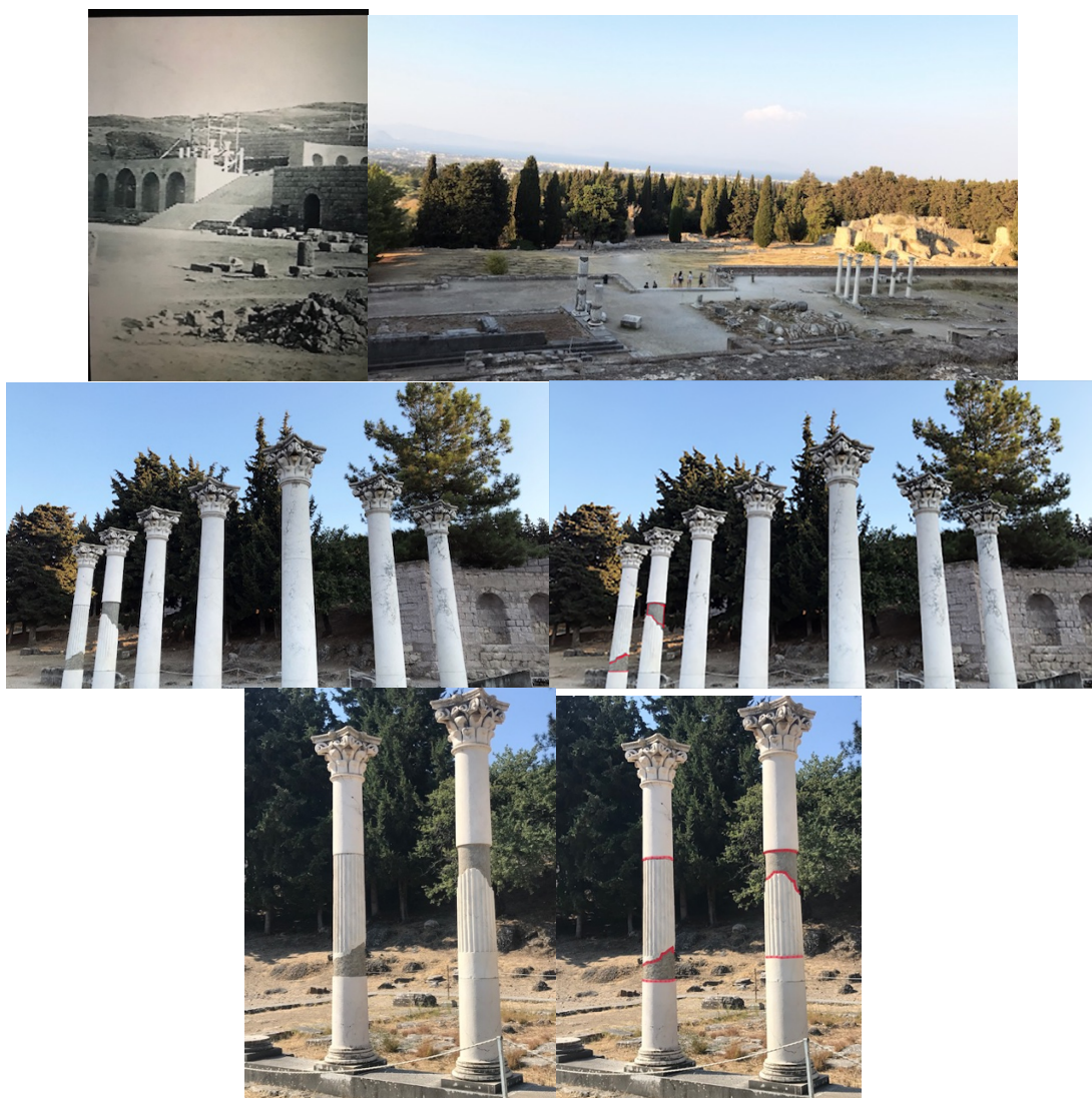
Εικόνα 141. Κορινθιακός ρωμαϊκός ναός C στο μεσαίο άνδρηρο, πηγή: φωτογράφιση Ζ.Τ. Διάκριση νέου και αρχαίου υλικού. (ορατή μέσω των κόκκινων γραμμών εντός των γραμμών, το γκρι χρώμα αποτελεί το νέο υλικό το οποίο χρησιμοποιήθηκε για την ολοκλήρωση των κίωνων)
