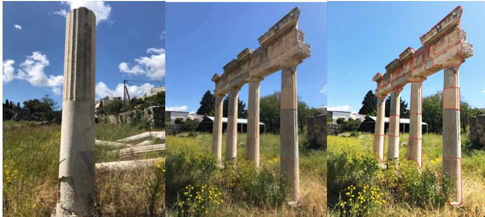
Εικόνα112. Εικόνες των κίωνων σήμερα αλλά και η κατάσταση τους μετά τον σεισμό Πηγή: φωτογράφιση Ζ.Τ, Τρίτη εικόνα διάκριση των σημείων της αποκατάστασης, μεταξύ αρχαίου και νεόυ υλικού (ορατή μέσω των κόκκινων γραμμών)
