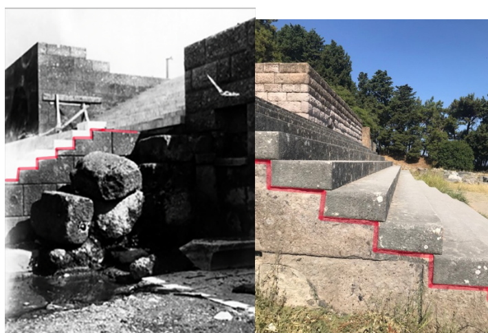
Εικόνα 136. Επισήμανση της διάκρισης των νέων υλικών αποκατάστασης(ορατή μέσω των κόκκινων γραμμών)
