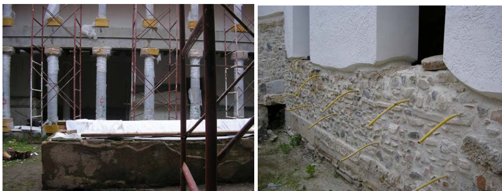
Εικόνα89. Εικόνες από τις εργασίες αποκατάστασης τόσο με ενίσχυση του περιστελίου όσο και με προετοιμασία ενίσχυσης των αρχαίων τοίχων με ενέσεις. Πηγή-G. Sideris, Il progetto e di risanamento della restaurata "Casa Romana" di Kos , THIASOS , 4, 2015, σελ. 77-94.
