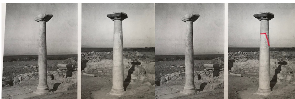
Εικόνα 147. Εικόνα πριν και μετά τις εργασίες αποκατάστασης ενός από τους κίονες της βασιλικής, επισημάνση διάκρισης νέου με αρχαίο υλικό αποκατάστασης(ορατή μέσω των κόκκινων γραμμών)
