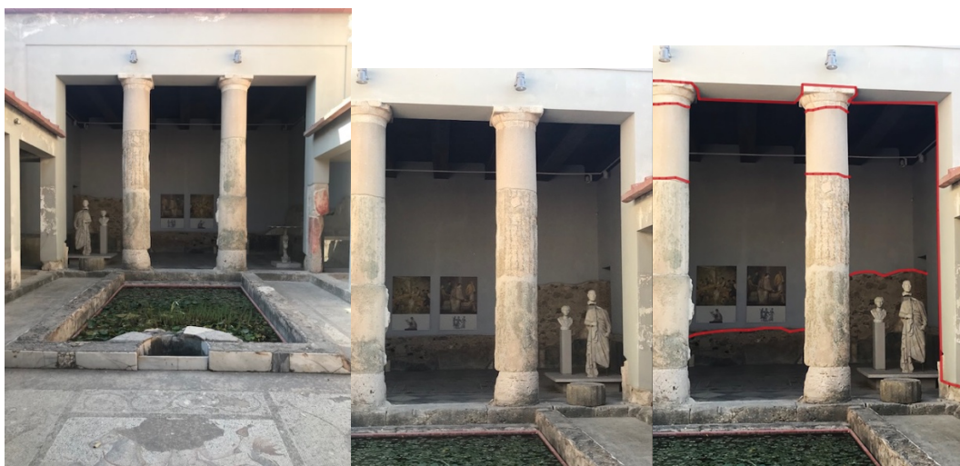
Εικόνα 85. Ρωμαϊκή οικία, πηγή: φωτογράφιση Ζ.Τ., Επισήμανση που αφορά τις νέες προσθήκες μετά την αποκατάσταση(ορατή εντός των κόκκινων γραμμών)
