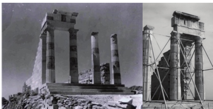
Εικόνα 28 Εικόνα των επεμβάσεων επί Ιταλοκρατίας στον Ναό της Λίνδιας Αθηνάς καθώς και παθολογίες οι οποίες έπρεπε να αντιμετωπιστούν μεταγενέστερα. Βασιλική Ελευθερίου, Νέες επεμβάσεις στο Ναό της Λίνδιας Αθηνάς, Αίτια-Αποτελέσματα μιας ανακατασκευής, 1 ο Πανελλήνιο Συνέδριο Αναστηλώσεων ΕΤΕΠΑΜ, Θεσσαλονίκη 2006.
