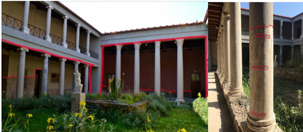
Εικόνα 84.Επισήμανση που αφορά στοιχεία της αποκατάστασης, το νέο και το αρχαίο υλικό (ορατή μέσω των κόκκινων γραμμών με επισήμανση δεξιά των μεταλλικών στοιχείων οριζόντια στον κίονα καθώς και της προσθήκης του νέου υλικού στο επάνω μέρος του)
