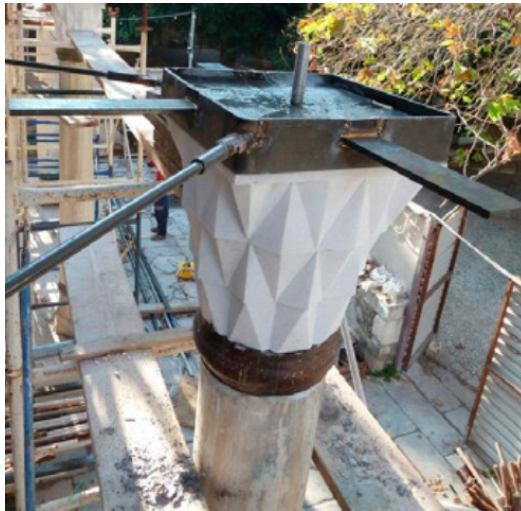
Εικόνα 2.15: Λεπτομέρεια αγκύρωσης του μεταλλικού συστήματος ενίσχυσης του προστώου του οθωμανικού τεμένους Ρετζέπ Πασά στην μεσαιωνική πόλη της Ρόδου κατά την διάρκεια των πρόσφατων εργασιών αποκατάστασης (Μανούσου-Ντέλλα & Ντέλλας, 2017).
