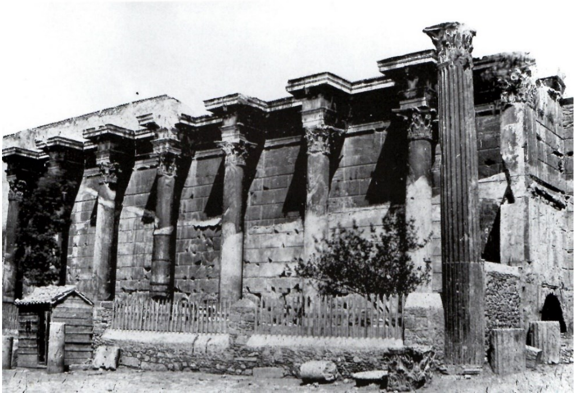
Εικόνα 1.28: Η Βιβλιοθήκη του Αδριανού μετά από τις περιδέσεις του τέταρτου κίονα της βόρειας πτέρυγας της πρόσοψης που έγιναν το 1864. Άποψη από ΝΔ (Μαλλούχου-Τυφانو, 1998).
