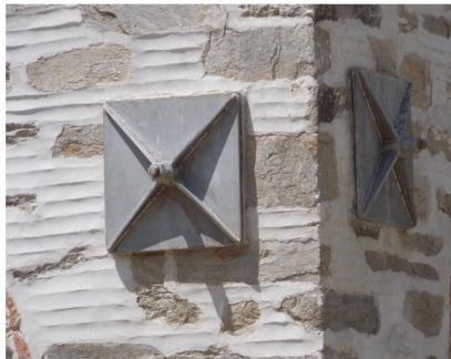
Εικόνα 2.13: Τετραγωνικές πλάκες αγκύρωσης ελκυστήρων με νευρώσεις (Κουφόπουλος, 2014).
