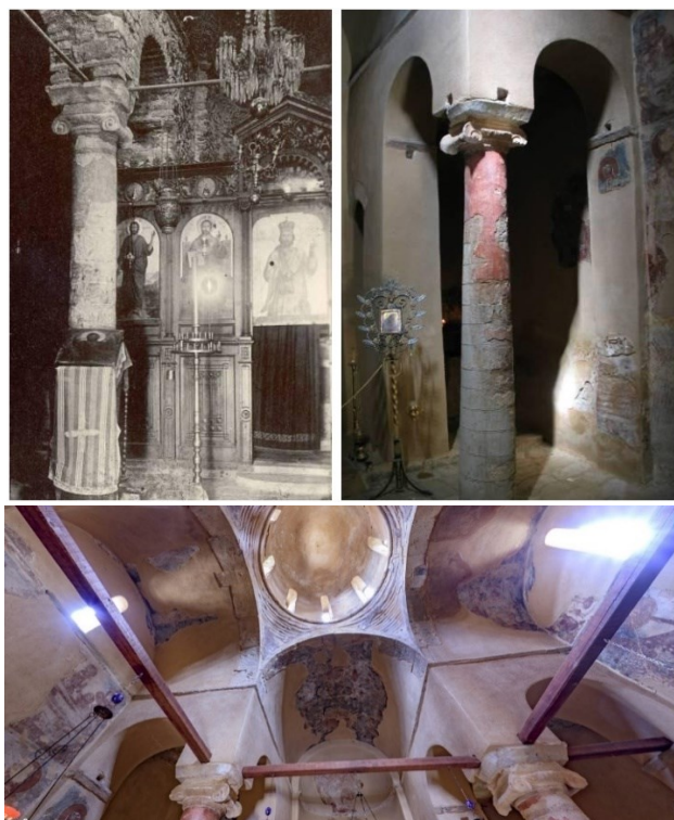
Εικόνα 2.10: Το καθολικό της Ι.Μ. Αστερίου μετά τις επεμβάσεις του Ορλάνδου (άνω αριστερά), πριν την επανατοποθέτηση ξύλινων θλιπτήρων (άνω δεξιά) και σήμερα μετά την επανατοποθέτησή τους (κάτω) (Δρίβα-Δεληνικόλα, 2014) ( http://www.byzantineathens.com/ , 2019).
