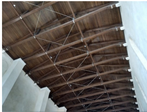
Εικόνα 2.22: Ενίσχυση της ξύλινης στέγης στον Ι.Ν. Αγ. Πέτρου των Δομινικανών στο Ηράκλειο (προσωπικό αρχείο).
