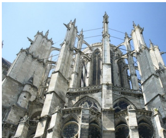
Εικόνα 2.9: Ενίσχυση με ελκυστήρες των λυγρών αντηρίδων του καθεδρικού της Beauvais στη βόρεια Γαλλία, λόγω ανεμοπιέσεων (Architecturefarm, 2014).
