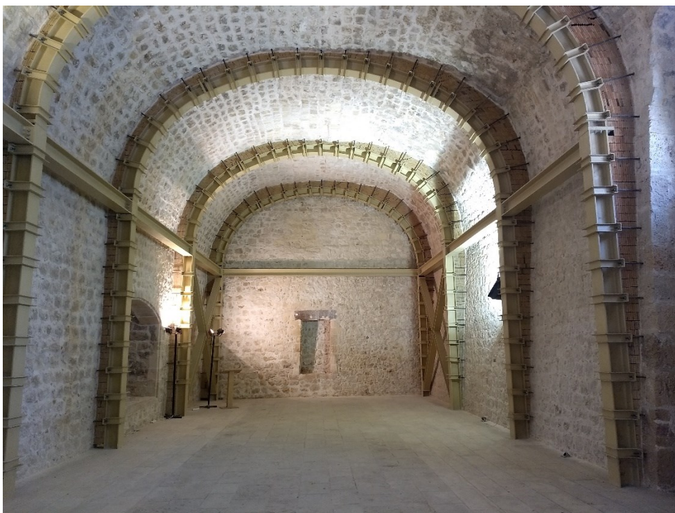
Εικόνα 2.20: Νέος πλαισιακός δομικός φορέας στην Πύλη Παντοκράτορα στο Ηράκλειο (προσωπικό αρχείο).
