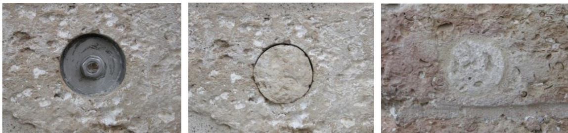
Εικόνα 2.18: Ενσωμάτωση της πλάκας αγκύρωσης του ελκυστήρα στην εξωτερική παρειά της λιθοδομής του Ι.Ν. Σωτήρος στο Αλεποχώρι Μεγαρίδος (Κουφόπουλος, 2014).
