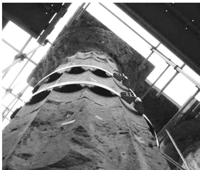
Εικόνα 1.5: Περίδεση κίονα με δακτύλιο από τιτάνιο σε αρχαιοελληνικό ναό της Σικελίας (Fabbrocino, Iervolino, & Manfredi, 2006).
