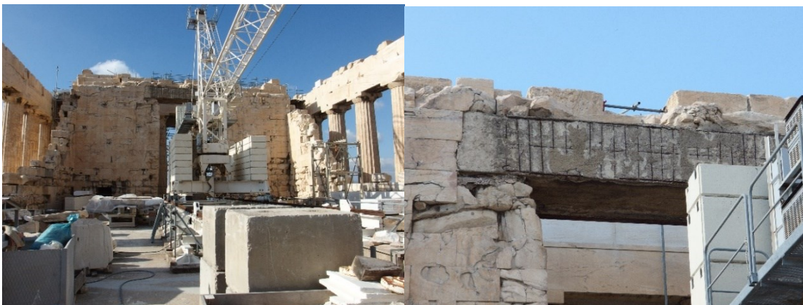
Εικόνα 3.2: Εσωτερική άποψη του δυτικού τοίχου του σηκού του Παρθενώνα και της θύρας του, τον Δεκέμβριο του 2018, όπου στο υπέρθυρο διακρίνεται η δοκός εμφανούς οπλισμένου σκυροδέματος της επέμβασης Μπαλάνου (προσωπικό αρχείο).
