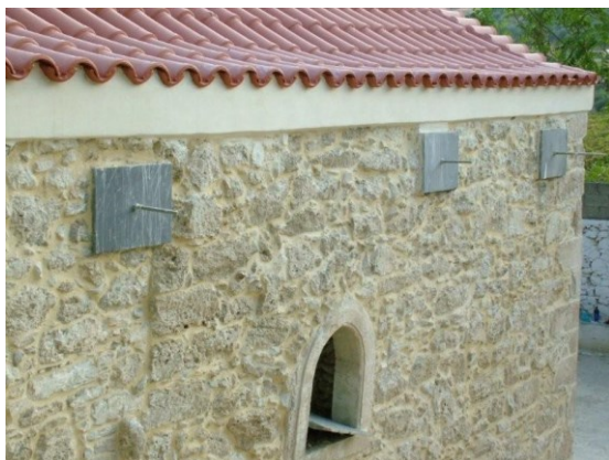
Εικόνα 5.58: Εγκατάσταση ελκυστήρων στον Ι.Ν. Αγίας Παρασκευής στον Αγ. Μύρωνα το 2007.
