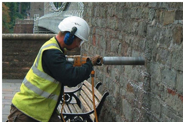
Εικόνα 2.12: Διάτρηση τοιχοποιίας με δράπανο χειρός και χρήση κεφαλών από διαμάντια.
