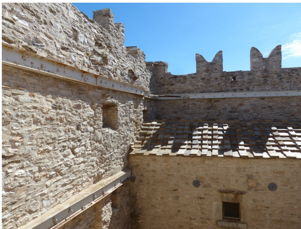
Εικόνα 2.21: Διαζώματα από χάλυβα στην Ι.Μ. Φωτοδότη Χριστού στη Νάξο (αρχείο Κλ. Ασλανίδη).
