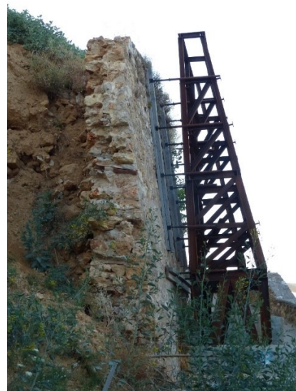
Εικόνα 5.59: Αποτελεσματική αντιστήριξη με τη χρήση μεταλλικών αντηρίδων στο ενετικό τείχος των Χανίων, το ενδιάμεσο τμήμα μεταξύ διαδοχικών αντηρίδων κατέρρευσε από έντονες βροχοπτώσεις το 2019 (αρχείο Κλ. Ασλανίδη)
