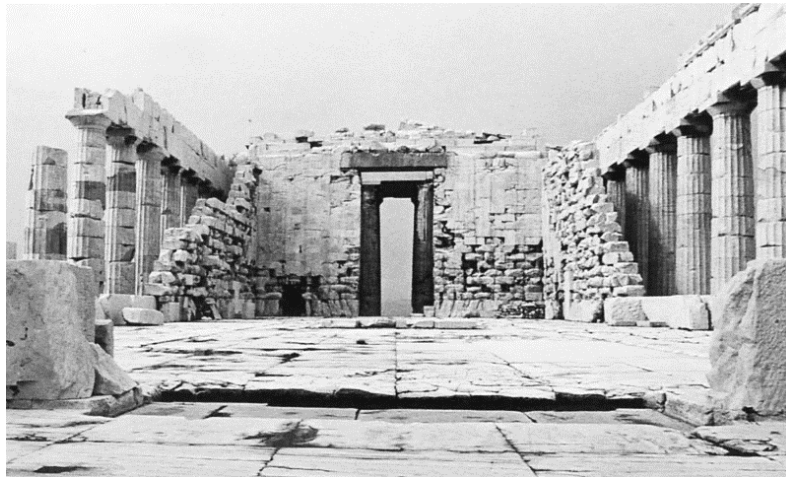
Εικόνα 3.1: Ο δυτικός τοίχος του σηκού του Παρθενώνα μετά την επέμβαση του Μπαλάνου το 1926 (αρχείο ΥΣΜΑ).
