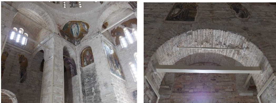
Εικόνα 3.4: Μεταλλικές ενισχύσεις στο εσωτερικό του καθολικού της Ι.Μ. Δαφνίου (προσωπικό αρχείο).
