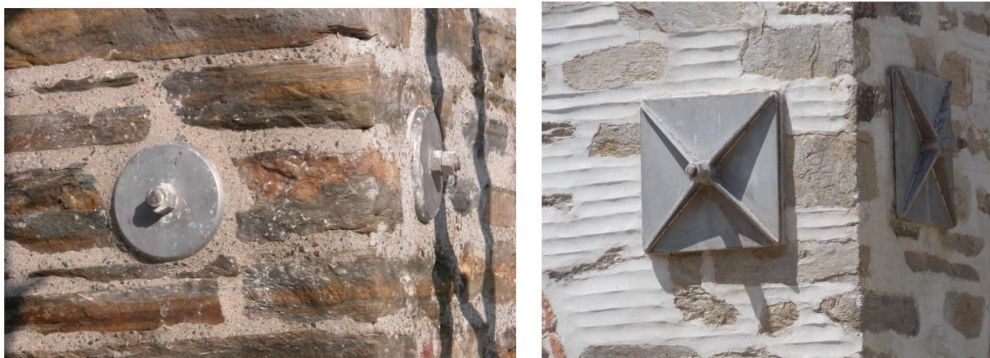
Εικόνα 2.17: Σύγχρονες αγκυρώσεις ελκυστήρων με πλάκες αγκύρωσης κυκλικού και τετράγωνου σχήματος με νευρώσεις (Κουφόπουλος, 2014).
