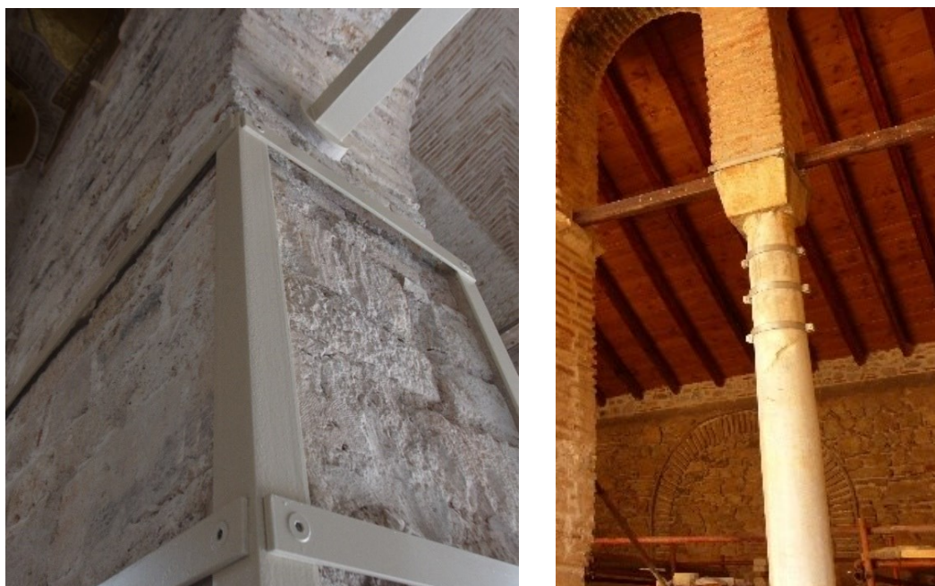
Εικόνα 2.19: Περίδεση πεσσών του καθολικού της Ι.Μ. Δαφνίου με μεταλλικό κλωβό (προσωπικό αρχείο) και τριπλή περίσφιξη κίονα στο Καθολικό της Ι.Μ. Οσίου Λουκά στην Βοιωτία (αρχείο Κλ. Ασλανίδη).
