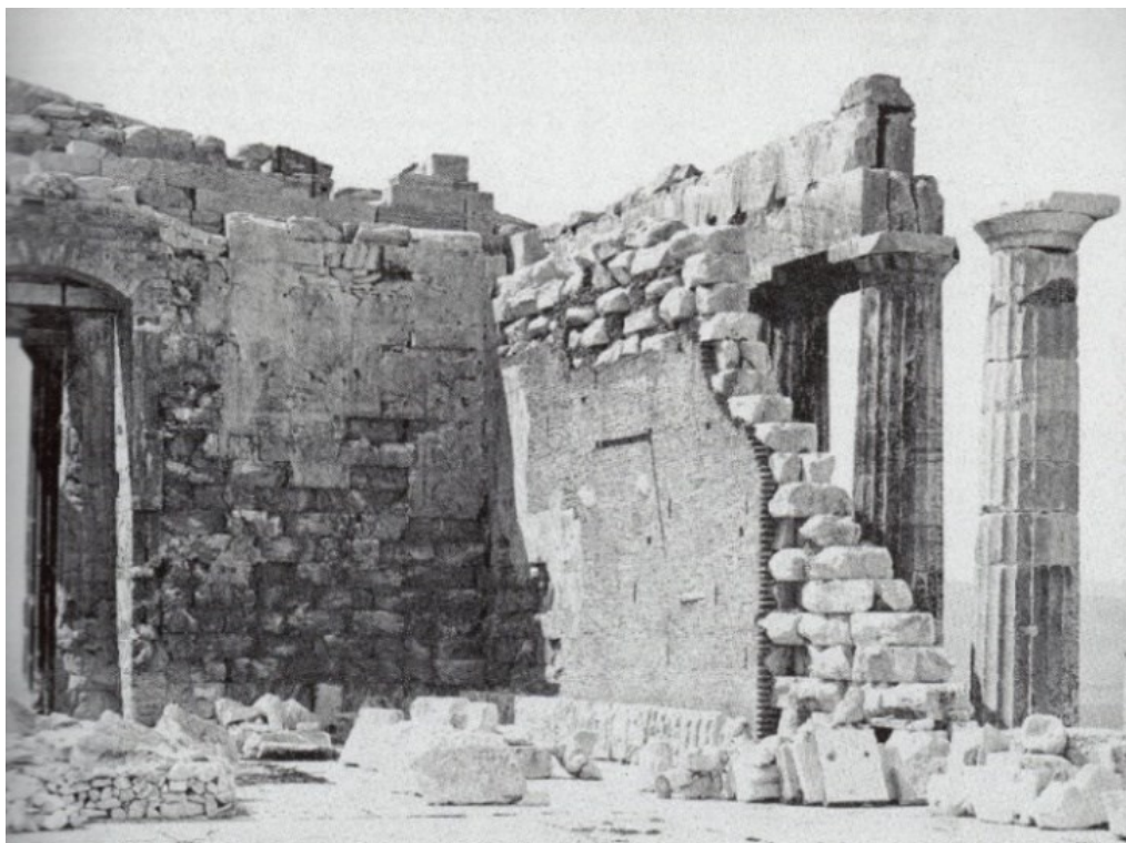
Εικόνα 1.26: Η οπτοπλινθοδομή στο εσωτερικό του βόρειου τοίχου του Παρθενώνα κατά το 1872 (Μαλλούχου-Tufano, 1998).
