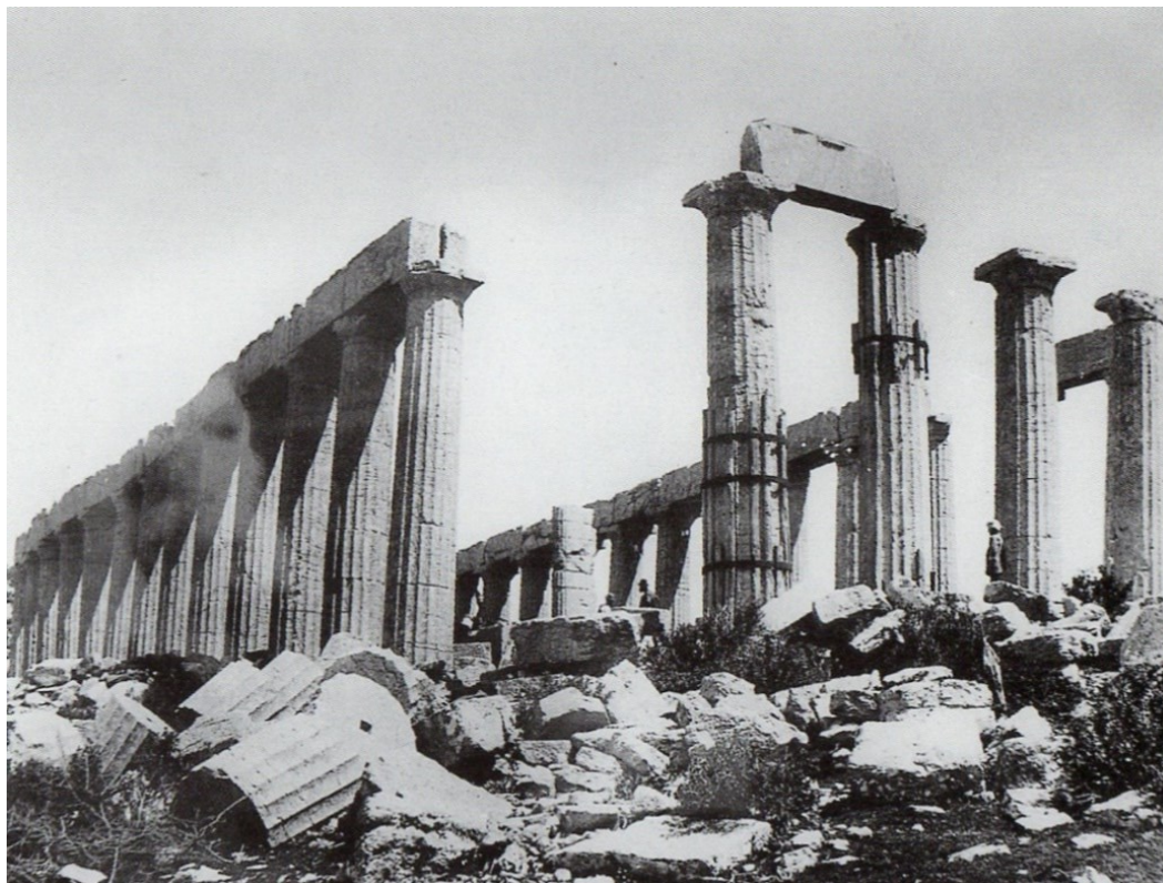
Εικόνα 1.30: Ο ναός του Επικουρίου Απόλλωνα το 1891 μετά την περίδεση των κίωνων του το 1880. Άποψη από ΝΔ (Μαλλούχου-Tufano, 1998).
