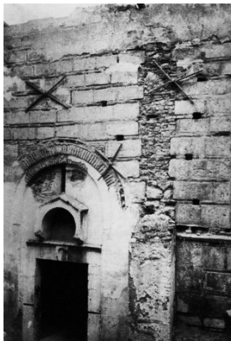
Εικόνα 1.32: Τα κλειδιά των ελκυστήρων στον νάρθηκα του Καθολικού της μονής Δαφνίου που τοποθετήθηκαν το 1893 (Χλέπα, 2011).
