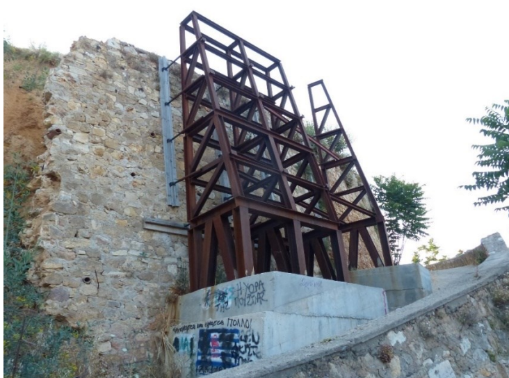
Εικόνα 5.59: Αποτελεσματική αντιστήριξη με τη χρήση μεταλλικών αντηρίδων στο ενετικό τείχος των Χανίων, το ενδιάμεσο τμήμα μεταξύ διαδοχικών αντηρίδων κατέρρευσε από έντονες βροχοπτώσεις το 2019 (αρχείο Κλ. Ασλανίδη)
