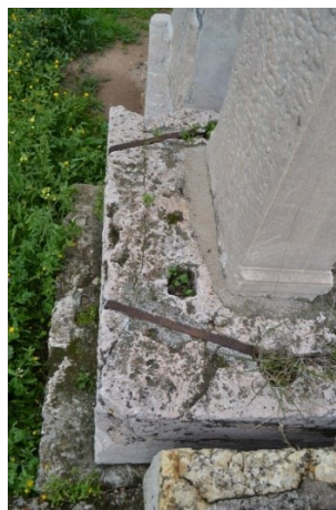
Εικόνα 2.23: Συνδετήριοι σύνδεσμοι σε βάθρο επιτύμβιας στήλης από τον Κεραμεικό της Αθήνας (αρχείο Κλ. Ασλανίδη).
