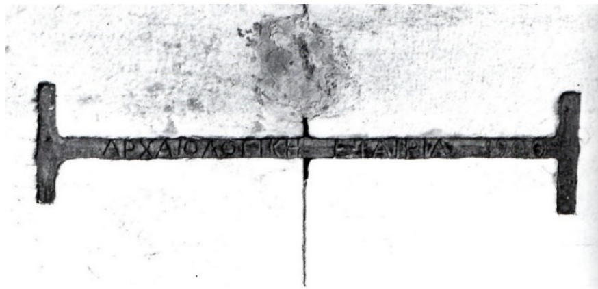
Εικόνα 1.4: Παράδειγμα συνδέσμου της επέμβασης του Νικ. Μπαλάνου το 1898-1902 στην Ακρόπολη (Μαλλούχου-Τufano, 1998).
