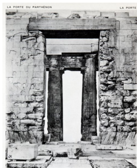
Εικόνα 1.33: Η ανατολική άποψη της δυτικής θύρας του Οπισθοναού του Παρθενώνα μετά την επέμβαση Μπαλάνου το 1926 (Μπαλάνος, 1940).
