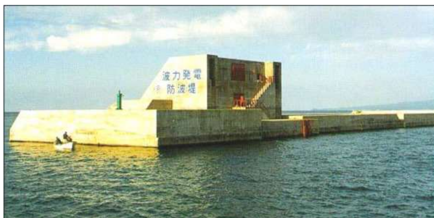
Εικ. 2.31 Συσκευή ΠΣΥ ενσωματωμένη σε κυματοθραύστη στο λιμάνι στην περιοχή Σακάτα της Ιαπωνίας 1990 [A21]
