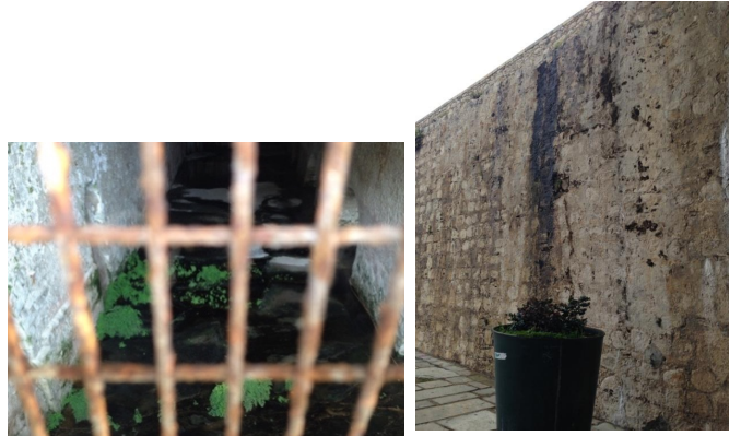
Εικ. 126 & 127: Αποικισμός επί της τοιχοποιίας και εντός της δεξαμενής Ζάνε μικροοργανισμών όπως βακτήρια, άλγη και μούχλα (προσωπικό φωτ. αρχείο).
