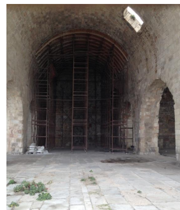
Εικ. 136: Ενισχυτική υποστήλωση του ανατολικού θόλου των Δυτικών Νεωρίων, λήψη από βόρεια (προσωπικό φωτ. αρχείο).
