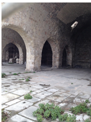
Εικ. 137: Ανάπτυξη βλάστησης στην πλακόστρωση των Δυτικών Νεωρίων (προσωπικό φωτ. αρχείο).
