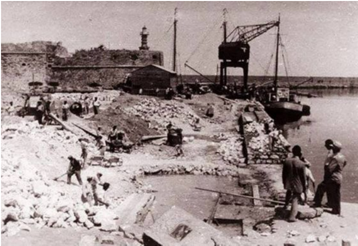
Εικ. 115: Εργασίες καθαίρεσης του Μικρού Κούλε το 1936, για τη δημιουργία νέας προβλήτας (πηγή: https://gr.pinterest.com/pin/677088125206671996/ ).
