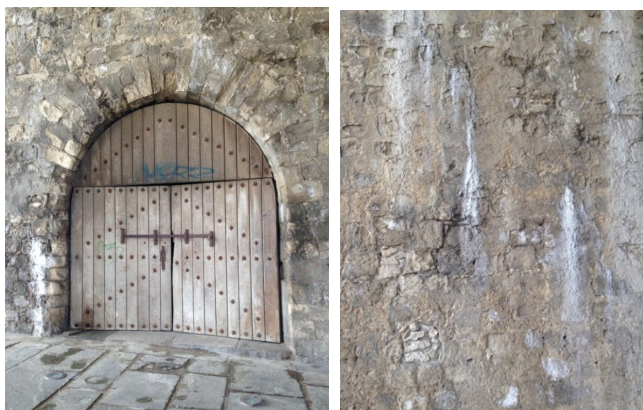
Εικ. 124 & 125: Αποχρωματισμοί και εναποθέσεις αλάτων στα δομικά υλικά της τοιχοποιίας (προσωπικό φωτ. αρχείο).
