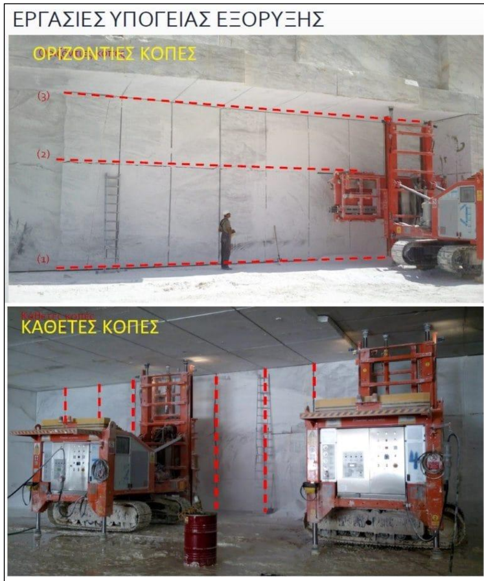
Σχήμα 1. 8: Υπόγειες εξορυκτικές εργασίες με την χρήση σύγχρονου εξοπλισμού (αλυσοπρίονου), FHL Κυριακίδης ΑΒΕΕ
