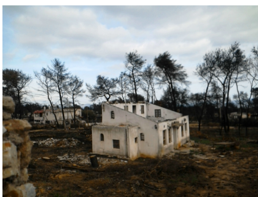
Σχήμα 4.4: Προκατασκευασμένο κτίριο, χαρακτηρισμένο ως κίτρινο. Περιοχή: Μάτι
