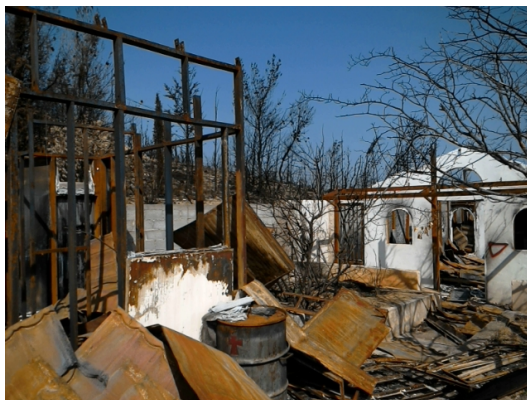
Σχήμα 4.5: Προκατασκευασμένο κτίριο, χαρακτηρισμένο ως κόκκινο. Περιοχή: Μάτι
