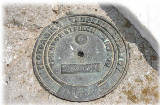
Σχήμα 5.3: Μεταλλική πλακέτα με τις πληροφορίες του βάθρου ( www.tamos.gr )
