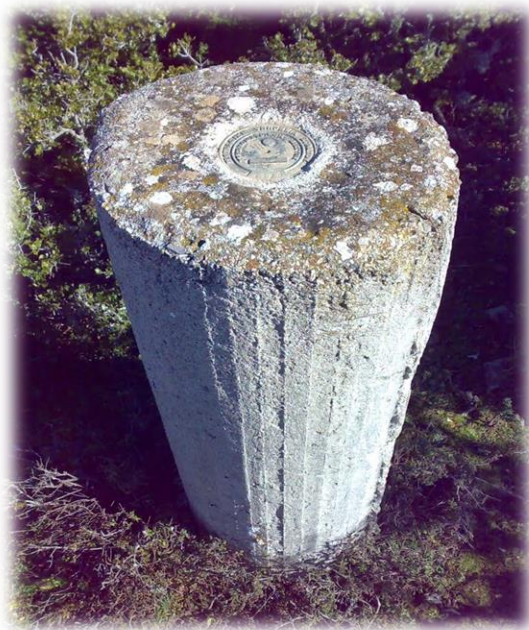
Σχήμα 5.2: Εγκατεστημένο τριγωνομετρικό βάθρο ( http://survemmanouil.blogspot.com )
