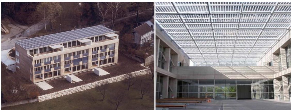
Εικόνα 1.3: Στη δεξιά εικόνα παρουσιάζεται η εγκατάσταση thin film BIPV σε μη διαφανή οροφή κτιρίου στη Ζυρίχη της Ελβετίας (Αnon., 2011). Στη αριστερή εικόνα παρουσιάζεται η εγκατάσταση μιας σειράς Semi transparent BIPV στην πόλη Φένλο της Ολλανδίας (Swiss BiPV Competence Centre, 2011).
