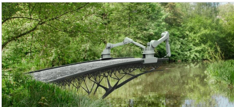
Εικόνα 3: Κατασκευή γέφυρας μέσω της αξιοποίησης των τεχνολογιών AM από την εταιρία MX3D.
