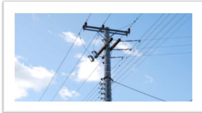
Εικόνα 1.3.1.1: Γραμμή μέσης τάσης, αναρτημένη στον ίδιο στύλο με γραμμή χαμηλής τάσης (Διπλωματική εργασία: Μελέτη αντικεραυνικής συμπεριφοράς εναέριων γραμμών διανομής ηλεκτρικής ενέργειας στην περιοχή της Καλαμάτας, Νικόλαος Μακρυγιάννης)
