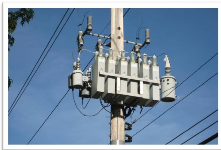
Εικόνα 1.3.4.5: Πυκνωτής σε κολώνα ΔΕΗ
