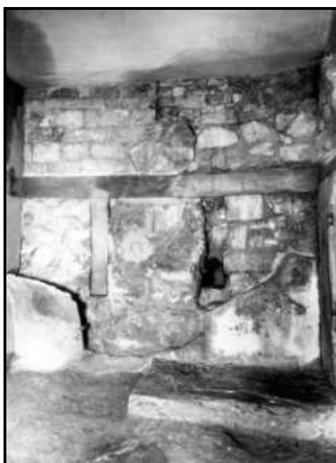
Εικόνα 287. Νότιος τοίχος Καλλωπιστηρίου τῆς Βασιλίσσης τοῦ Ανακτόρου Κνωσοῦ μετά τήν στερέωσιν καί ἀποκατάστασιν τῶν δοκῶν. Πηγή: Αρχεῖο Ν. Πλάτωνος (Φάκελος 1956). Λεζάντα Ν.Πλάτωνος
