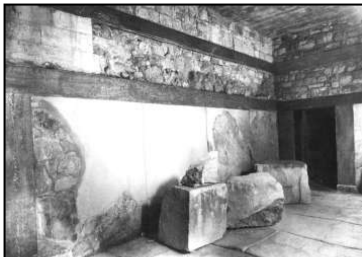
Εικόνα 275. Αποκατάστασις γυψολιθικών ὀρθομαρμαρώσεων καί ξυλοδεσιών τοῦ ίσογείου τοῦ Μεγάλου Κλιμακοστασίου. Πηγή: Αρχείο Ν. Πλάτωνος (Φάκελος 1956). Λεζάντα Ν.Πλάτωνος
