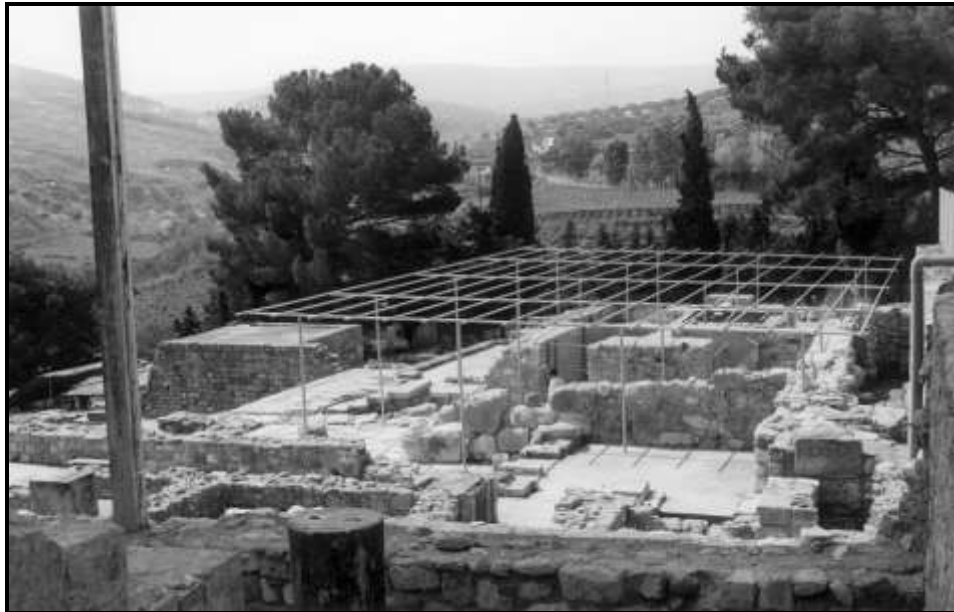
Εικόνα 299. Το υπό κατασκευή στέγαστρο της περιοχής του Ιερού Διπλών πελέκεων Κνωσού. Πηγή: Αρχείο Ν. Πλάτωνος (Φάκελος Διάφορα)
