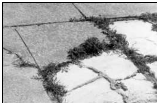
Εικόνα 148. Παράδειγμα αυτοφυούς βλάστησης σε επιδαπέδια γυψολίθινη πλάκα στην Κνωσό. Πηγή: Αρχείο Ν. Πλάτωνος (Φάκελος Διάφορα). Χωρίς Χρονολογία (XX)
