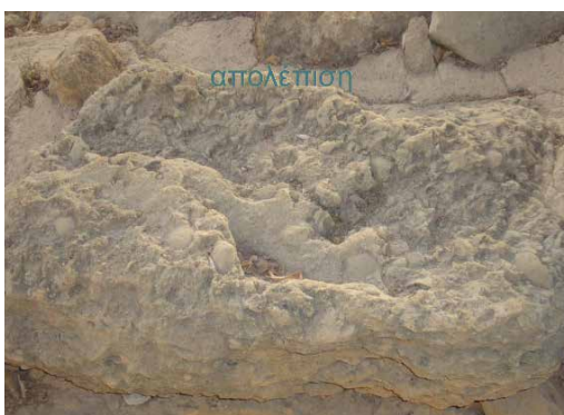
Εικόνα 1.1: Απολέπιση επιφάνειας [1]
