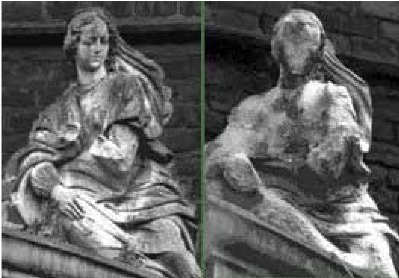
Εικόνα 1.2 Γυψοποίηση λόγω όξινης βροχής [5]
