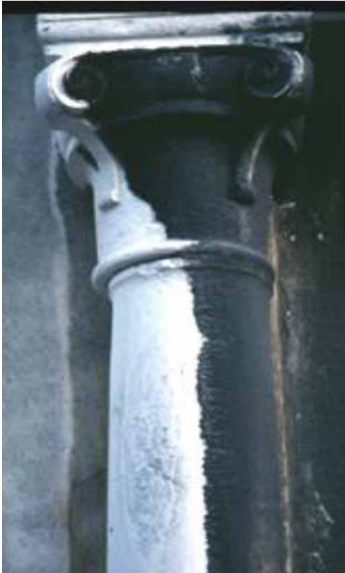
Εικόνα 1.4 Δημιουργία μαύρων δενδριτικών επικαλύψεων (μαύρες κρούστες), Βενετία [1]
