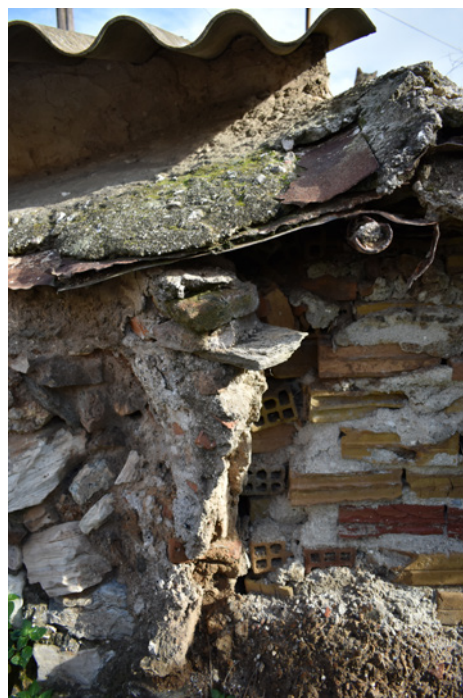
81. Λεπτομέρειες υλικών τοιχοποιίας σήμερα, 2018
