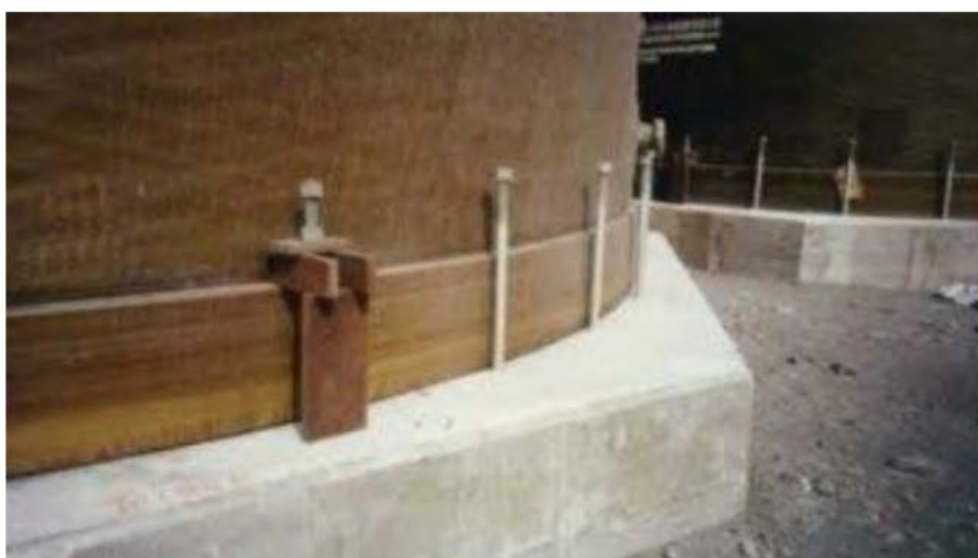
Εικόνα 3.3: Αγκυρωμένη σε θεμέλιο δεξαμενή.
