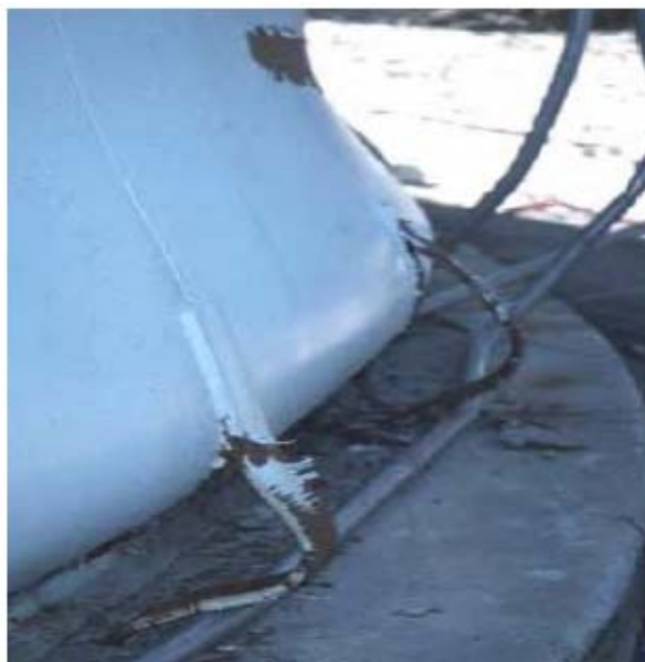
Εικόνα 3.5: Λυγισμός σε σχήμα πέλματος ελέφαντα σε δεξαμενή αποθήκευσης υγρών καυσίμων (1964 magnitude-9.2 Anchorage, Alaska earthquake).
