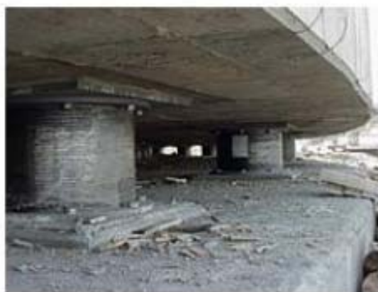
Εικόνα 2.17: Δεξαμενή θεμελιωμένη σε πλάκα με εφέδρανα.
