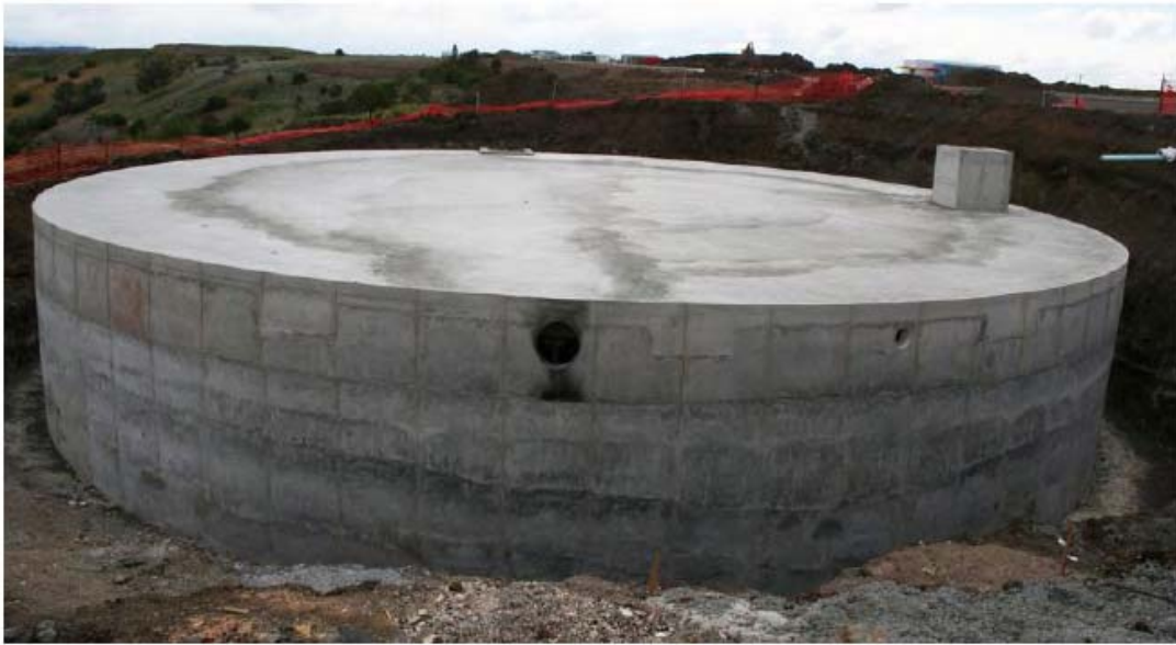
Εικόνα 3.1: Υπόγεια δεξαμενή αποθήκευσης υγρών από οπλισμένο σκυρόδεμα (πριν την επίχωση) ( www.gwp.org ).
