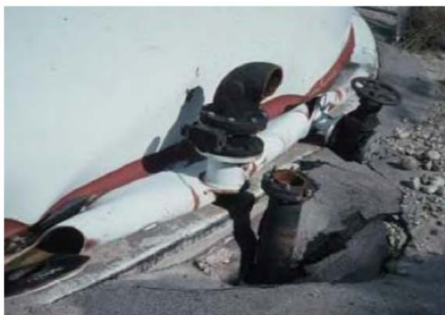
Εικόνα 3.8: Αστοχία σωληνώσεων δεξαμενής μετά από σεισμό (2001 Magnitude-8.4 Peru Earthquake).
