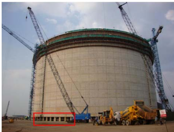
Εικόνα 2.16: Δεξαμενή θεμελιωμένη με πασσάλους.
