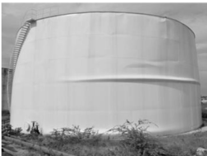
Εικόνα 3.6: Λυγισμός σε σχήμα γονάτου ελέφαντα σε δεξαμενή αποθήκευσης υγρών καυσίμων (FEMA 2012a).
