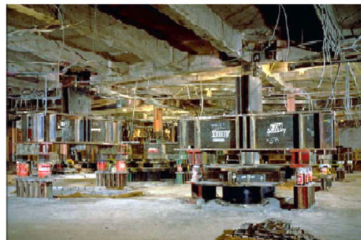
Εικόνα 4.1: Διάταξη εφεδράνων στο επίπεδο της θεμελίωσης στο Δημαρχιακό μέγαρο του San Francisco (Simin Naaseh SE Principal Mason Walters SE Principal 2006).
