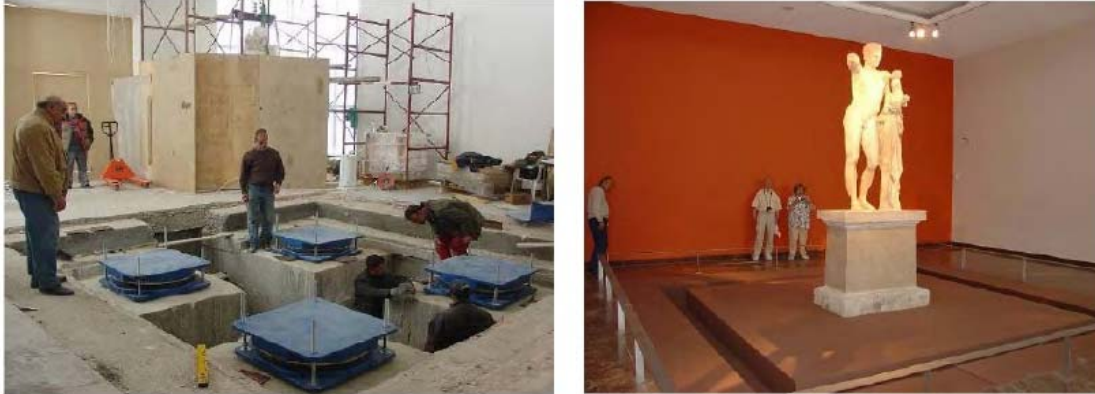
Εικόνα 4.5: Ενίσχυση αγάλματος Ερμή του Πραξιτέλη σε εφέδρανα ανεστραμμένους εκκρεμούς.
