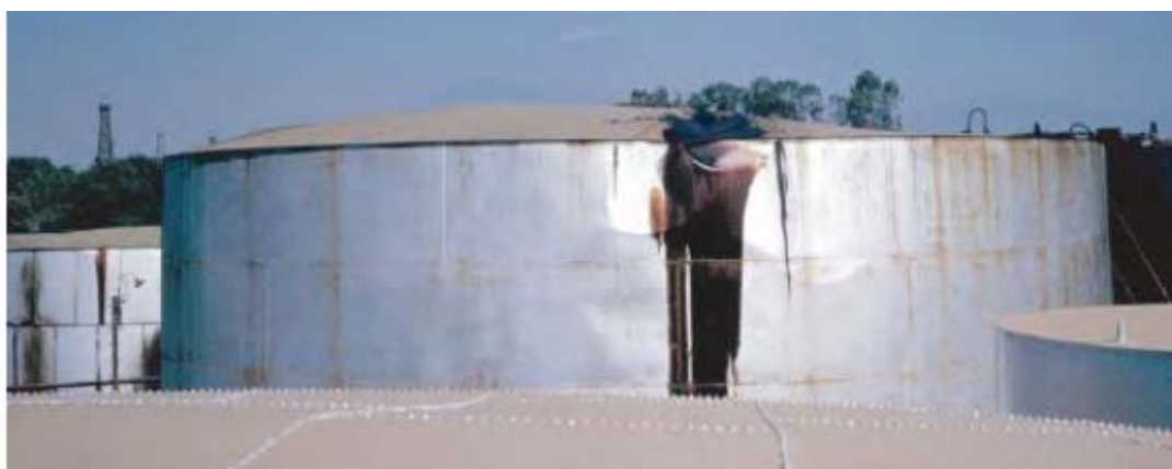
Εικόνα 3.7: Βλάβη σε δεξαμενή στην Καλιφόρνια λόγω κυματισμού του περιεχόμενου υγρού (Northridge earthquake, California).
