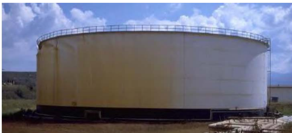
Εικόνα 3.4: Δεξαμενή με λυγισμό μορφής διαμαντιού στο πάνω αριστερό της τμήμα (Northridge earthquake, California).
