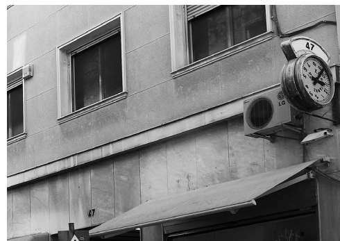
Εικ. 4.γ.9. Η χρήση αρτιφισιέλ στο κτήριο επί της οδού Κολοκοτρώνη 47
