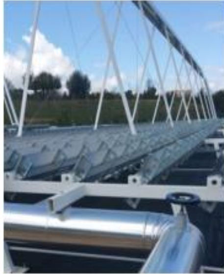
Σχήμα 2-2 Γραμμικός ανακλαστήρας Fresnel στην περιοχή του κτιρίου Arca
