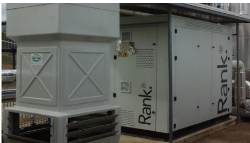
Σχήμα 2-4 Οργανική γεννήτρια και πύργος ψύξης στην κοινότητα του κτιρίου Arca
