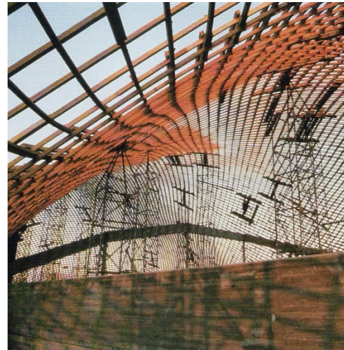
Εικ. 4.17: Φωτογραφία από το εσωτερικό του κελύφους που φαίνονται οι σκαλωσιές που χρησιμοποιήθηκαν για την ανέγερση του.
