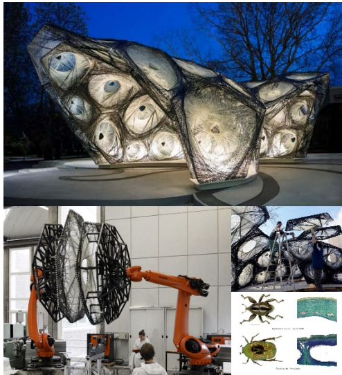
Εικ. 3.2: ICD/ITKE Research Pavilion 2013-14. Ελαφριά κατασκευή από fiberglass και ανθρακόνημα. Αποτελείται από αλληλένδετες κυψέλες που κατασκευάζονται από δυο ρομποτικούς βραχίονες. Η κατασκευή μιμείται την κυτταρική δομή του έλυτρου.
