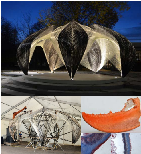
Εικ. 3.3: ICD/ITKE Research Pavilion 2012. Ελαφριά κατασκευή από fiberglass και ανθρακόνημα που μιμείται τη μοριακή δομή του εξώσκελετού των μαλακόστρακων. Υλοποιείται αποκλειστικά από ρομποτικό βραχίονα.
