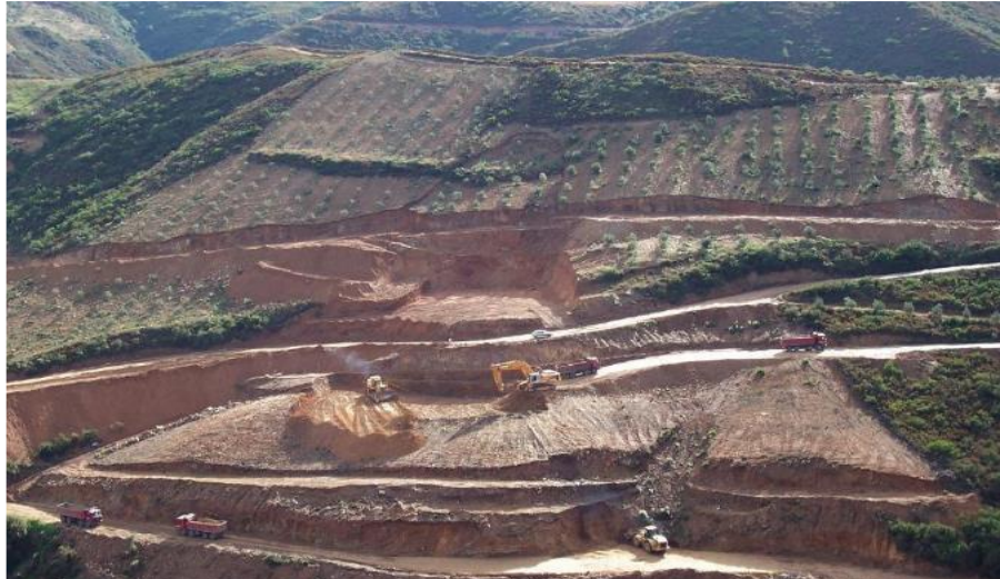
Φωτογραφία 5: Άποψη του δεξιού αντερείσματος κατά την διάρκεια εκτέλεσης των εργασιών διαμόρφωσης του.
