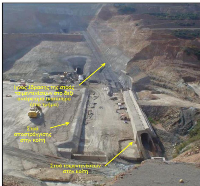
Φωτογραφία 3: Κατασκευή στοάς τσιμεντενέσεων και στοάς αποστράγγισης.
