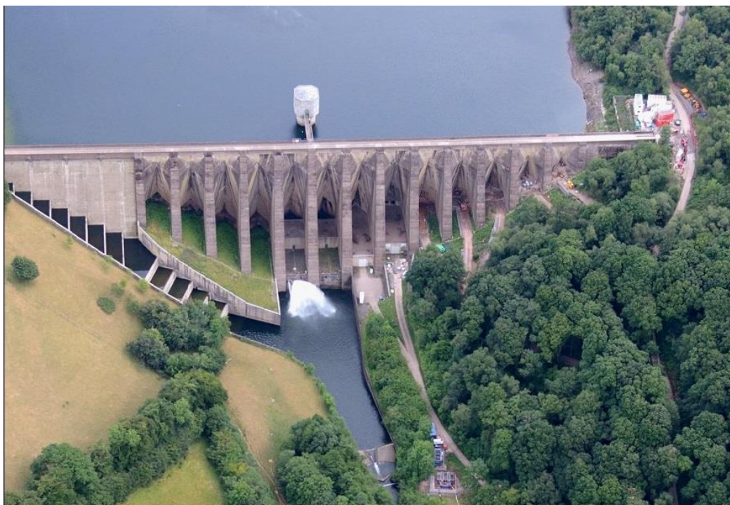
Φωτογραφία 1: Αντηριδωτό φράγμα Wimbleball στην Αγγλία ( https://twitter.com/bachysoletanche ).
